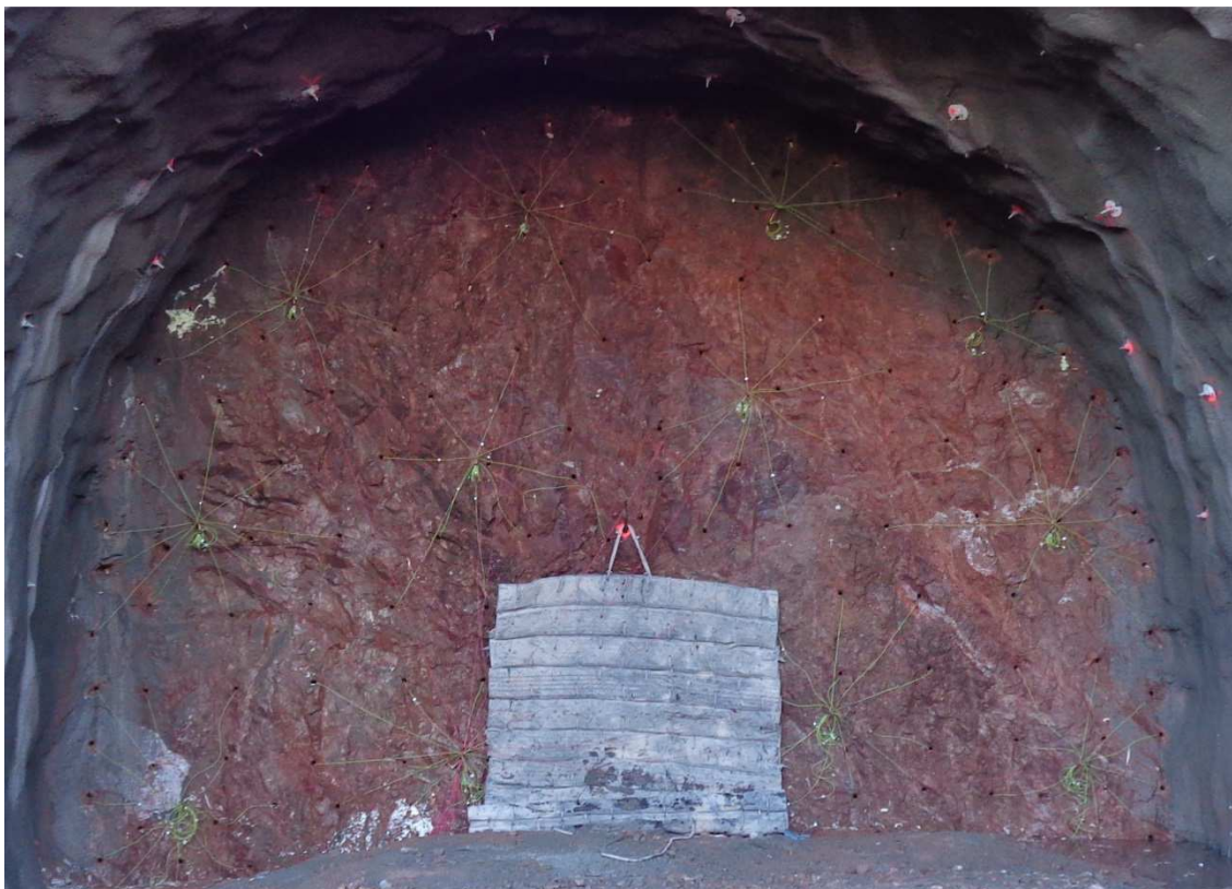
Obr. 2.23: Svazky detonačních trubiček z rozbušek spojené bleskovicí [23]
