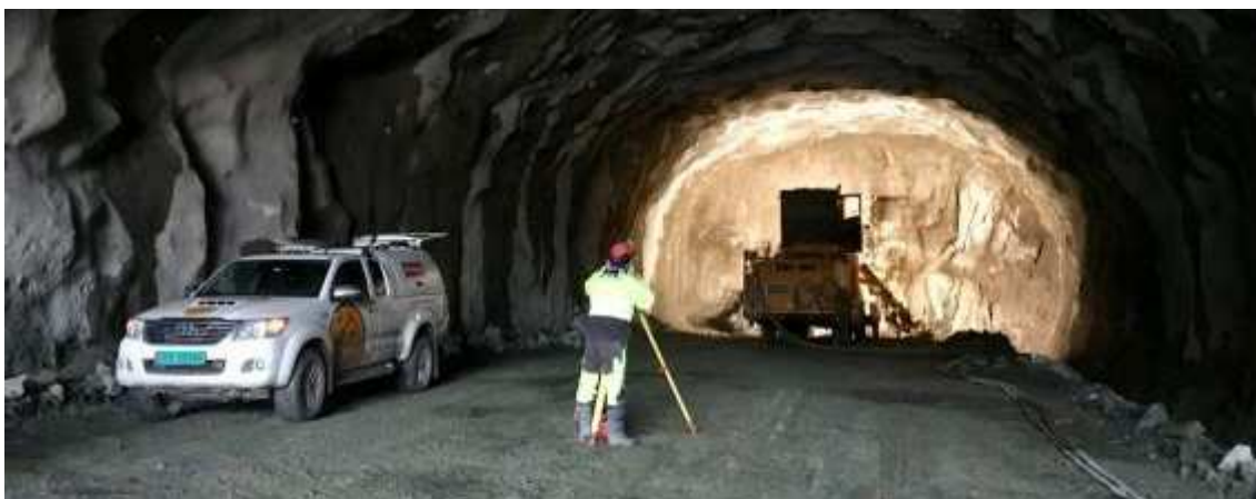
Obr. 2.9: Navigace vrtného vozu pomocí totální stanice [23]
