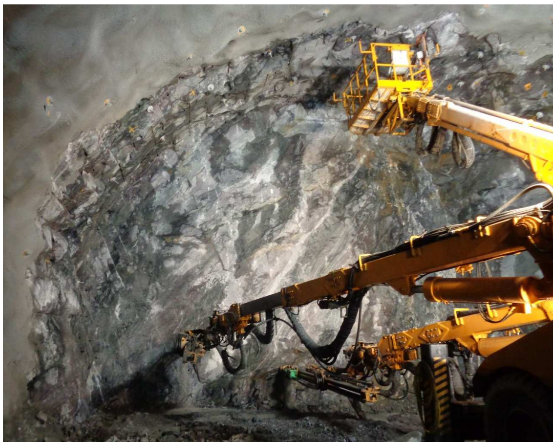
Obr. 2.12: Vrtání čelby vrtným vozem AMV 21SGB-CC [23]
