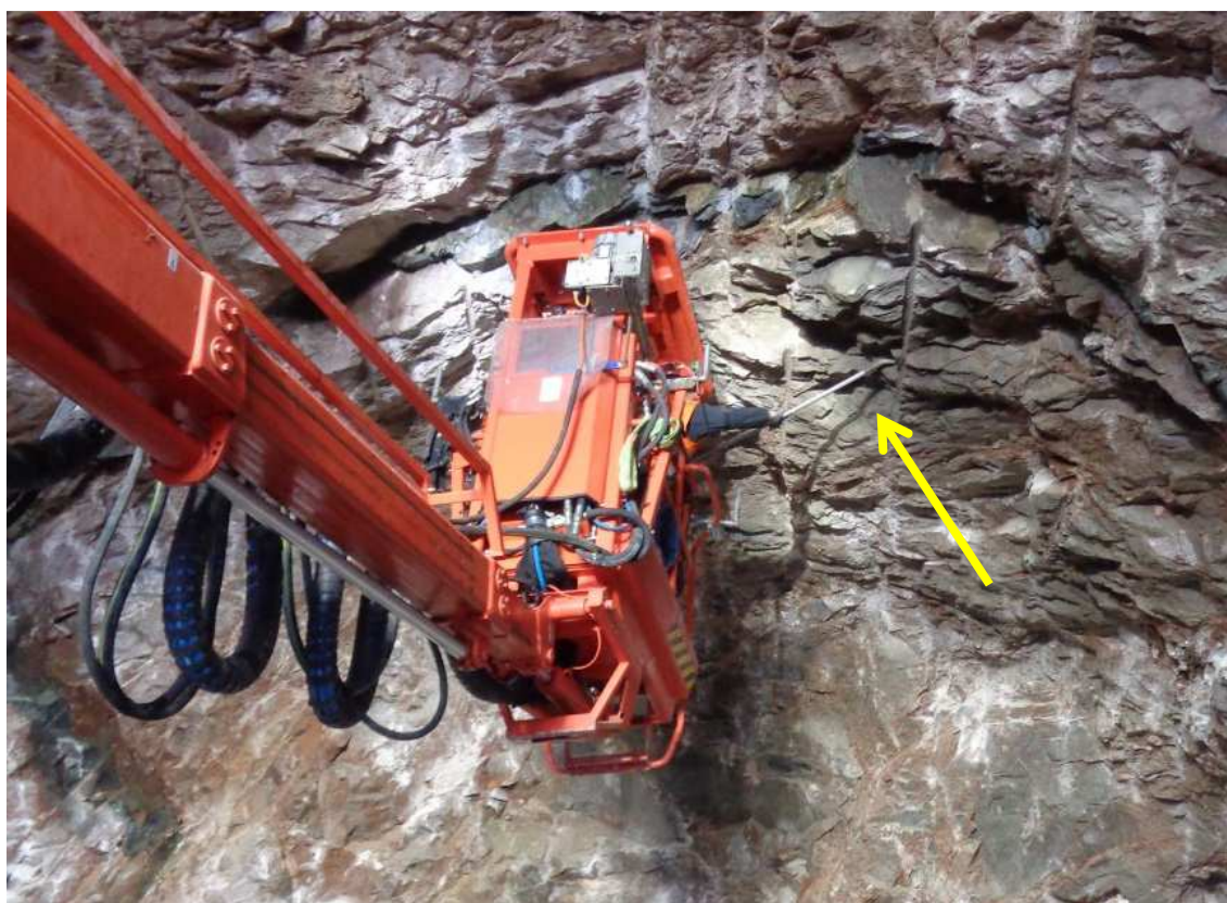
Obr. 2.31: Ruční začištění výrubu pomocí obtrhávací tyče [23]
