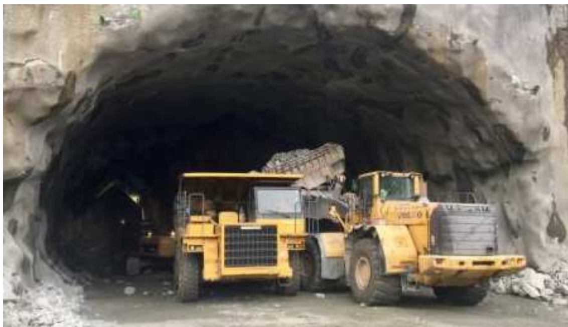
Obr. 2.29: Nakládání rubaniny do dumperu Komatsu HD325 [23]
