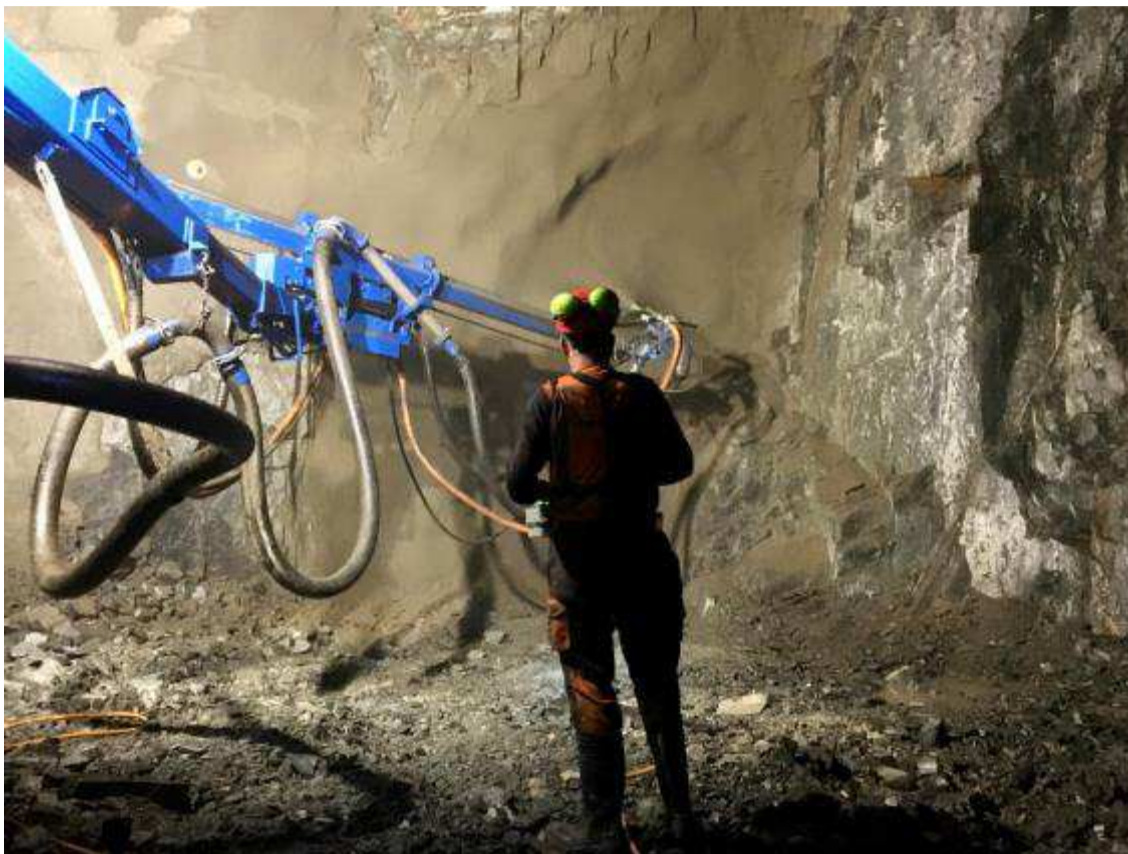
Obr. 2.34: Nástřik betonu pomocí dálkově ovládaného ramena s tryskou [23]
