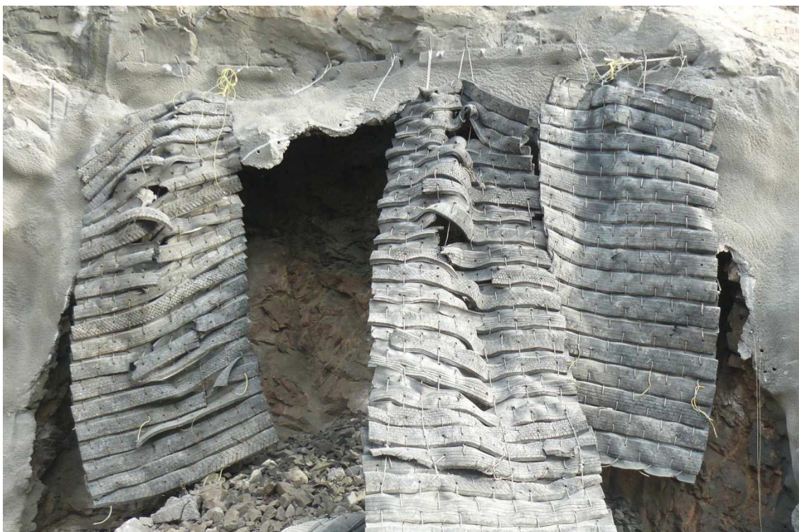
Obr. 2.26: Čelba zakrytá gumovými matracemi po provedení odpalu [23]
