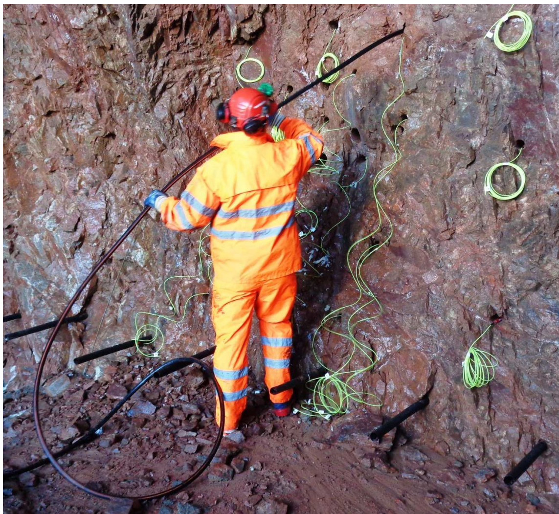
Obr. 2.22: Nabíjení čelby emulzní trhavinou [23]
