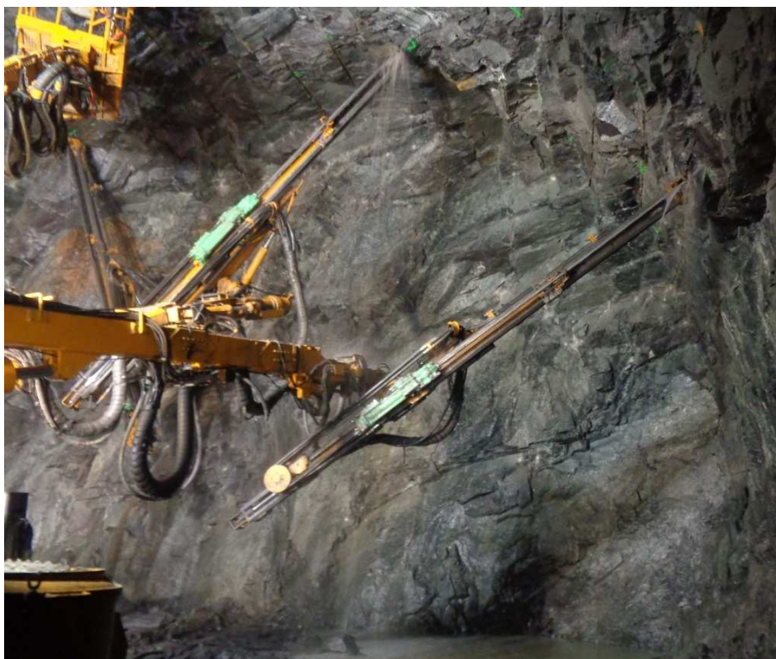
Obr. 2.36: Vrtání otvorů pro svorníky [23]
