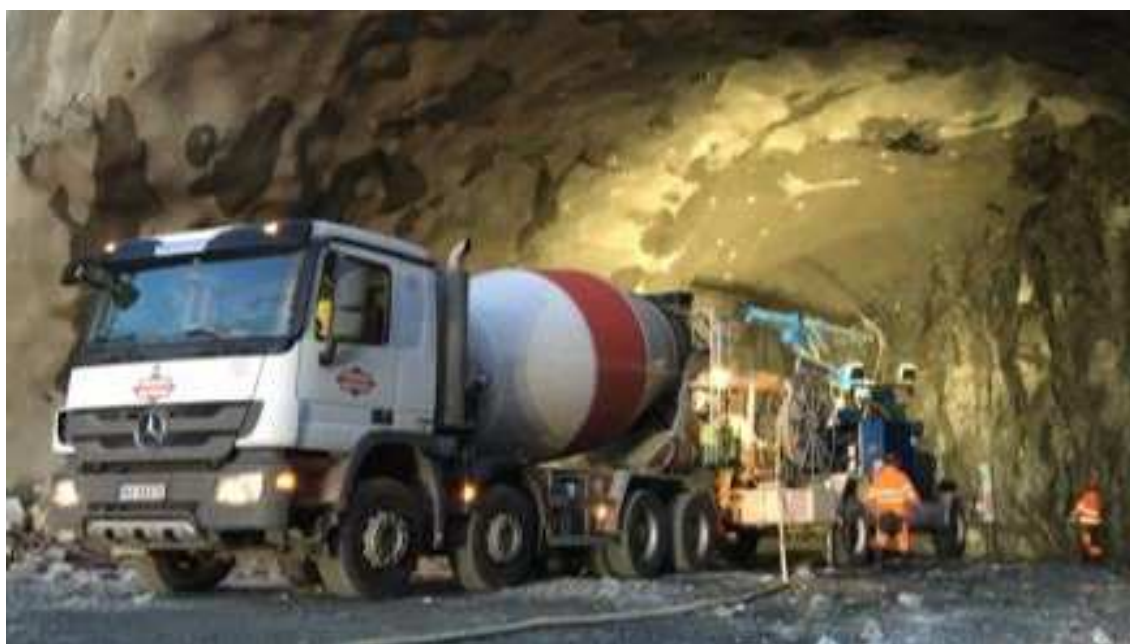
Obr. 2.33: Autodomíchávač a Meyco Potenza při nástřiku betonu [23]
