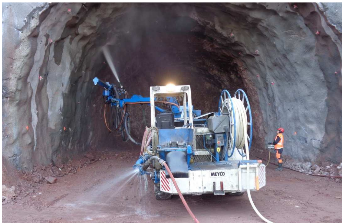
Obr. 2.32: Omytí výrubu tlakovou vodou pomocí stroje Meyco Potenza [23]
