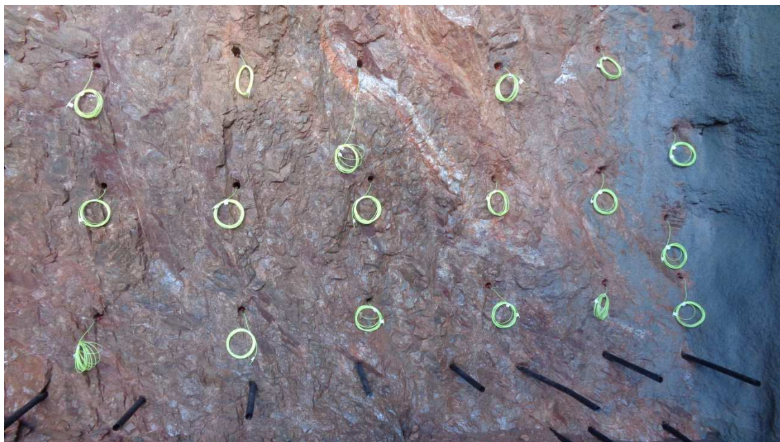
Obr. 2.21: Rozbušky s počiny rozmístěné v příslušných vrtech [23]
