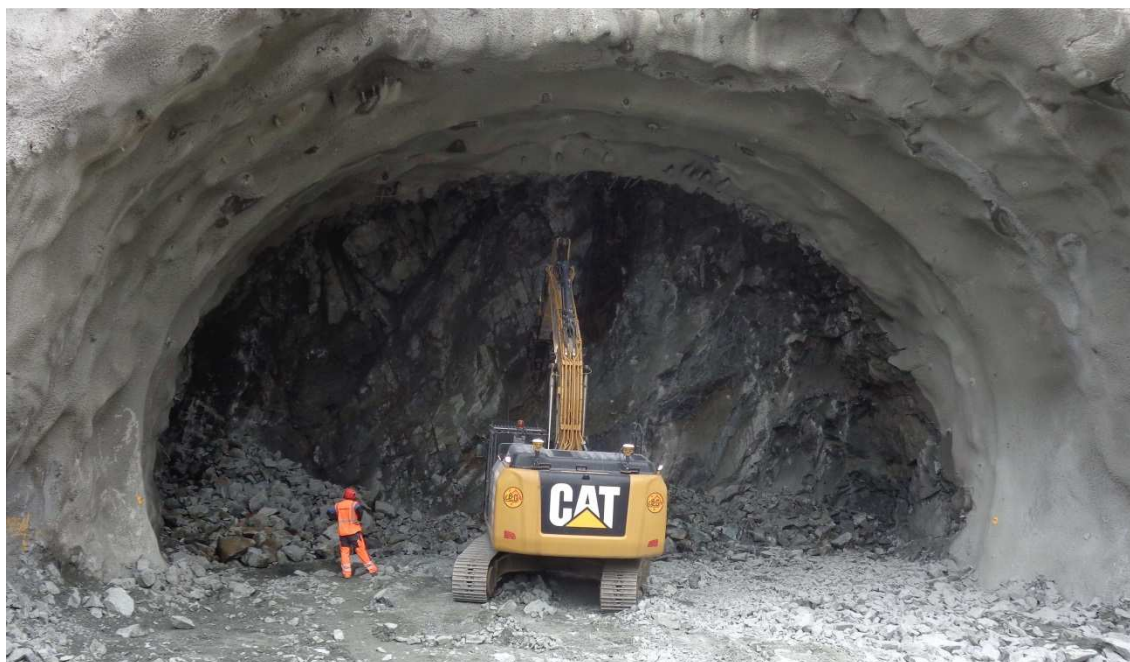
Obr. 2.30: Mechanické začištění čelby pomocí bagru CAT 323D [23]
