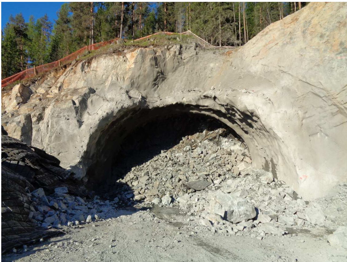
Obr. 2.4: Pohled na východní portál tunelu Moane [23]
