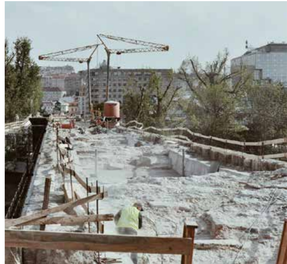
REKONŠTRUKCIA NEGRELLIHO VIADUKTU - APRÍL 2018
