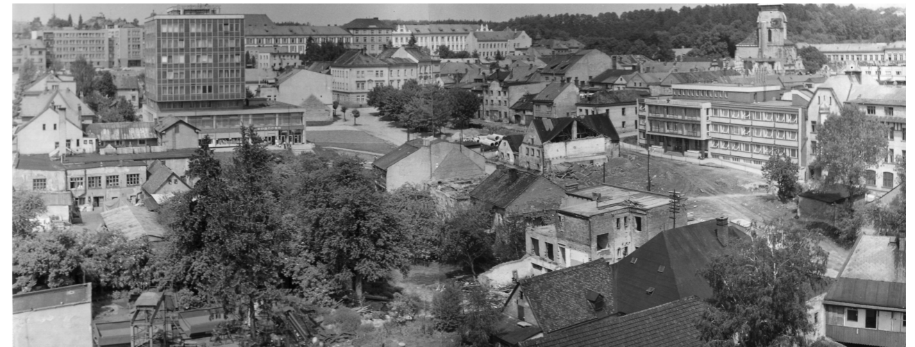
020 Pohled na Smetanovo náměstí v průběhu asanace. Vlevo již stojí administrativní budova škrobáren.
