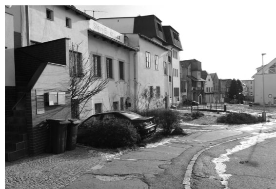
005 Zadní trakty gotických domů. Na soukromých pozemcích jsou umístěny předzahrádky či plácky pro parkování aut. V některých domech jsou umístěny služby. [Česká republika, Havlíčkův Brod]
