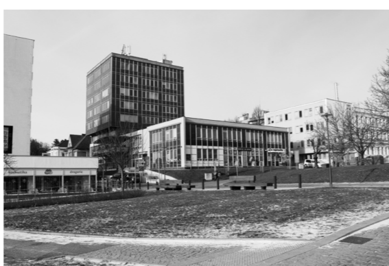
008 Administrativní budova „Skleňák“. [Česká republika, Havlíčkův Brod]
