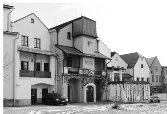
006 Zadní trakt budovy Galerie výtvarného umění a Muzea Vysočiny. [Česká republika, Havlíčkův Brod]
