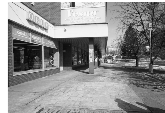
010 Podnož se službami přiléhající k parku na Smetanově náměstí. [Česká republika, Havlíčkův Brod]
