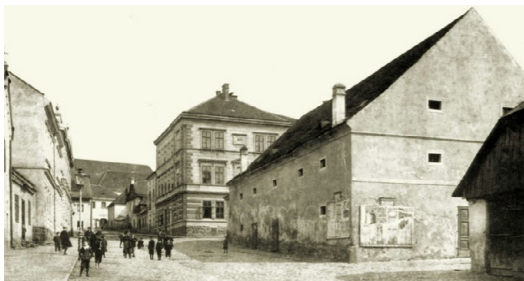
017 Bývalá solnice sloužící jako městské divadlo
