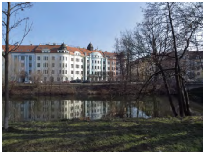
1 - pohled na Čechovo nábřeží
