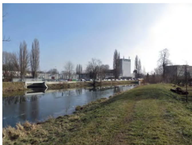
5 - pohled přes Chrudimku z levého břehu k mlýnům fotodokumentace území
