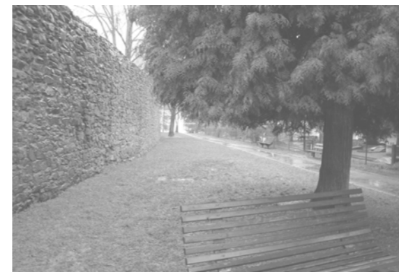
Severní hradby u ulice Langrova
