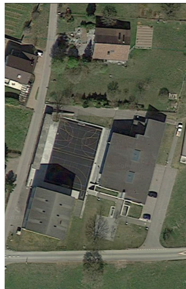
Obr. 15: Letecký pohled na areál školy
