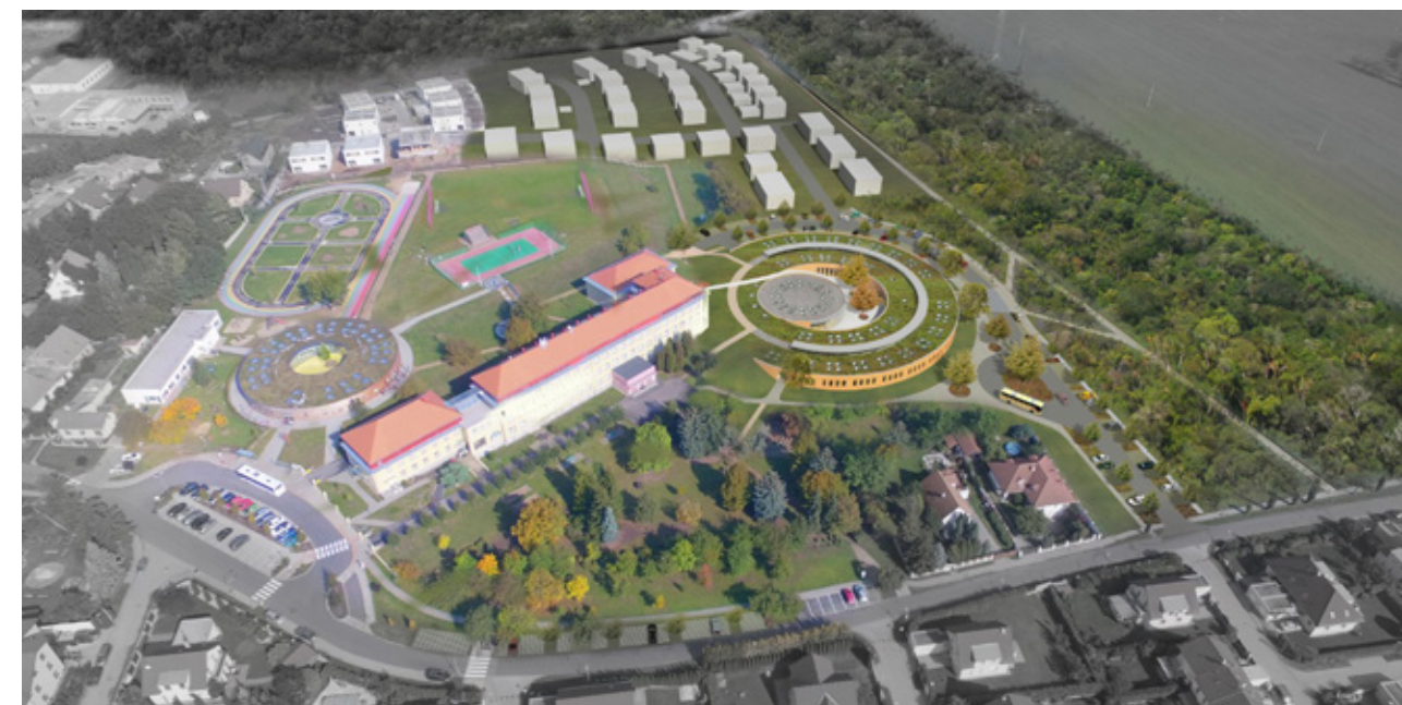
Obr. 41: Nadhled - nová budova vpravo, ZŠ z roku 2015 vlevo, původní škola uprostřed, sportoviště v pozadí
