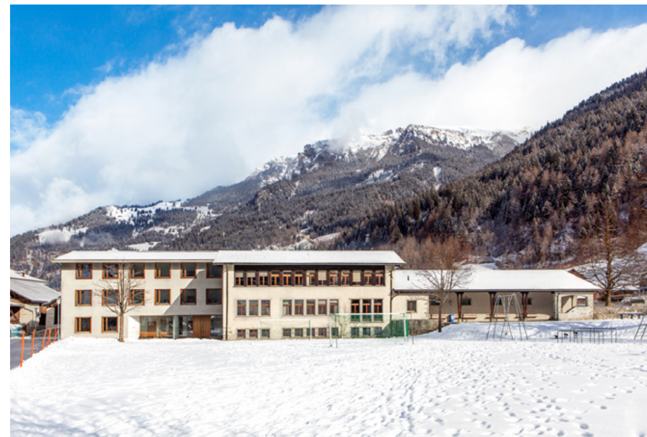
Obr. 21: Pohled z fotbalového hřiště k hlavnímu vstupu
