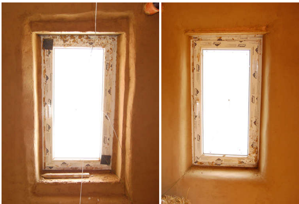
Obrázek 25: Vnitřní ostění oken provedené četou AMATER (vlevo) a ZASKOLENI (vpravo)
