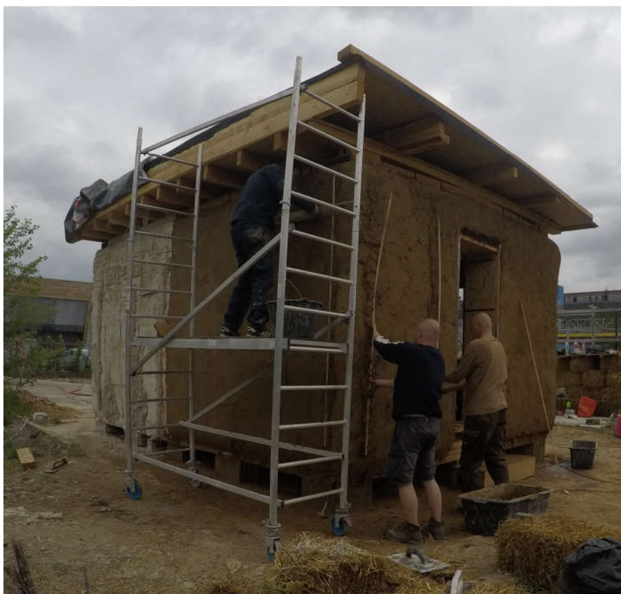
Obrázek 18: Osazování omítníků na ST 5, stržení povrchu latí na ST 6
