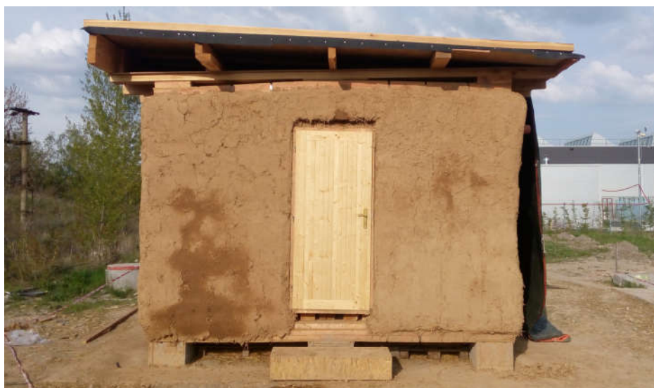
Obrázek 15: Západní stěna objektu po provedení vyrovnávací vrstvy
