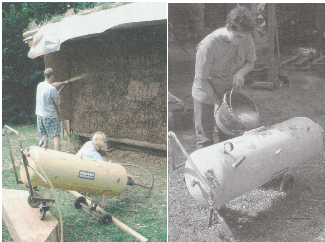
Obrázek 4: Ukázky práce se svépomocně zhotovenou stříkačkou na maltu (převzato z [Minke])
