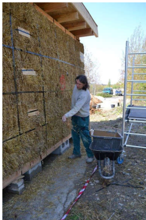
Obrázek 11: Nanášení hliněného podhozu četou PROFÍ
