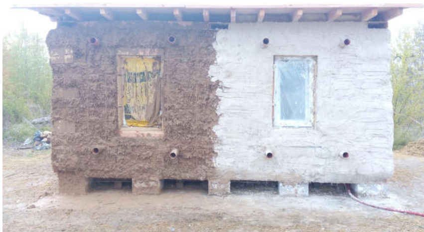
Obrázek 14: Jižní stěna objektu po provedení hliněného podhozu
