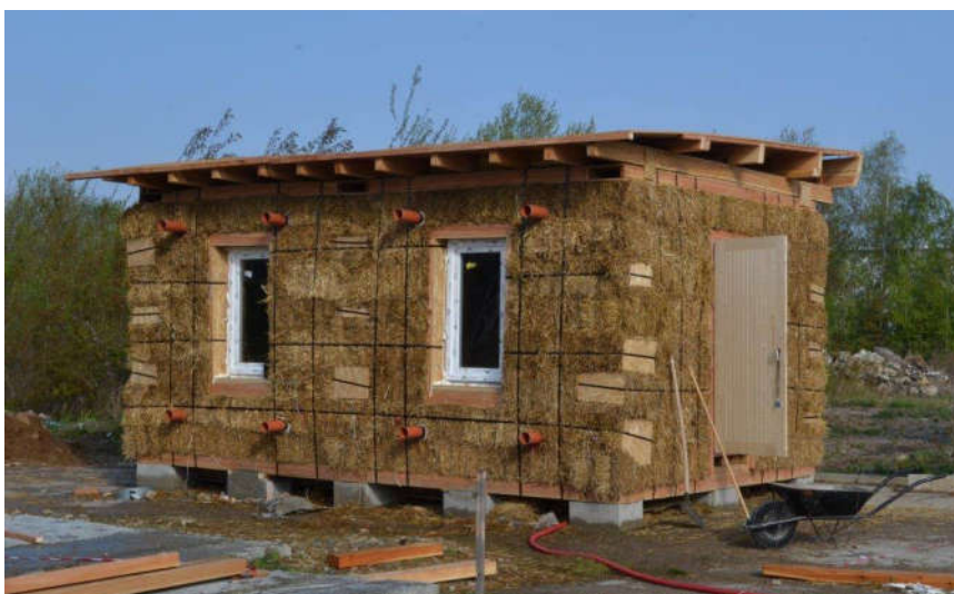
Obrázek 12: Jihovýchodní pohled na objekt před začátkem omítání
