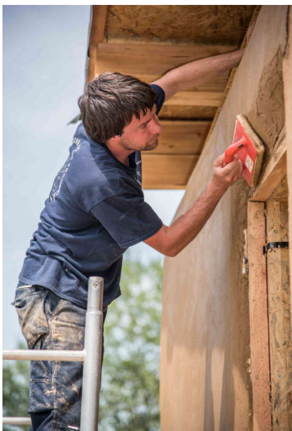
Obrázek 22: Úprava detailu u ostění dveří hladítkem
