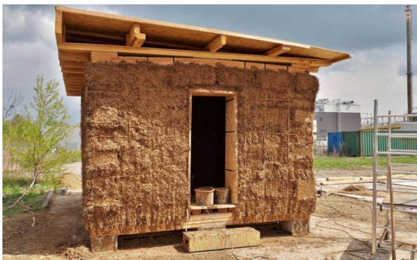
Obrázek 13: Západní stěna objektu po provedení hliněného podhozu
