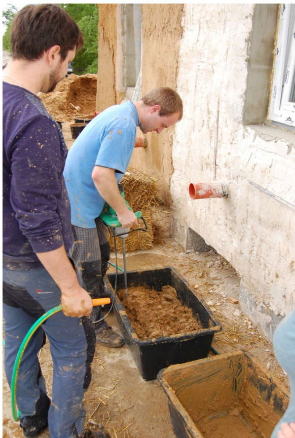
Obrázek 17: Příprava materiálu z pytlované směsi četou ZASKOLENI
