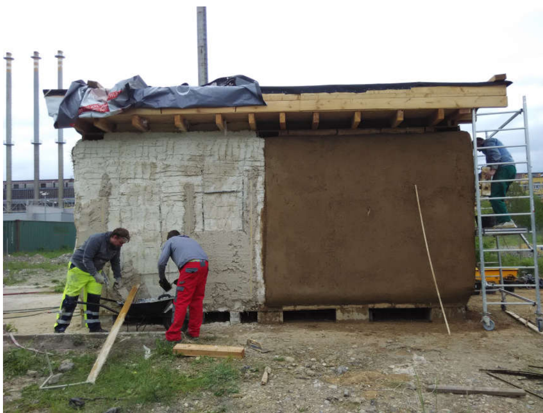
Obrázek 19: Severní stěna objektu s dokončenou hrubou hliněnou omítkou
