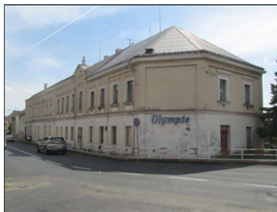
Foto /3/ Aktuální pohled na objekt
