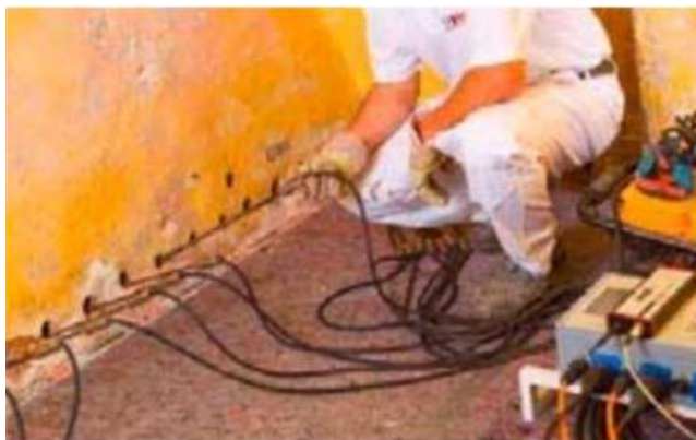
Obr. 41 Vyhřívání vrtů ve zdivu [35]
