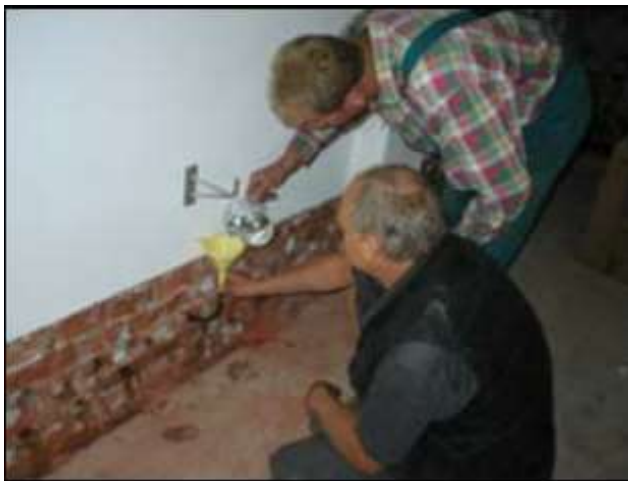
Obr. 37 Příklad beztlakové injektáže [41]
