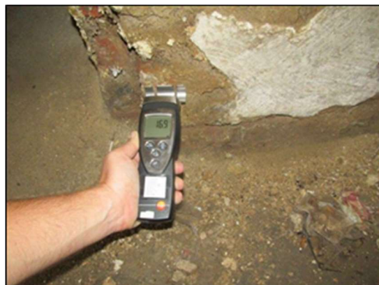
Foto /11/ Orientační měření vlhkosti zdiva
