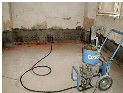
Obr. 39 Čerpadlo pro tlakovou injektáž zdiva [42]
