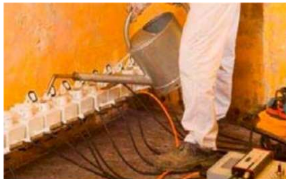
Obr. 42 Plnění připravených vrtů parafínem [35]
