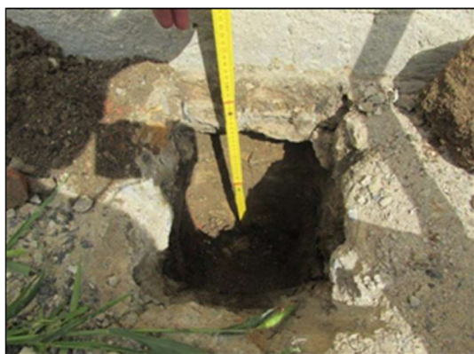
Foto /18/ Pohled do provedené sondy
