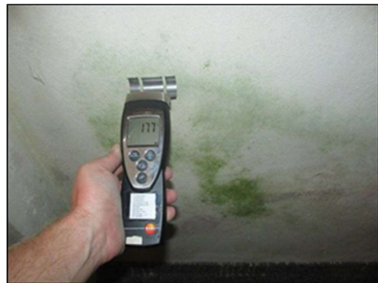
Foto /7/ Orientační měření vlhkosti zdiva
