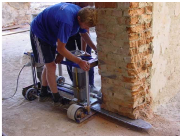
Obr. 46 Podřezání zdiva pilou s pojezdem stroje [27]
