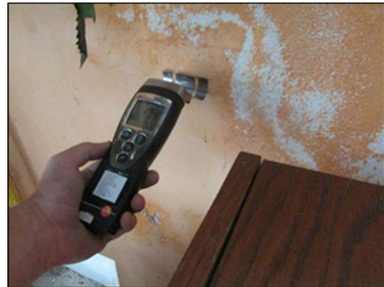
Foto /5/ Orientační měření vlhkosti zdiva
