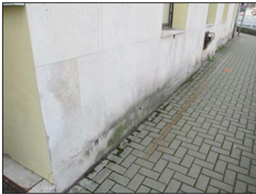
Foto /14/ Pohled na severní část objektu
