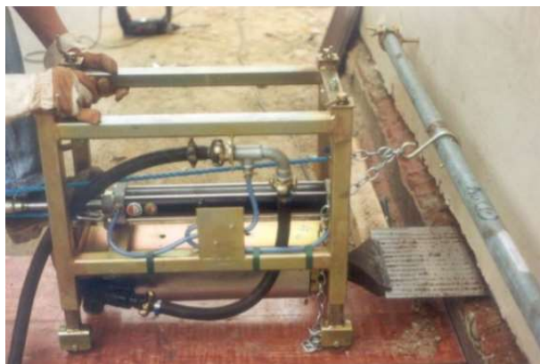
Obr. 48 Vkládání izolace zarážením desek [37]
