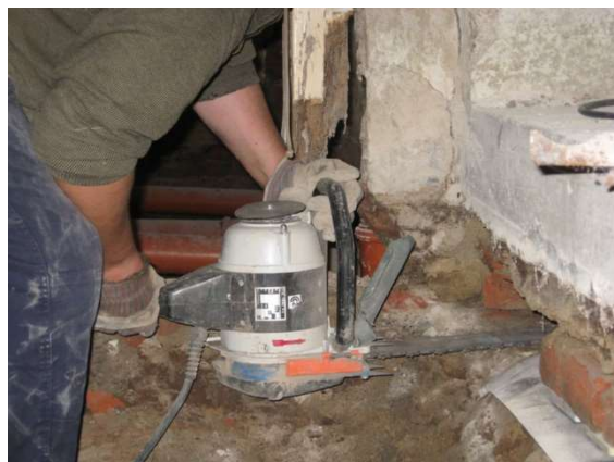
Obr. 45 Ruční podřezání zdiva [36]
