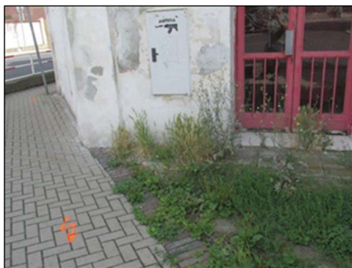
Foto /16/ Pohled na vstup do objektu na
