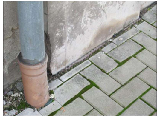
Foto /15/ Ukončení okapového svodu a nopová fólie u spodní části objektu
