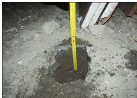
Foto /13/ Pohled do sondy S2
