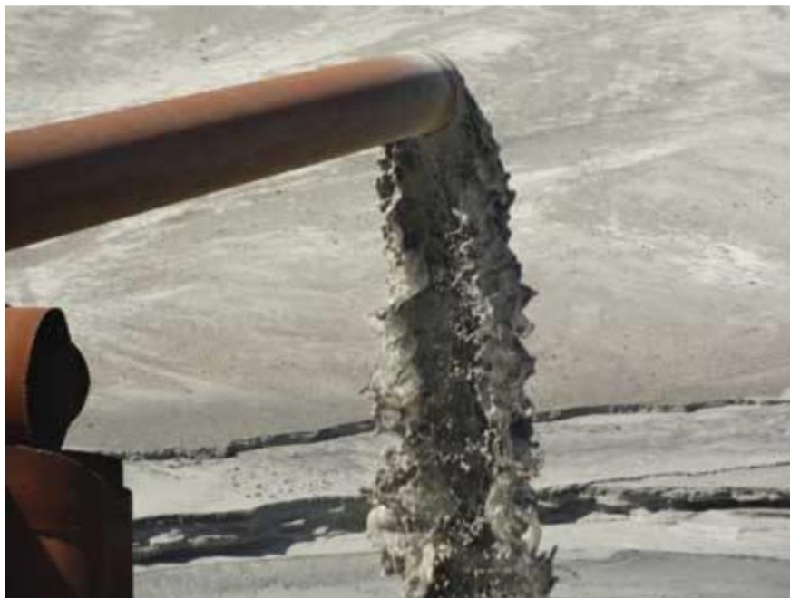
Obr. 2: Doprava hydrosměsi na odkaliště [2]
