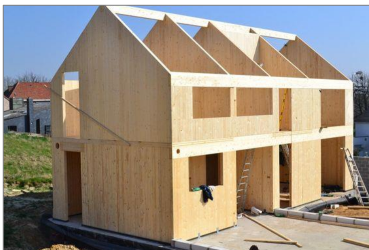
Obr. č. 27 – Dřevostavba z CLT panelů
