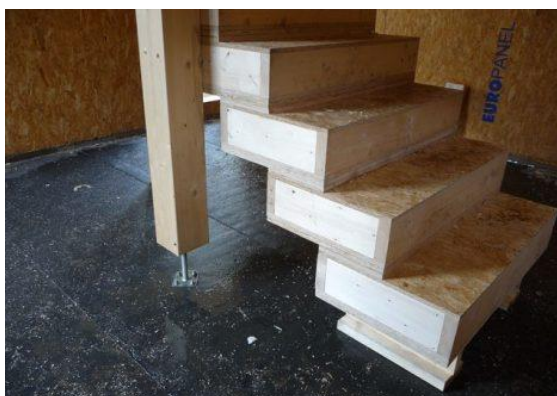
Obr. č. 26 – Schodiště ze SIPs panelů
