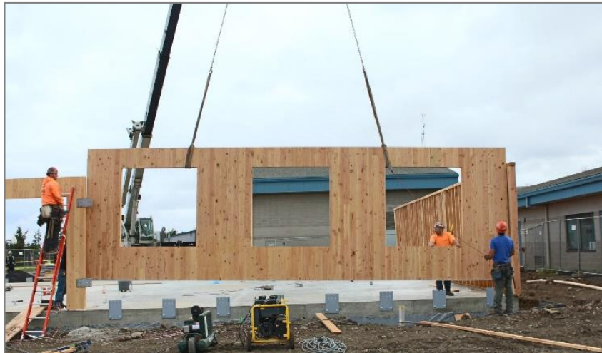
Obr. č. 29 – Montáž dřevostavby z CLT panelů
