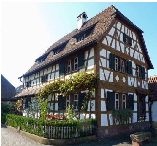
Obr. č. 1 – Hrázděná dřevostavba
