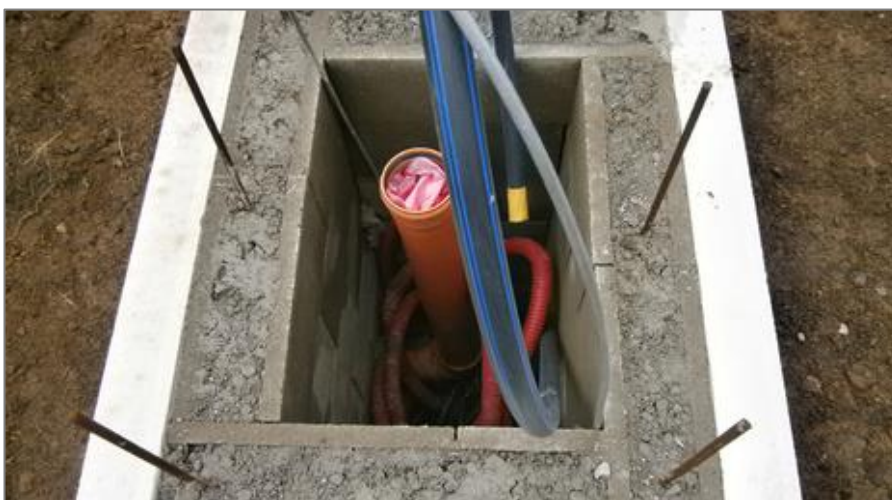
Obr. č. 44 – Instalace v instalační šachtě
