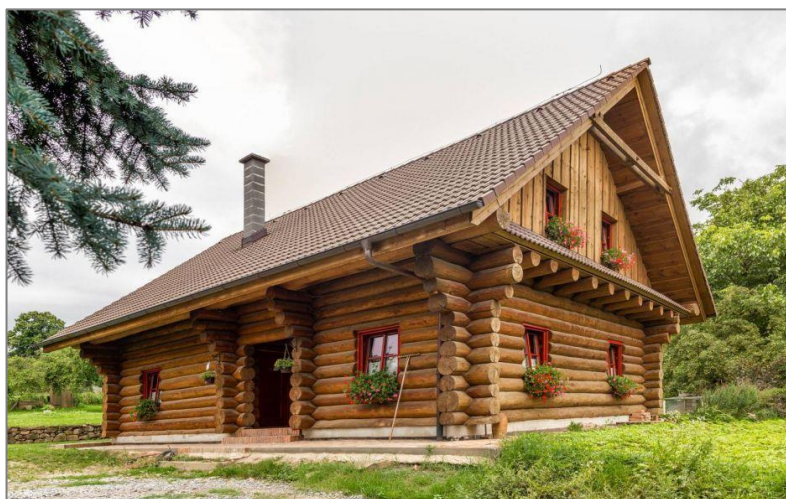
Obr. č. 10 – Srubová stavba
