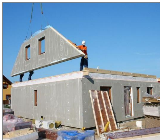
Obr. č. 22 – Montáž dřevostavby
