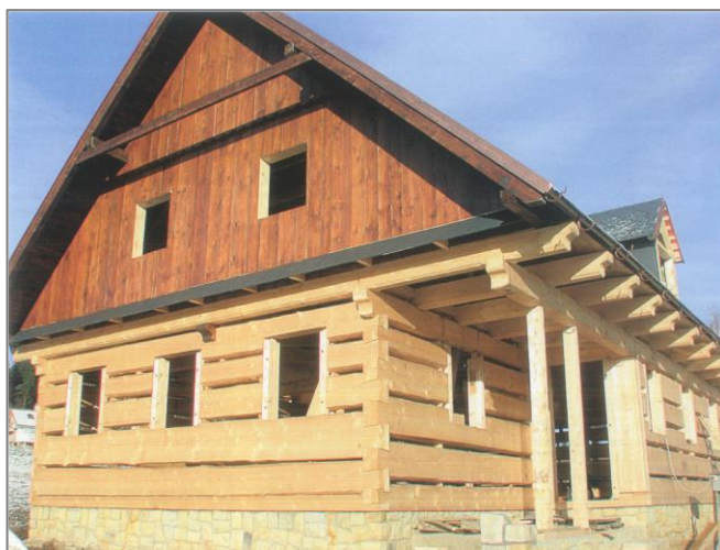
Obr. č. 12 – Konstrukce srubu z mokrého dřeva
