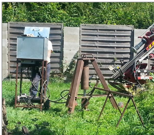
Obr. č. 35 – Provádění tahové zkoušky
