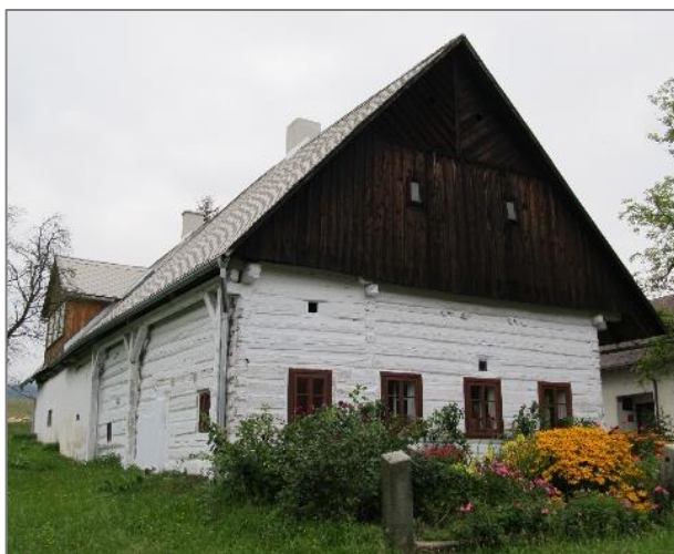
Obr. č. 5 – Roubená stavba č.p. 53
