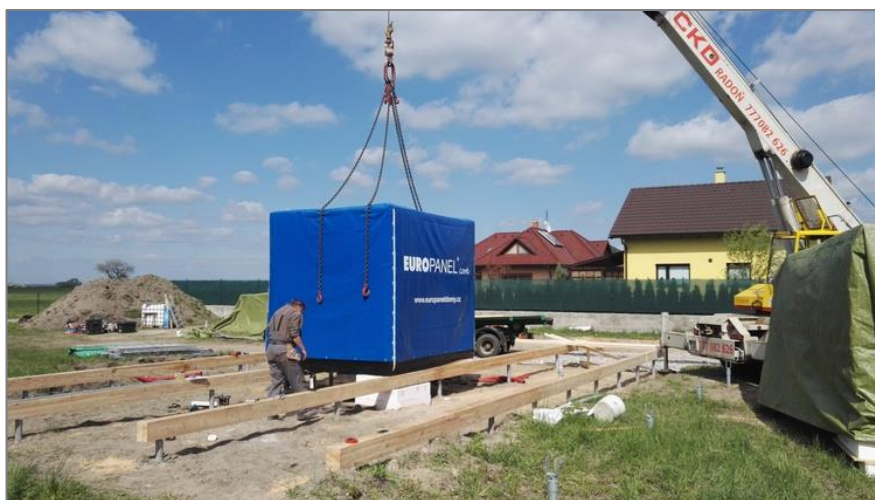
Obr. č. 43 – Osazení instalačního prefabrikovaného jádra
