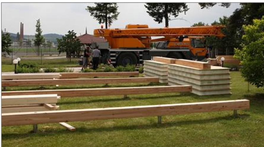
Obr. č. 36 – Zemní vruty s modřínovými KVH hranoly
