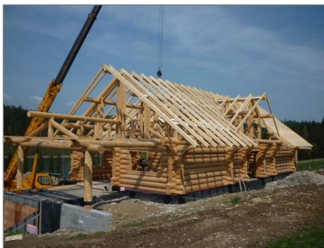
Obr. č. 11 – Montáž srubové stavby
