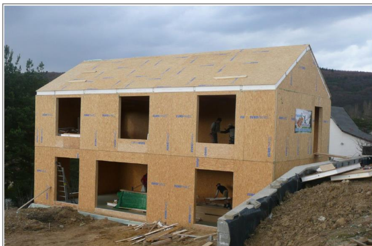
Obr. č. 24 - Dřevostavba ze SIP panelů
