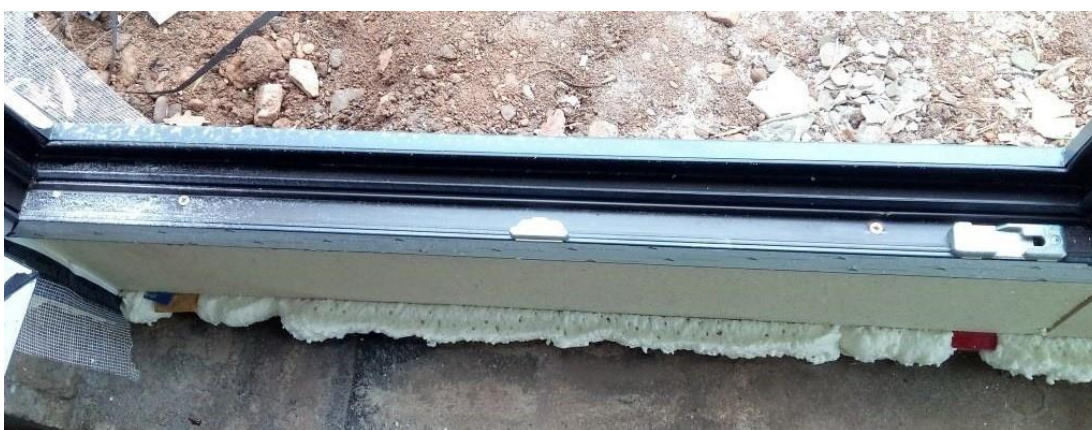
Obrázek 7 Detail kotvení výplní otvorů (zdroj: autor)
