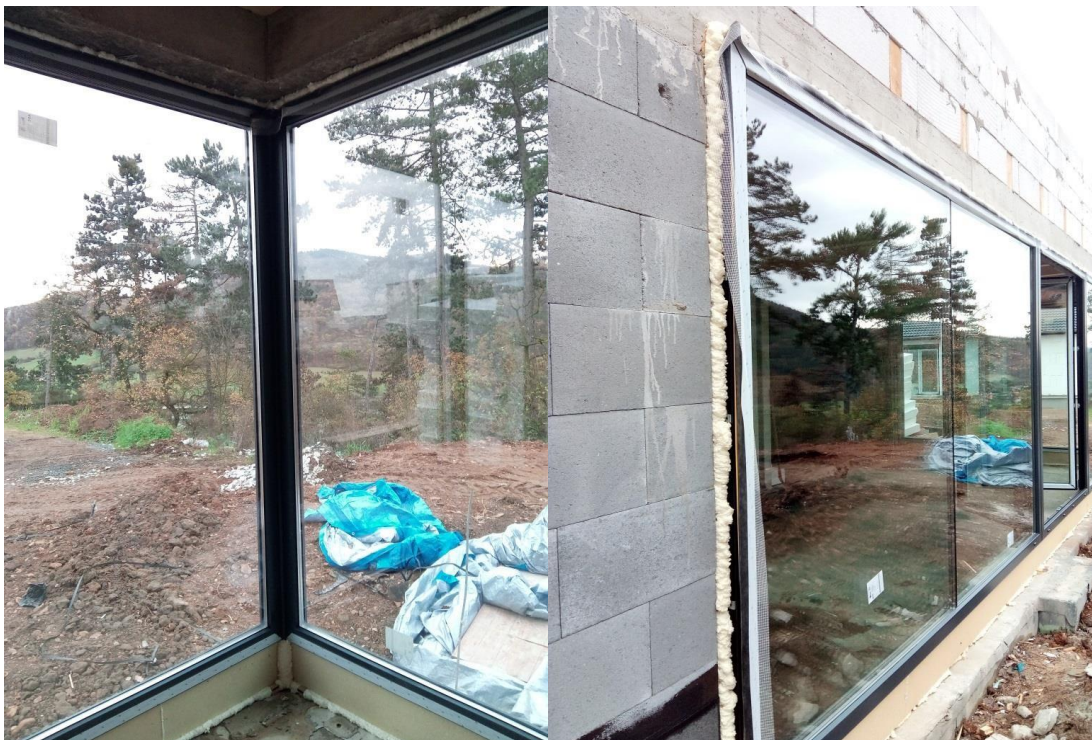
Obrázek 6 Vadná dodávka výplní otvorů (zdroj: autor)
