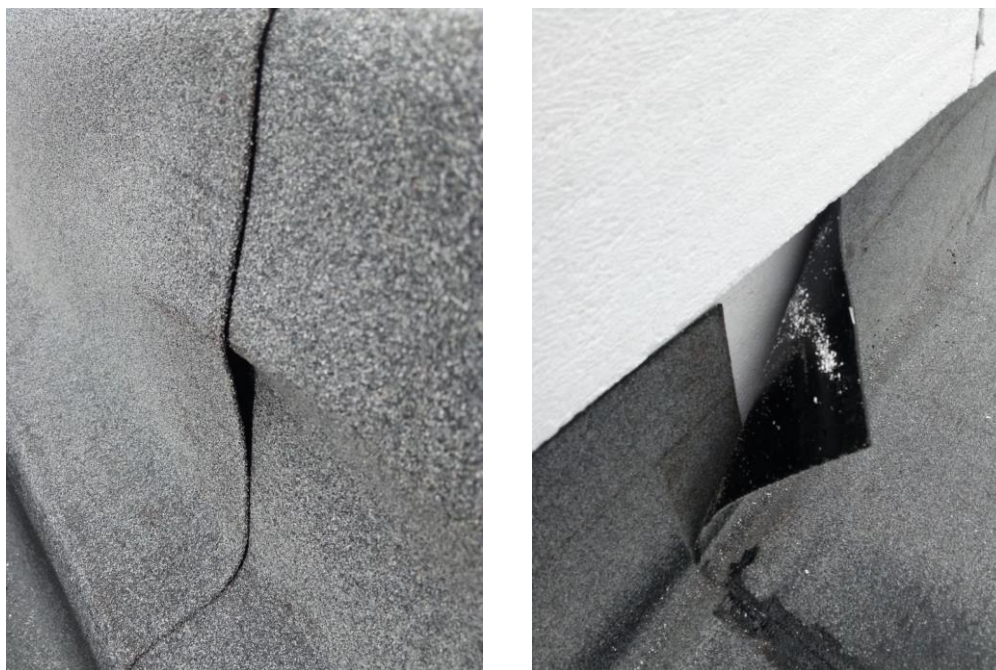
Obrázek 4 Vady parotěsné izolace (zdroj: autor)
