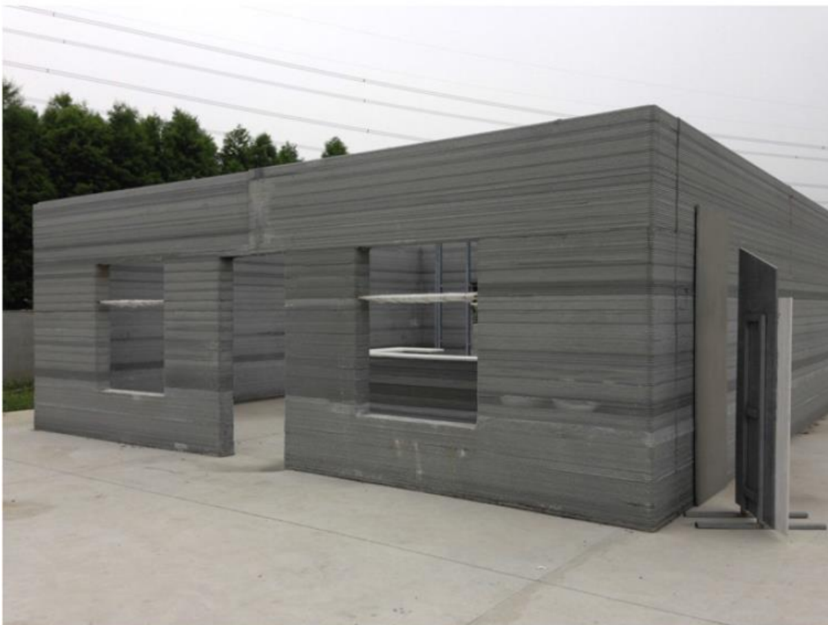
Obrázek 11 – 3D vytištěná vila, WinSun, 2014, Zdroj: [21]
