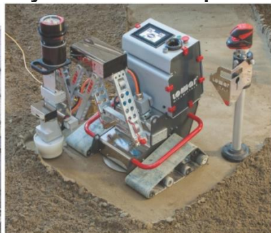
Obr.22. Robot na hutnění betonu
