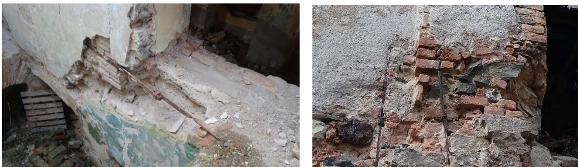
Obrázek 29– obnažené zední kleště fungující jako princip horizontálního ztužení
