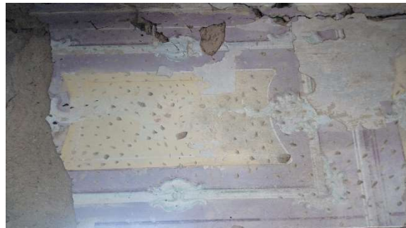
Obrázek 22– zbytky rokokové omítky [vytvořeno autorem]]
