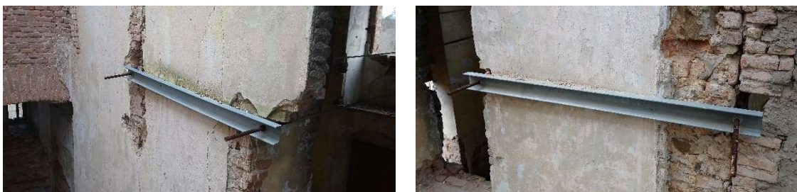
Obrázek 28– uložení táhel na S straně kaple, 2.NP [vytvořeno autorem]
