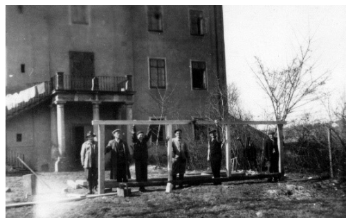
Obrázek 15– pohled na východní fasádu s balkonem [14]
