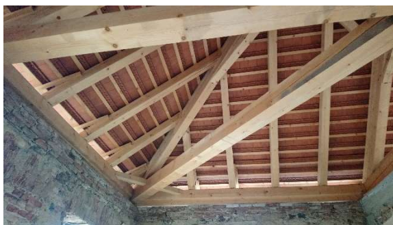
Obrázek 19– pohled na část nově provedené střechy [vytvořeno autorem]
