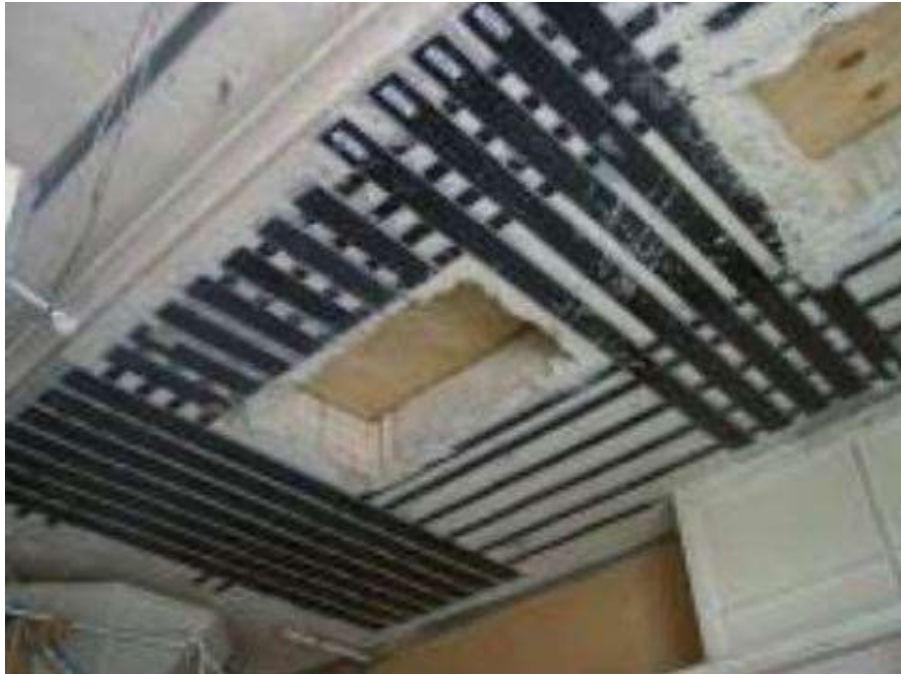
Obrázek 10– vyztužení desky kolem dodatečného otvoru [9]
