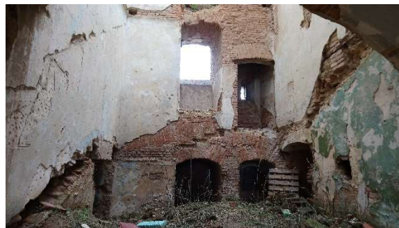
Obrázek 20– střední schodišťový trakt [vytvořeno autorem]
