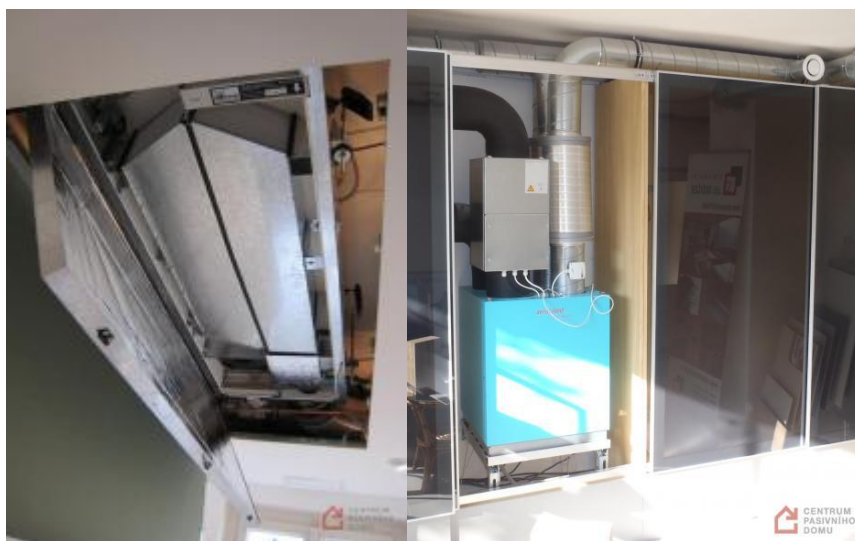
Obr.č.16 Umístění jednotky v podhledu a v interiéru do skříně [12]
