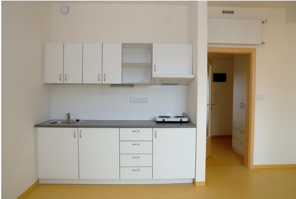
Obr. č.21 Otopné těleso v místě nadedvěrní vyústky Pasivní bytový dům pro seniory Modřice. Zdroj: Stavba roku
