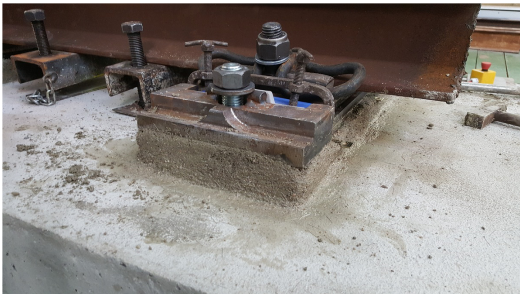
Obrázek č. 14: Podbetonávka bezpražcového uložení z MSK
