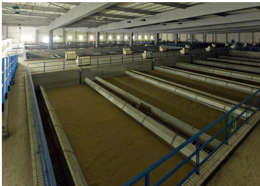
Obrázok č.2.2.5.2.2 - Otvorený pieskový rýchlofilter [30]
