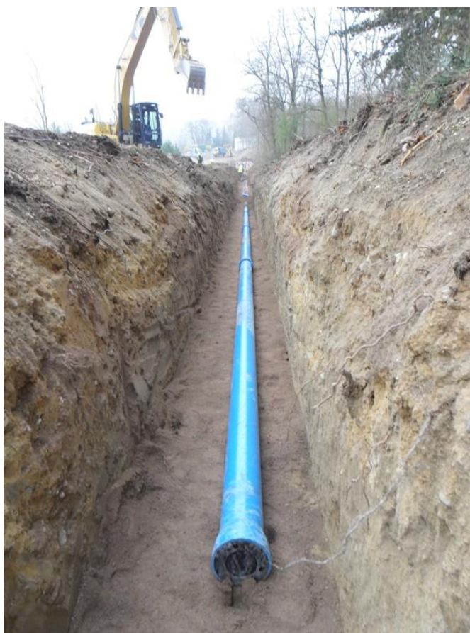
Obrázok č.2.1.6.2.2 - Pokladanie vodovodného potrubia [19]
