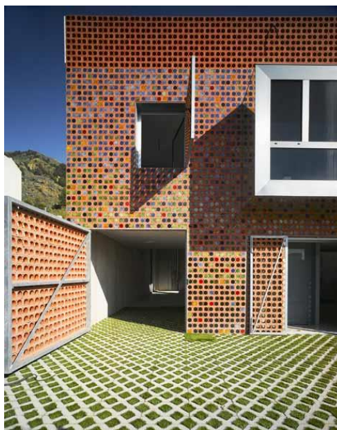
Obrázek 24 Dům v Murcii, Španělsko, fasáda tvořená z keramických stojanů na víno [13]
