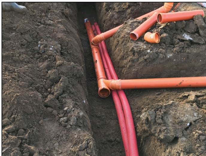
Obrázek 15 - Ležatá kanalizace (zdroj autor)
