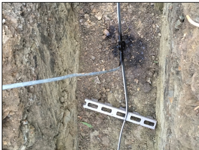
Obrázek 10 - Antikoroziní nástřík (zdroj autor)
