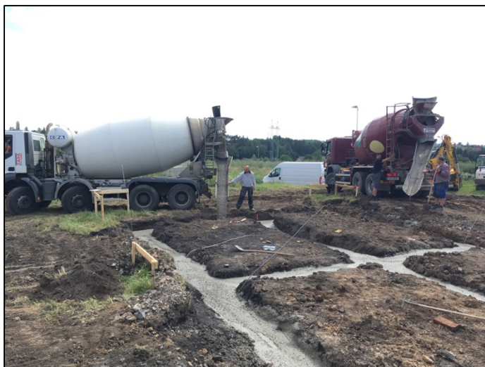
Obrázek 13 - Betonáž základových pasů autodomíchávačem (zdroj autor)
