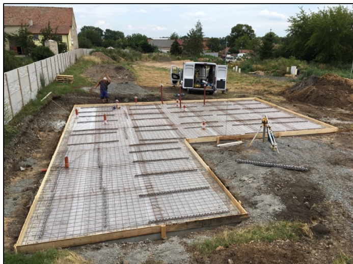
Obrázek 28 - Armování, kari síť na distančních podložkách (zdroj autor)
