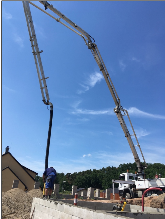
Obrázek 21 - Betonáž ztraceného bednění pomocí beton pumpy (zdroj autor)
