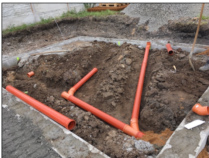
Obrázek 16 - Ležatá kanalizace 2 (zdroj autor)
