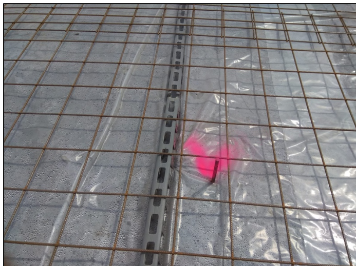
Obrázek 30 - Prostorové výšky základové desky (zdroj autor)
