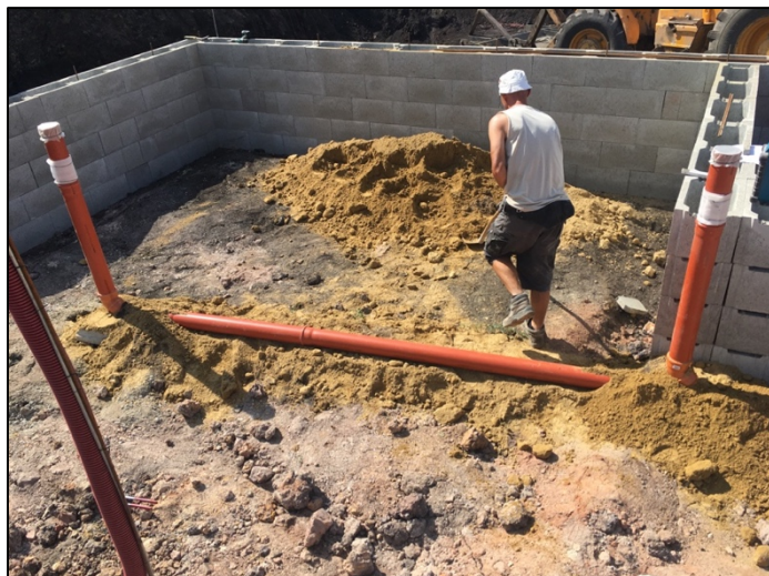
Obrázek 17 - Za pískování ležaté kanalizace (zdroj autor)
