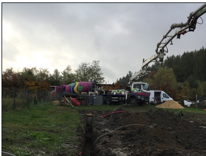
Obrázek 14 - Betonáž základových pasů pomocí beton pumpy (zdroj autor)
