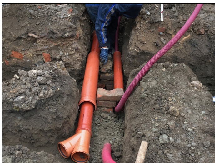
Obrázek 12 - Vytvoření prostupů kanalizace + voda, Varianta 2 (zdroj autor)
