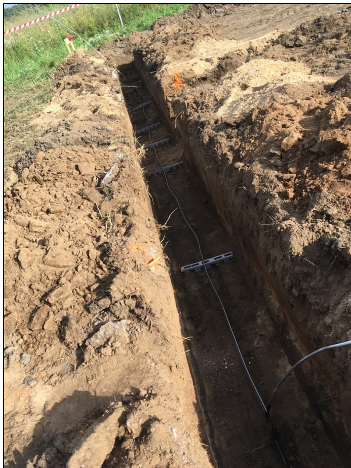
Obrázek 9 - Zemní pásek uložen na distančních podložkách (zdroj autor)
