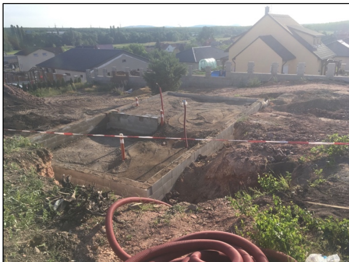
Obrázek 22 - Hutnění základové desky po jednotlivých vrstvách (zdroj autor)
