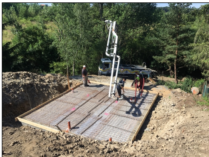
Obrázek 31 - Betonáž základové desky pomocí beton pumpy (zdroj autor)
