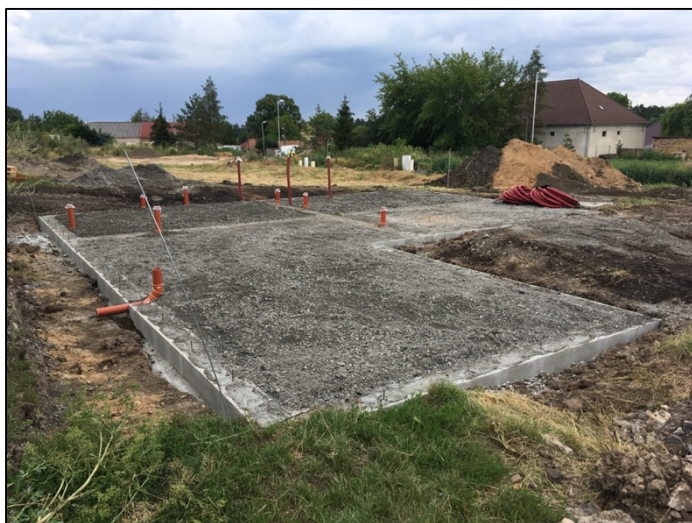
Obrázek 24 - Hutnění základové desky - štěrkový polštář (zdroj autor)
