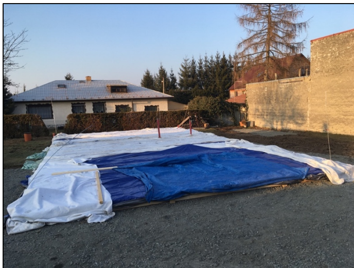
Obrázek 35 - Ochrana základové desky před nízkými teplotami (zdroj autor)
