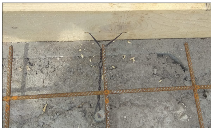
Obrázek 26 - Rádlování bednicího prkna (zdroj autor)
