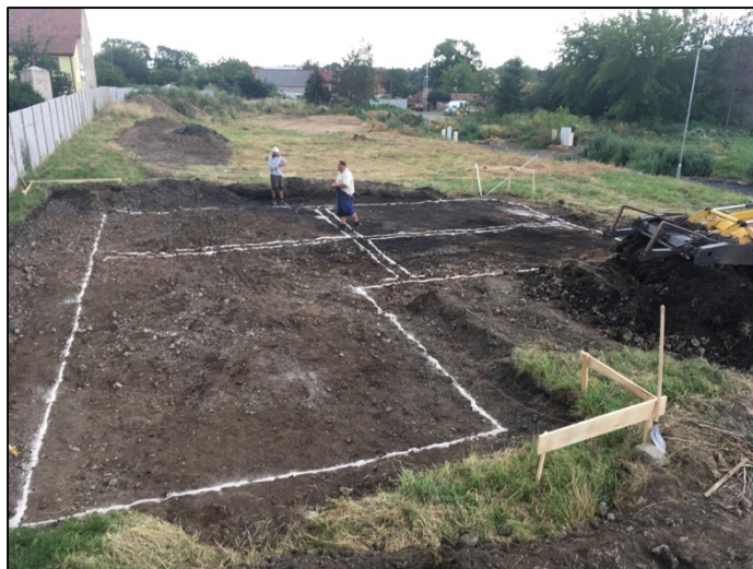
Obrázek 7 - Vyvápnění základových pasů (zdroj autor)
