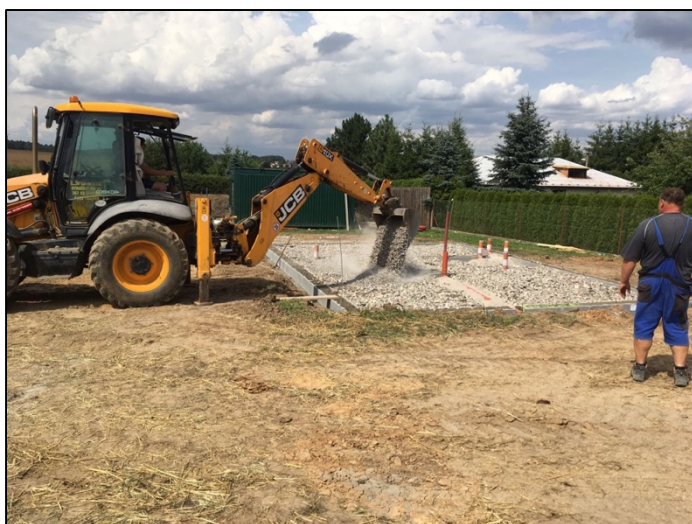
Obrázek 23 - Zásyp základové desky kamenivem frakce 0-32 mm (zdroj autor)
