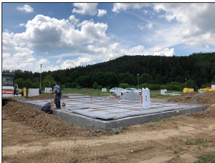
Obrázek 27 - Bednění základové desky pomocí extrudovaného polystyrenu (zdroj autor)
