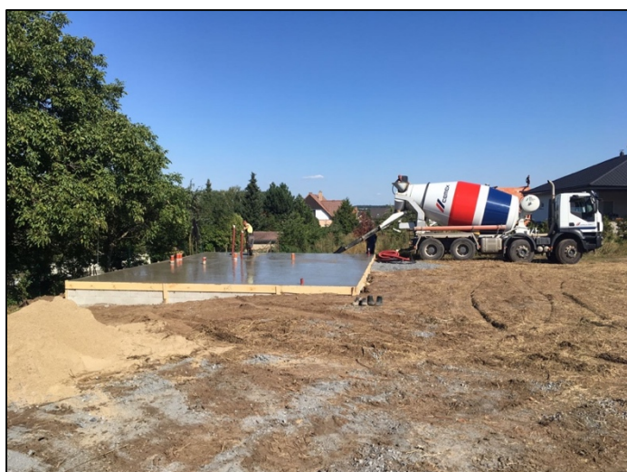
Obrázek 34 - Zrealizovaná základová deska (zdroj autor)
