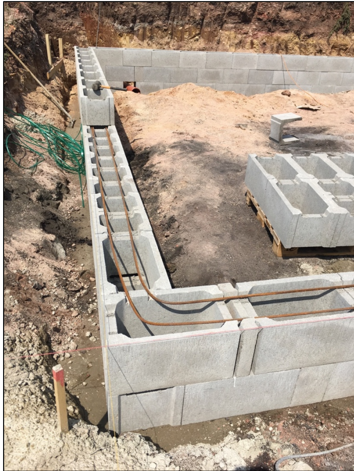
Obrázek 20 - Vyztužování ztraceného bednění (zdroj autor)
