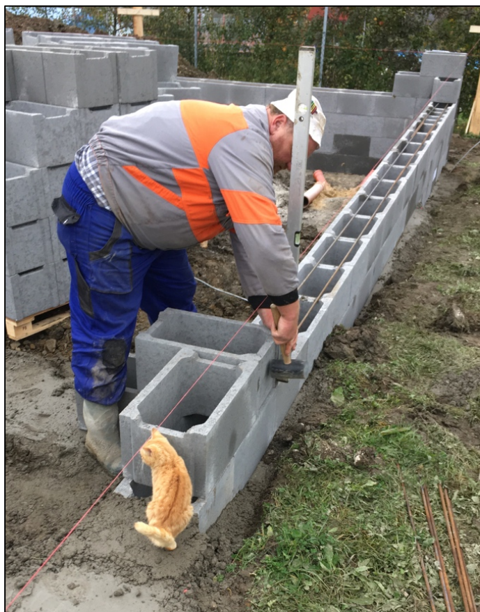
Obrázek 19 - Zdění ztraceného bednění (zdroj autor)
