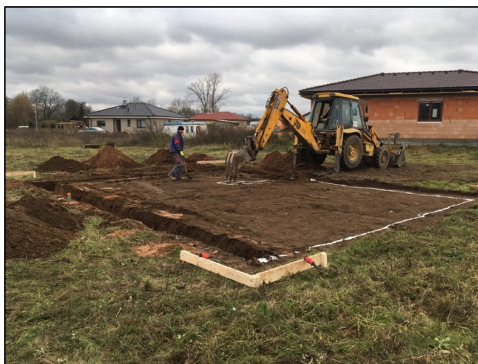
Obrázek 8 - Vyhloubení základových pasů (zdroj autor)
