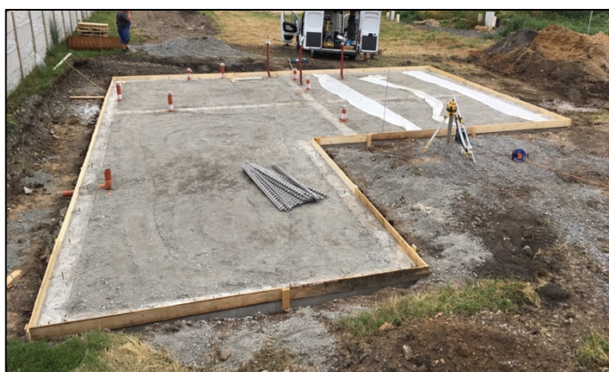
Obrázek 25 - Bednění základové desky (zdroj autor)
