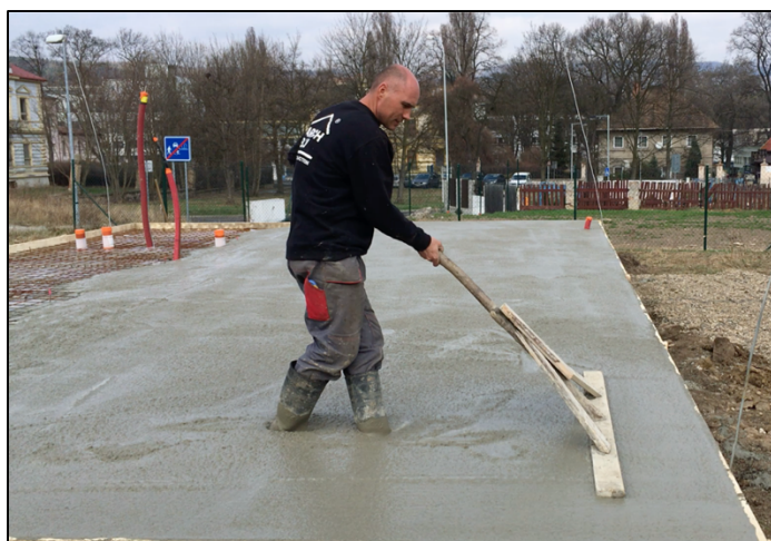
Obrázek 33 - Finální úprava povrchu betonové desky (zdroj autor)
