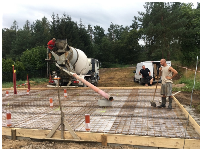
Obrázek 32 - betonáž základové desky pomocí koryt (zdroj autor)
