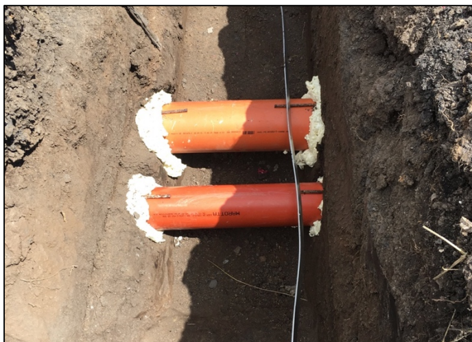
Obrázek 11 - Vytvoření prostupů kanalizace + voda, Varianta 1 (zdroj autor)
