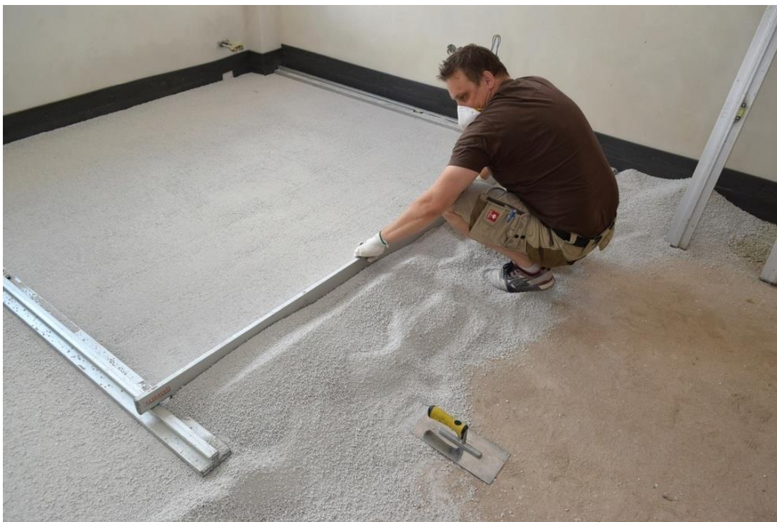
Obr. 13: Provedení suchého podsypu
