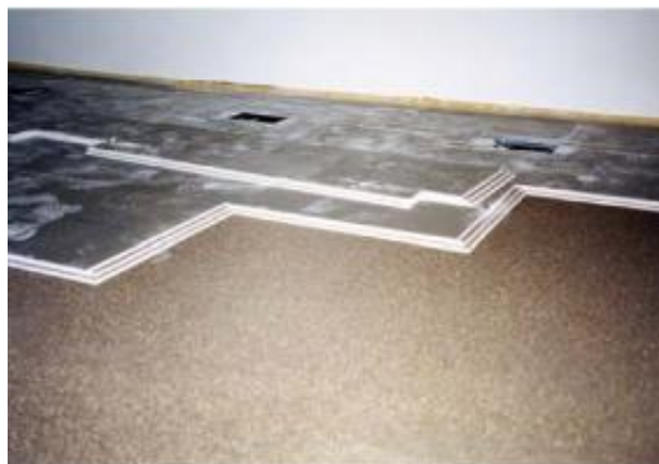
Obr. 21 Podlaha složená z továrně vyrobených dílců
