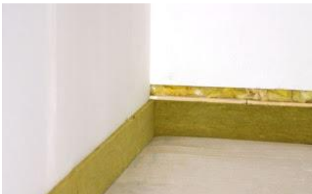
Obr.17: Provedení dilatačního pásku
