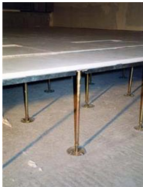
Obr.31: Montáž sádrovláknité dutinové podlahy
