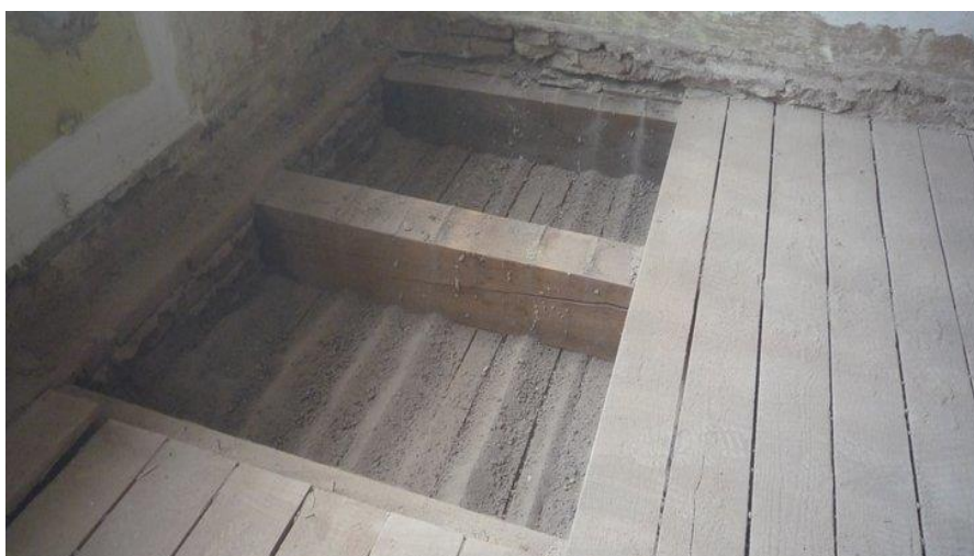
Obr. 7: Odkrytý trámový strop před kontrolou
