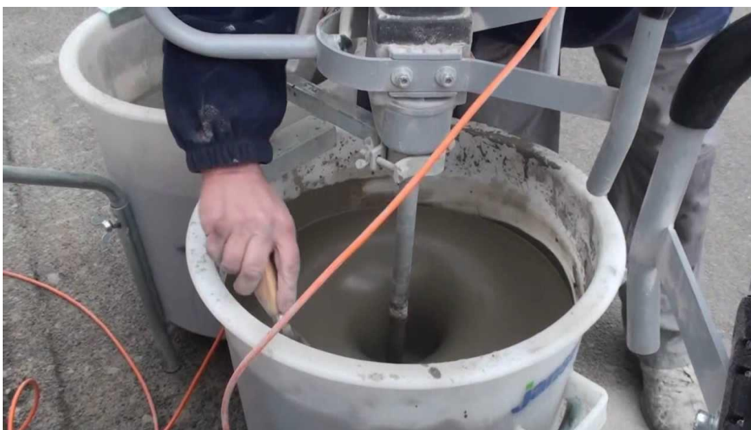
Obr. 12: Míchání samonivelační stěrky
