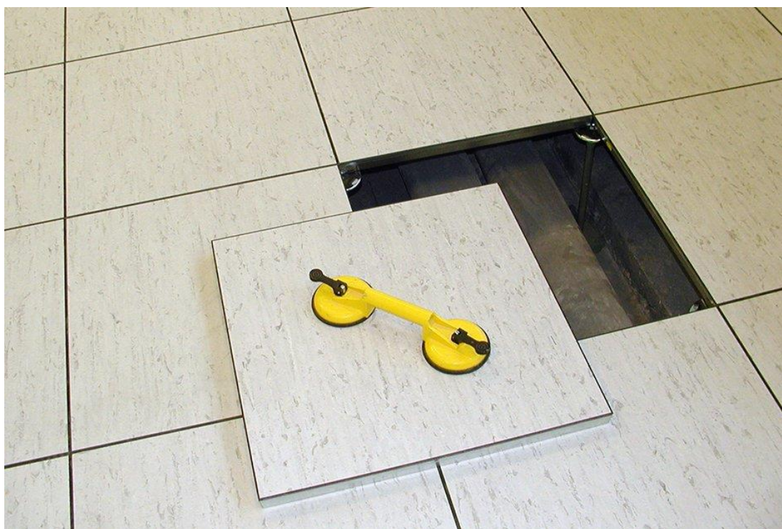
Obr.29: Vyjmutí desky z rastru
