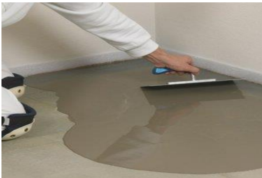
Obr. 10: Provedení samonivelační stěrky
