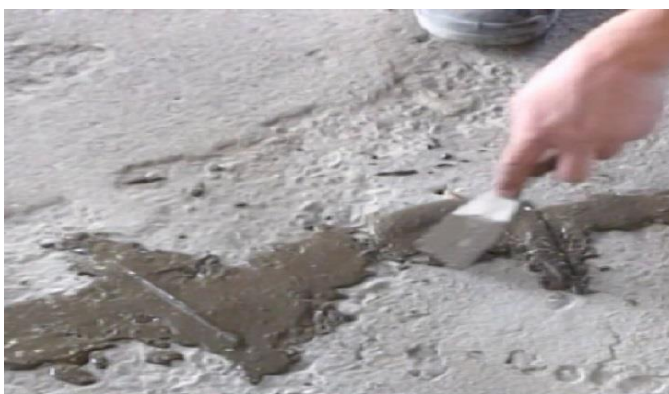
Obr. 11: Vyrovnání větších nerovností
