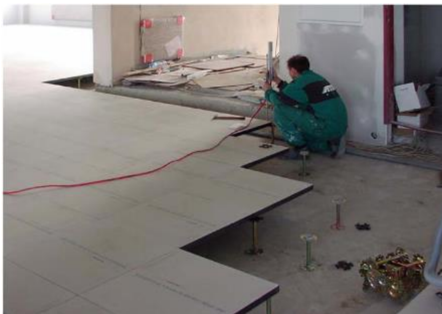
Obr. 28: Montáž sádrovláknitých dvojitých podlah pomocí hadicové vodováhy
