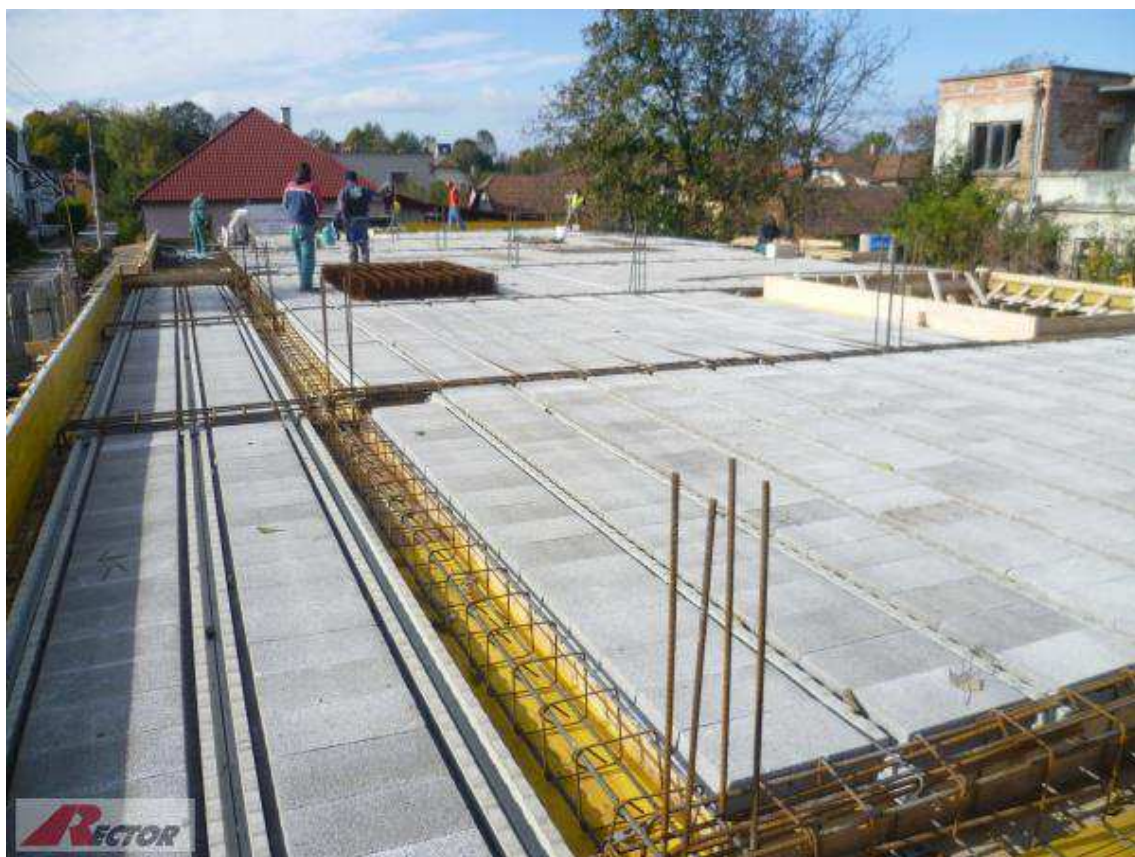
Obr. 3.40 Realizace stropní konstrukce Rectorbeton [31]
