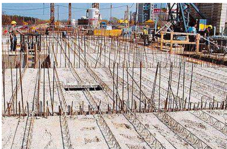
Obr. 2.1 Příklad realizace spřažené stropní konstrukce [30]
