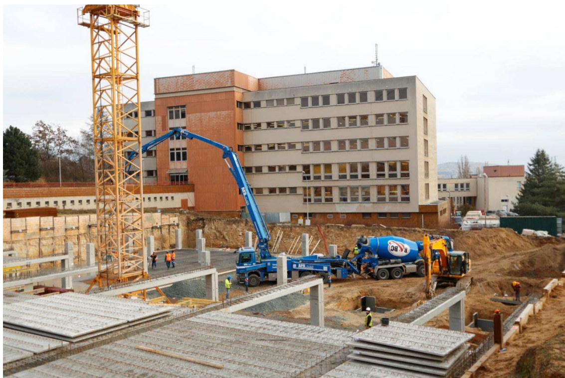
Obr. 3.11 Průběh realizace - skeletový systém s prefamonolitickou spřaženou stropní konstrukcí [27]
