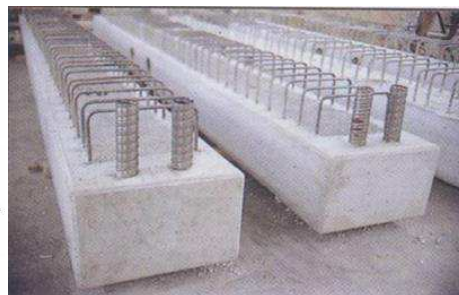
Obr. 4.4 Spřahující oka průvlaků [13]
