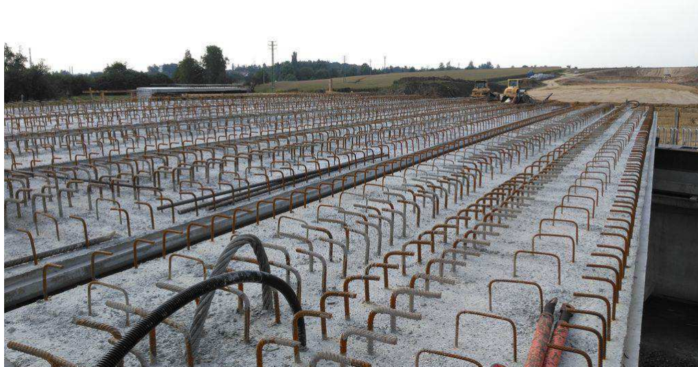
Obr. 3.48 Mostní konstrukce připravená pro dodatečné zmonolitnění [37]
