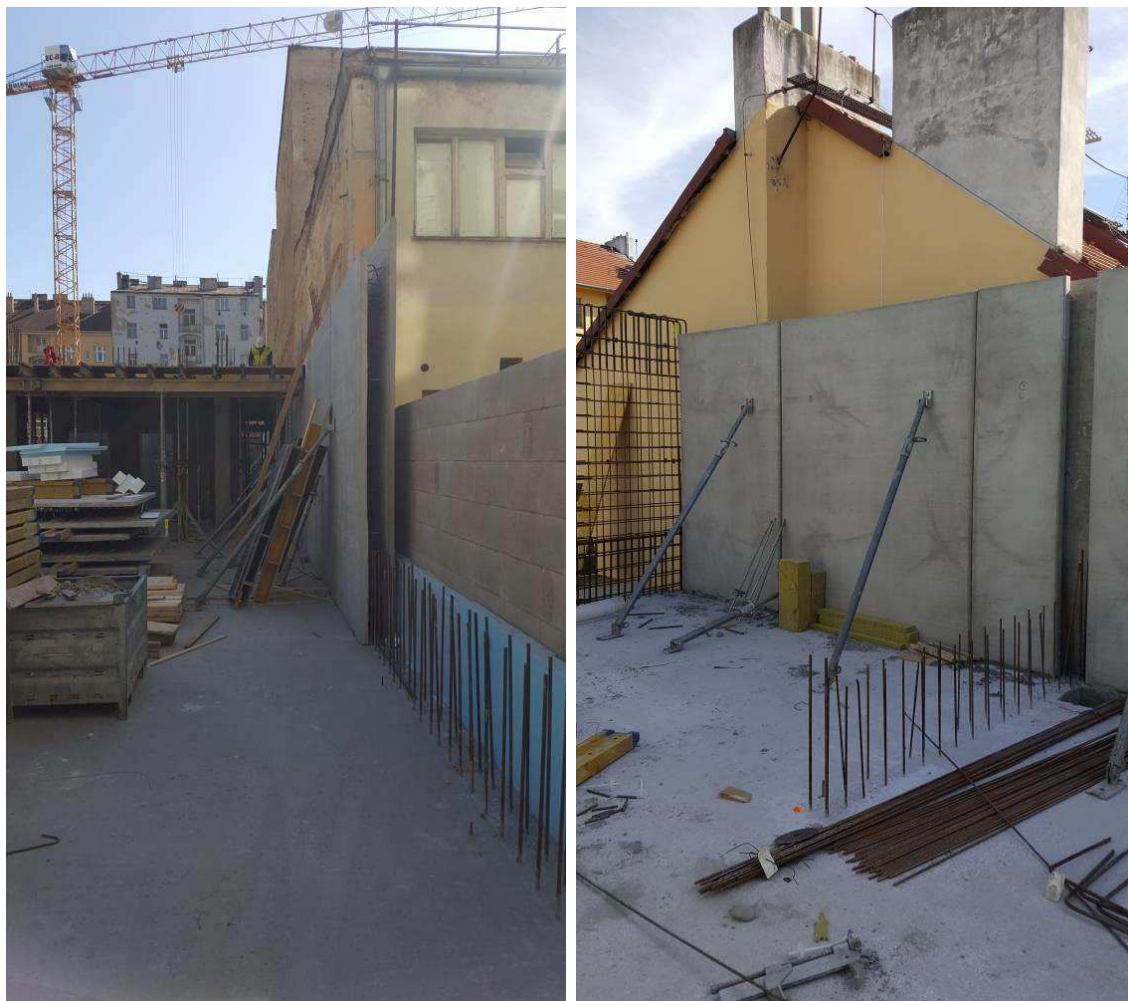
Obr. 3.25 a 3.26 Příprava prefamonolitické filigránové stěnové konstrukce v proluce navazující na sousední objekt s dilatační spárkou - Karlín, Praha 8 [28]
