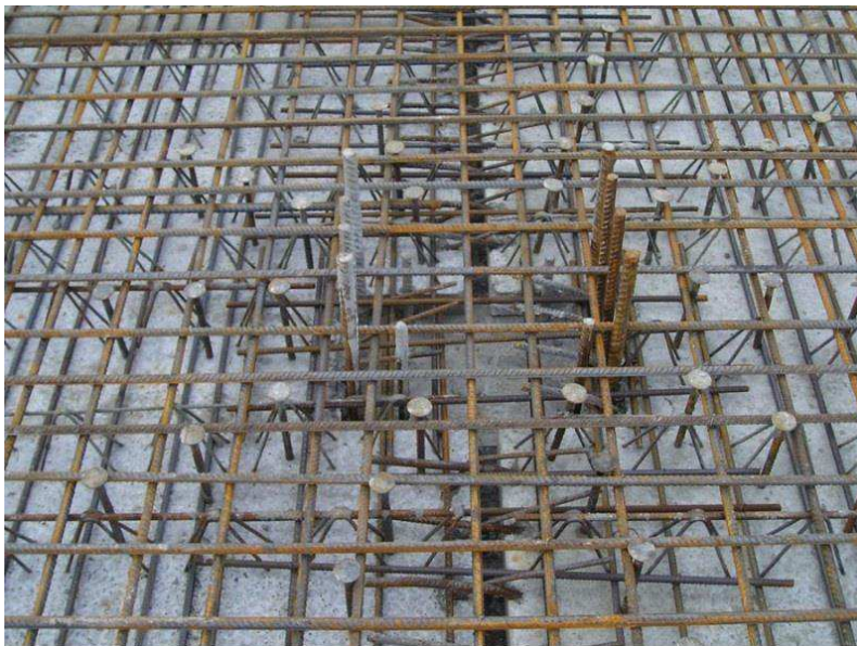
Obr. 3.16 Filigránové desky se smykovou výztuží u sloupu [36]
