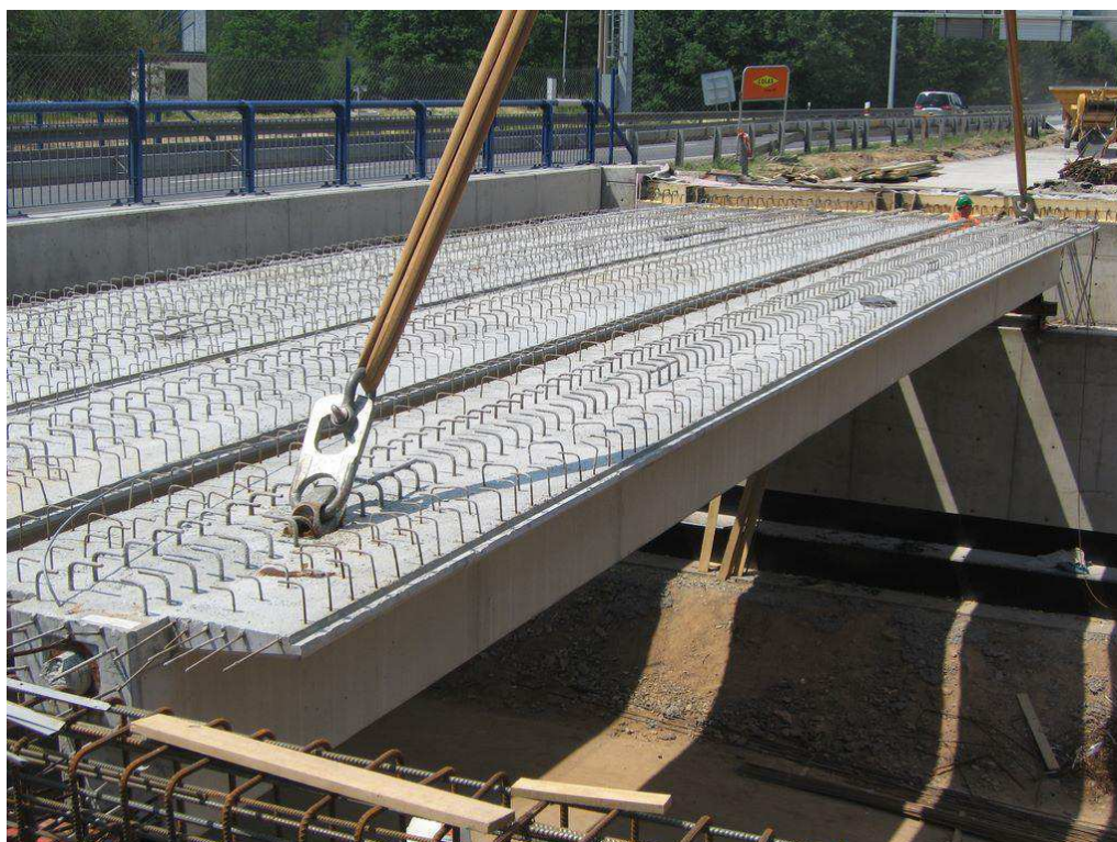
Obr. 3.46 Ukládání spřahujícího mostního nosníku na podpory [37]
