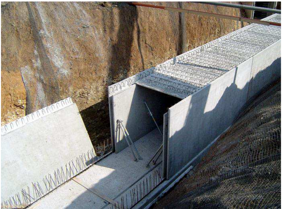
Obr. 3.28 Výstavba kolektoru prefamonolitickými stěnovými a stropními konstrukcemi - pohled 2 [29]
