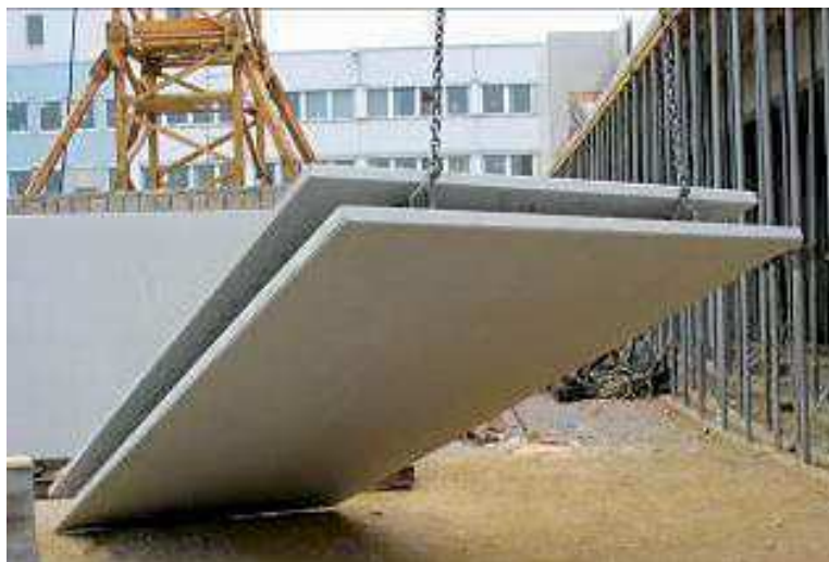
Obr. 3.22 Manipulace s filigránovou stěnou [24]
