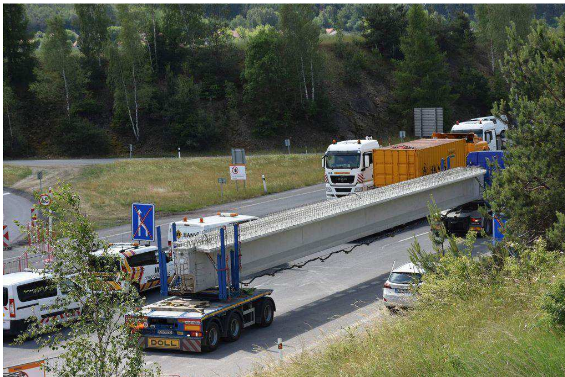
Obr. 3.45 Doprava předem předpjatého vazníku pro mostní konstrukci [37]
