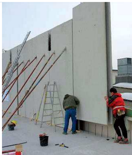
Obr. 3.20 Montážní podepření a ukládka stěnového dílce na stavbě [24]
