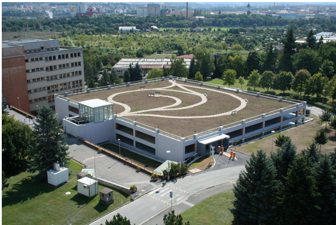
Obr. 3.10 Dokončená stavba Parkovacího domu Fakultní nemocnice v Plzni [26]
