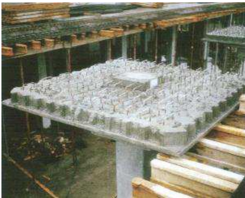
Obr. 3.42 Výrobní hala Akra ve Valašských Kloboukách - pohled na spřahující hlavici [8]
