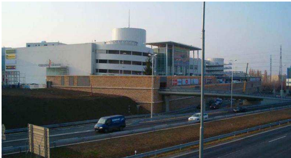
Obr. 3.12 Dokončená stavba obchodního centra Chodov [35]
