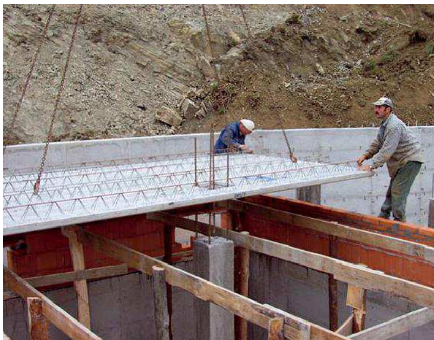
Obr. 3.8 Manipulace s filigránovou deskou - čtyři úchyty [21]
