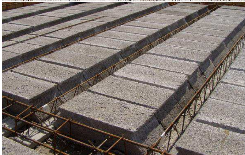
Obr. 2.2 Skladba nosíkového stropního systému Tras [34]
