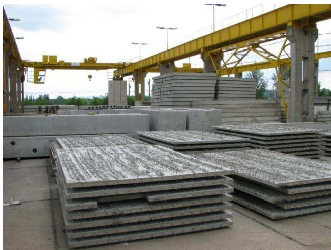
Obr. 4.12 Skladování „filigránových“ stropních desek na stavbě [16]
