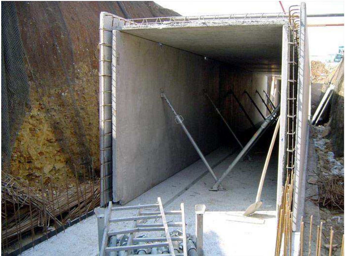
Obr. 3.27 Výstavba kolektoru prefamonolitickými stěnovými a stropními konstrukcemi - pohled 1 [29]
