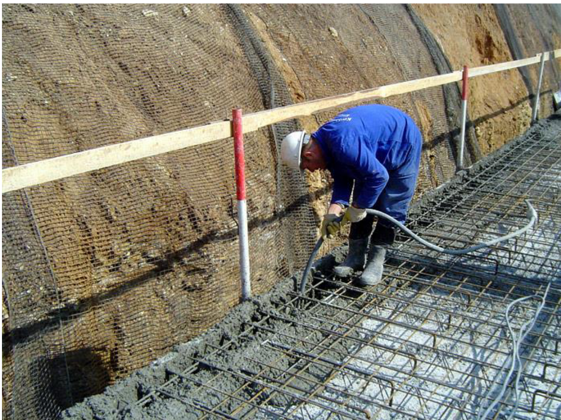
Obr. 3.30 Ponorné vibrování čerstvého betonu uvnitř stěnového dílce [29]
