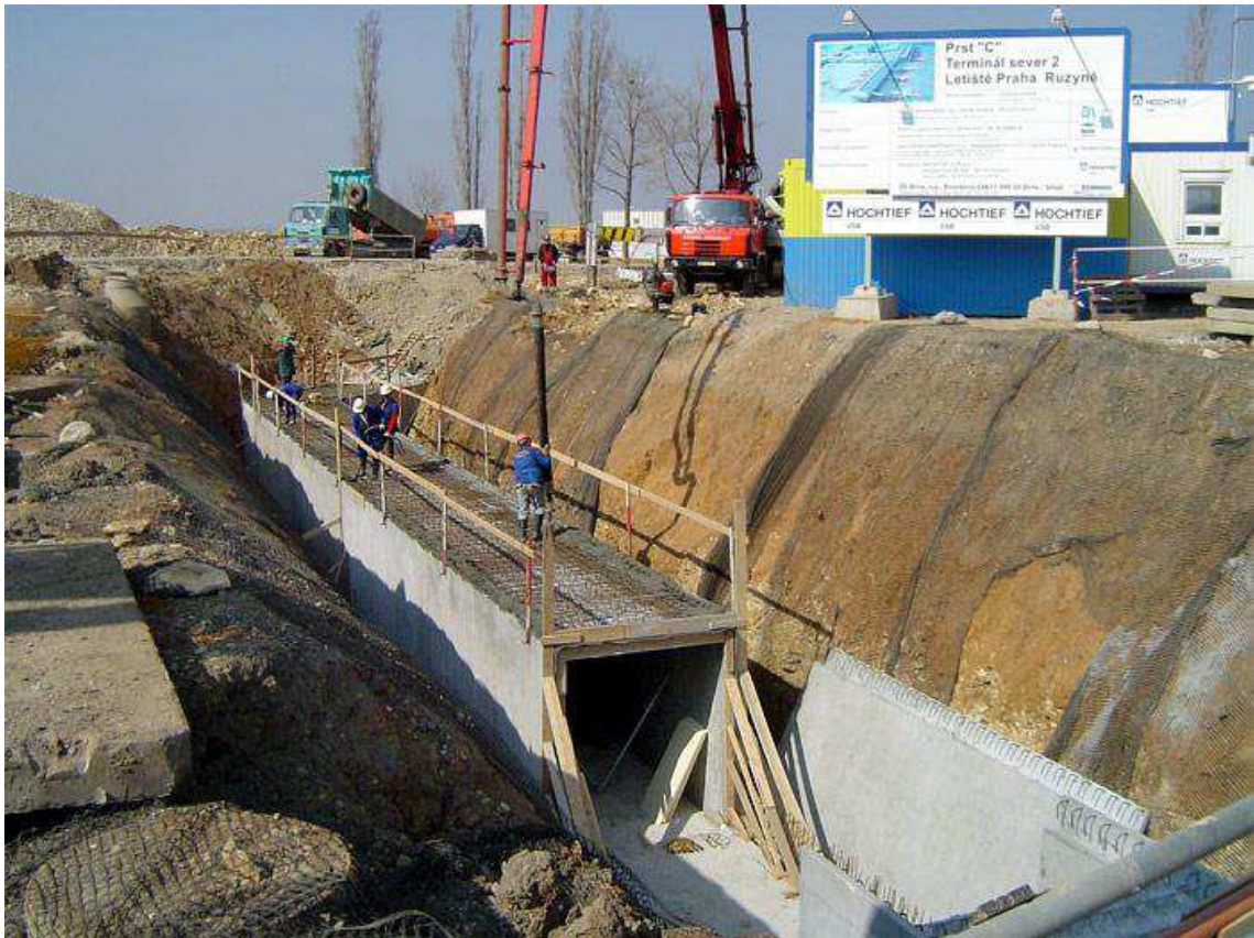
Obr. 3.29 Ukládání čerstvého betonu pomocí mobilního čerpadla [29]
