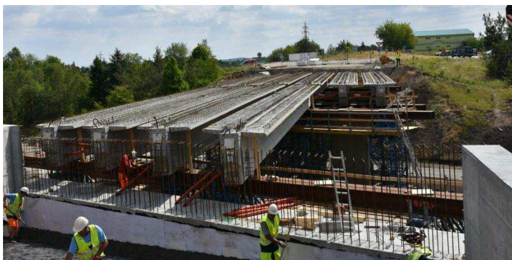
Obr. 3.47 Mostní konstrukce v průběhu realizace[37]
