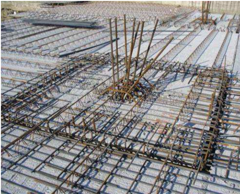
Obr. 3.15 Napojení filigránových desek na sloup[35]
