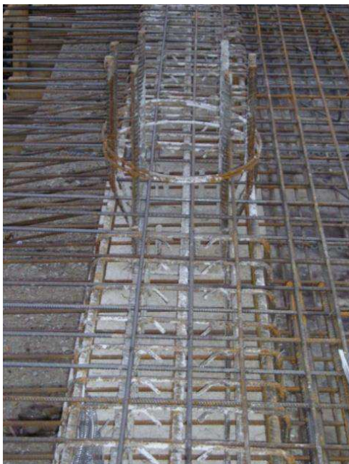
Obr. 3.17 Přefabmonolitický průvlak před zmonolitněním, navazující výztuž desky a sloupu [36]
