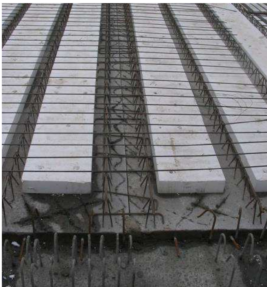
Obr. 3.43 Vylehčení filigránových panelů pomocí EPS [13]
