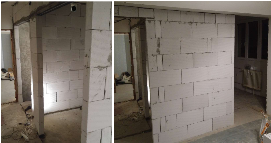
Obr. 33: Nové zděné jádro
