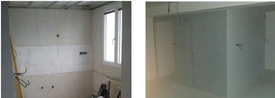
Obr. 3,4: Zapuštěné vedení při rekonstrukci bytového jádra
