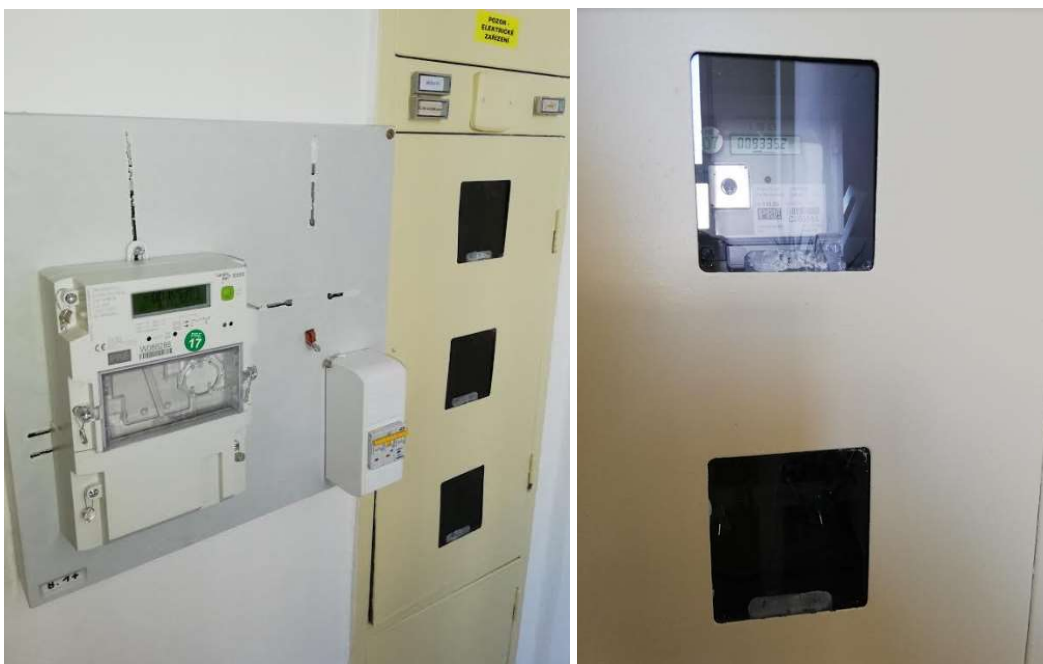
Obr. 38-39: Nový bytový elektroměr a jeho původní umístění
