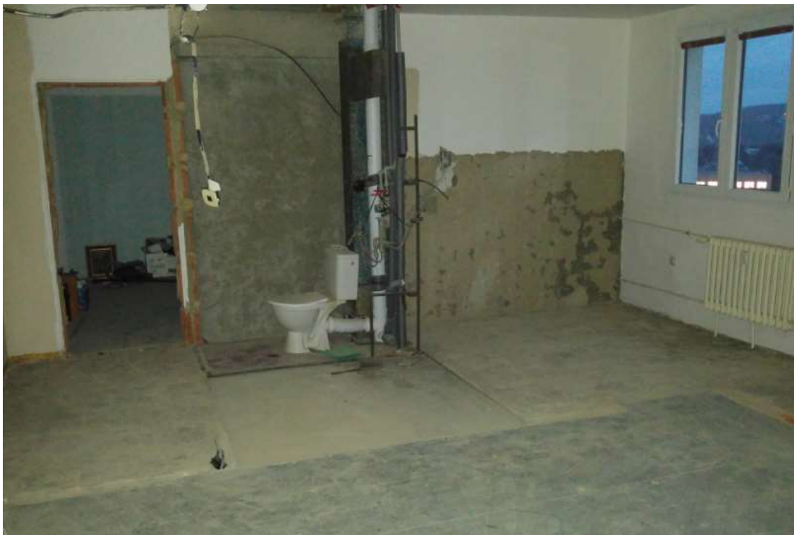
Obr. 32: Vybourané původní umakartové jádro
