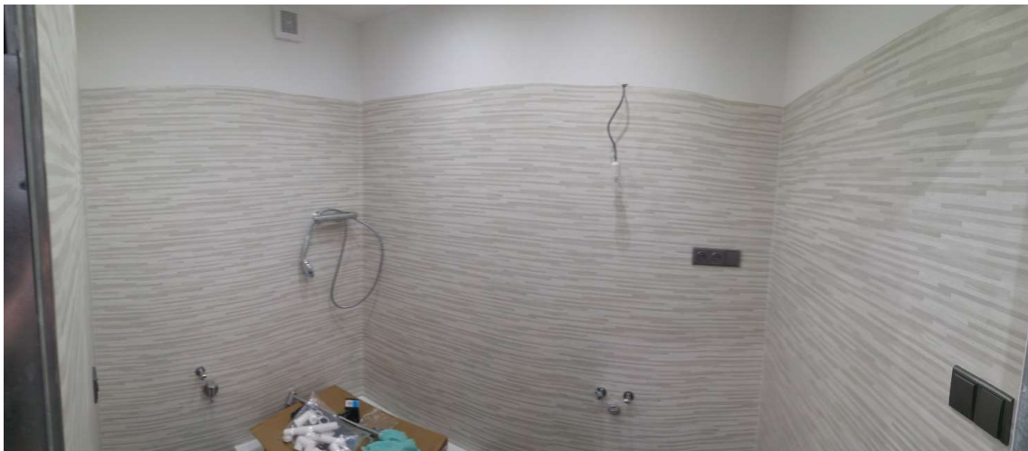
Obr. 44: Koupelna (ještě před osazením sprchového koutu a skříněk)
