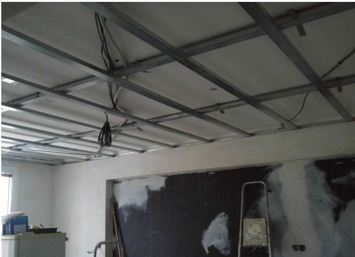
Obr. 35: Vedení rozvodů v podhledu
