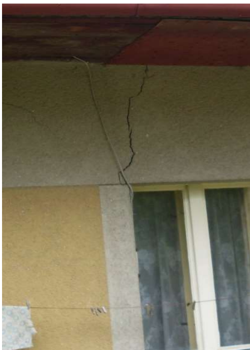
Obr. 13 – Svislá trhlina v nadpraží
