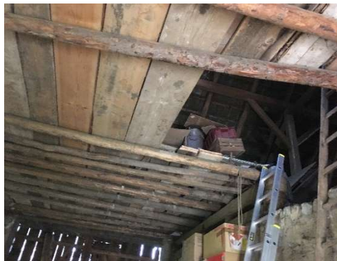
Obr. 19 – Strop nad mlátem a pernou
