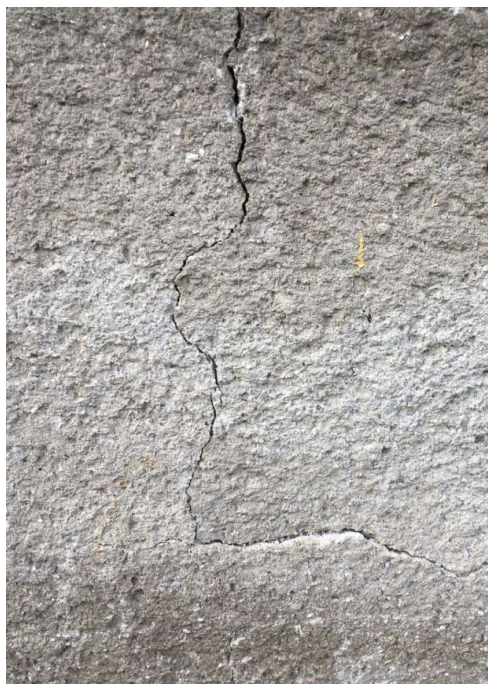
Obr. 14 – Svislá trhlina v parapetu
