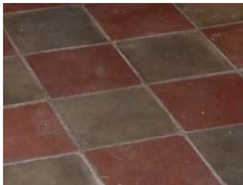
Obr. 28 – Podlaha v chodbě
