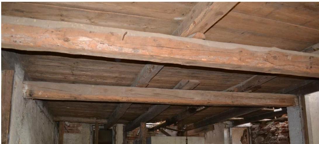
Obrázek č. 31 Trémový strop
