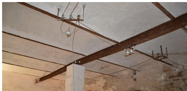
Obrázek č. 29 Valená klenba s traverzami
