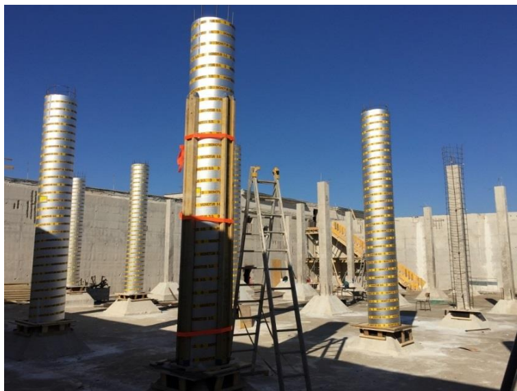
Obr. 16: Postup při bednění sloupů zdroj: vlastní fotografie
