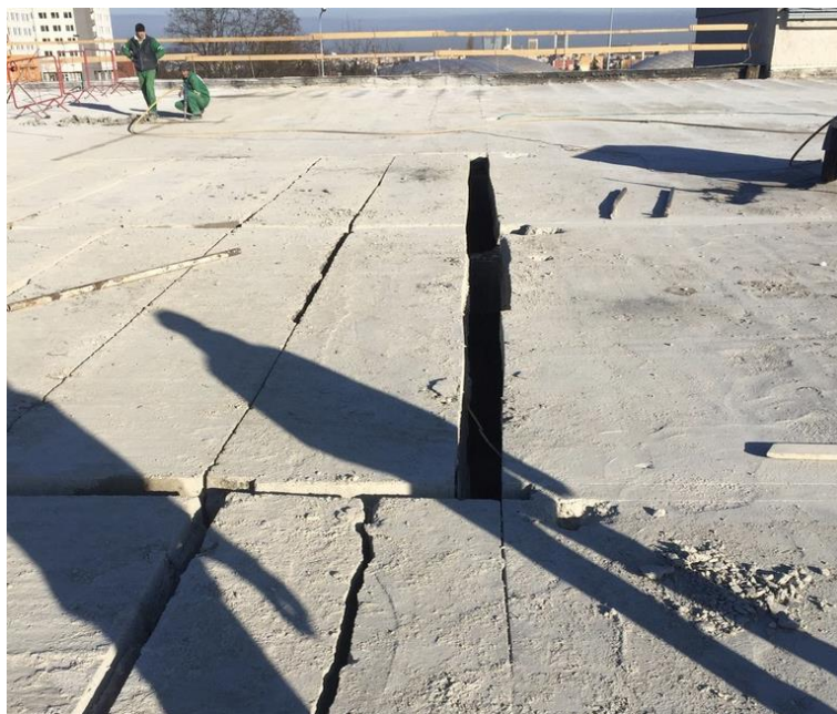
Obr. 13: Demontáž prefabrikovaných stropních panelů zdroj: vlastní fotografie
