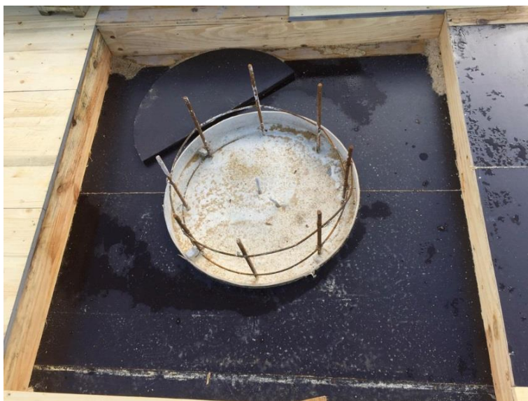
Obr. 18: Bednění pro hlavici sloupu zdroj: vlastní fotografie
