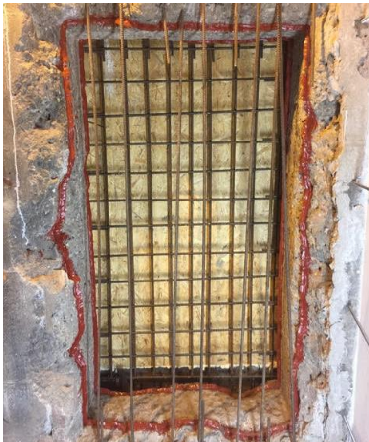
Obr. 33: Bobtnající pásky zdroj: vlastní fotografie
