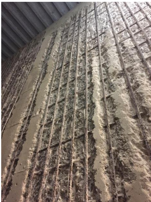
Obr. 7: Přidaná a zaktivovaná výztuž zdroj: vlastní fotografie
