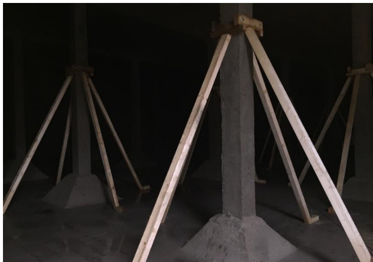
Obr. 12: Zajištění stability u stávajících sloupů zdroj: vlastní fotografie
