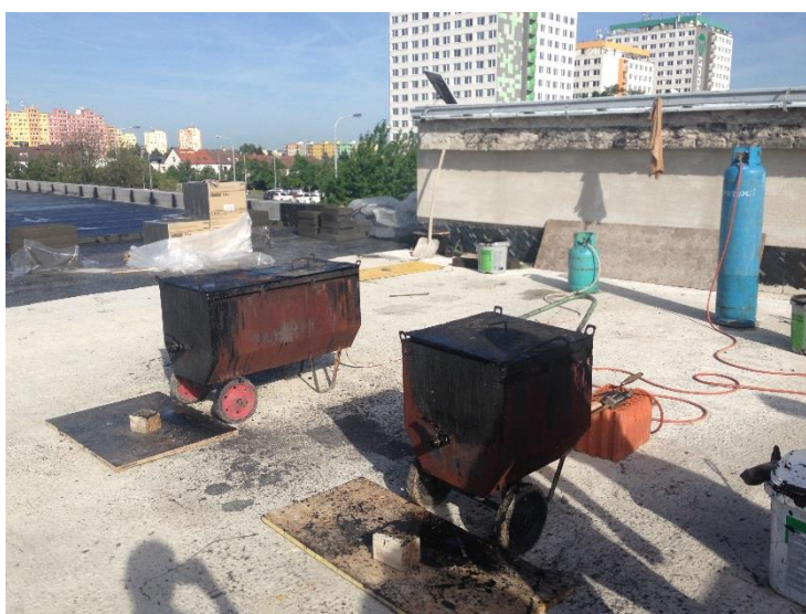
Obr. 26: Tavící kotlíky s hořákovou sestavou zdroj: vlastní fotografie
