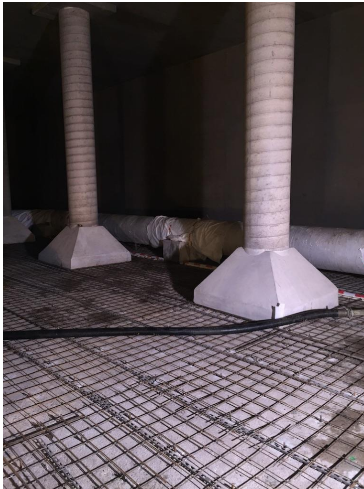
Obr. 24: Betonáž dna vodojemu zdroj: vlastní fotografie
