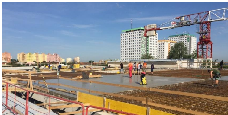
Obr. 22: Postup betonáže u stropní desky zdroj: vlastní fotografie
