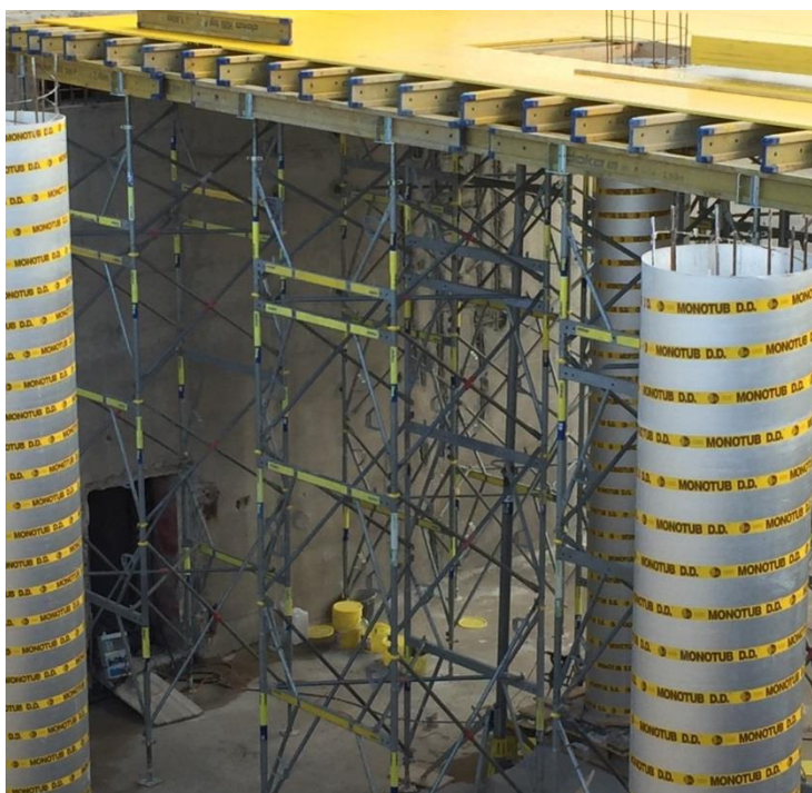
Obr. 20: Stojky pod bedněním zdroj: vlastní fotografie
