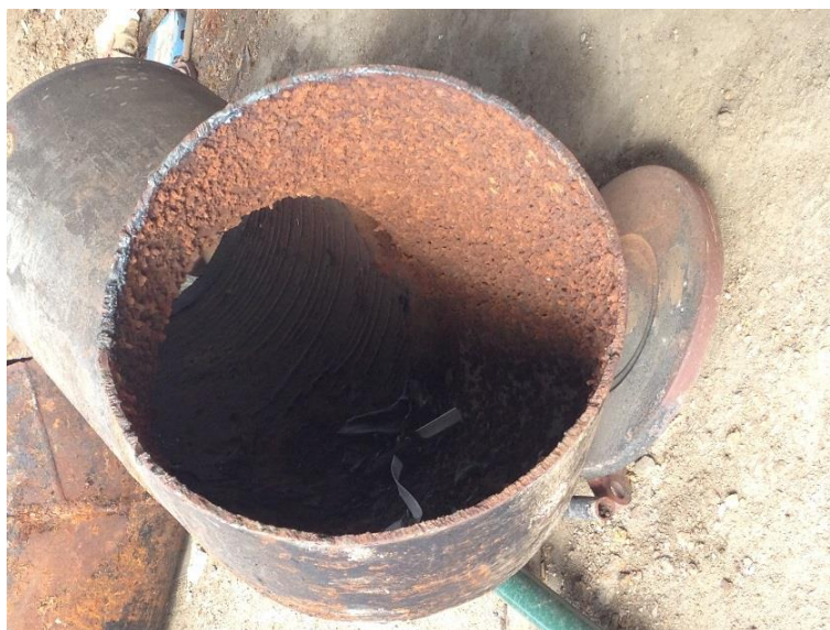
Obr. 31: Pohled do původního potrubí zdroj: vlastní fotografie
