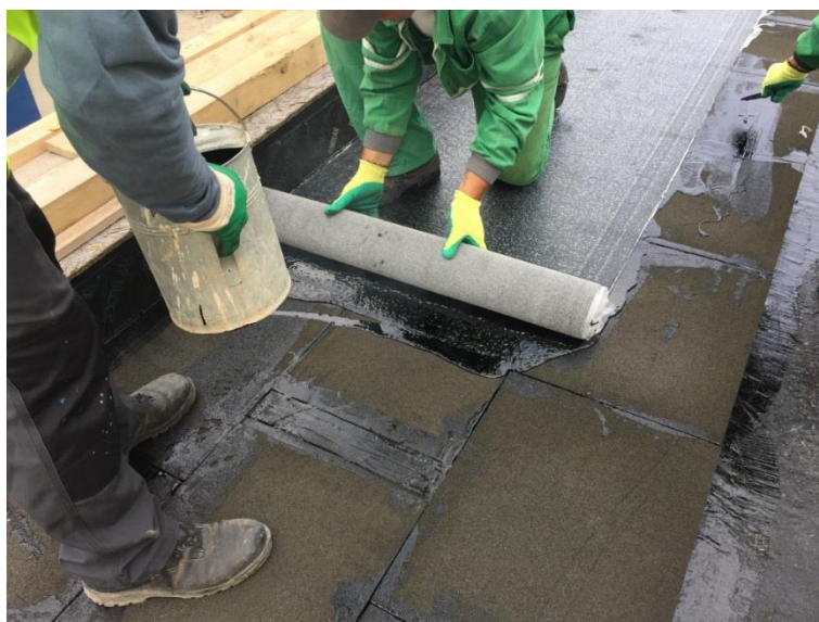
Obr. 28: Pokládka asfaltového pásu zdroj: vlastní fotografie
