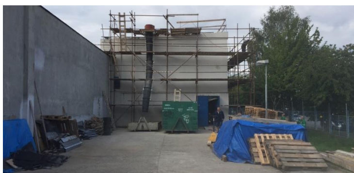
Obr. 14: Uložení likvidovaného materiálu na stavbě 1 zdroj: vlastní fotografie
