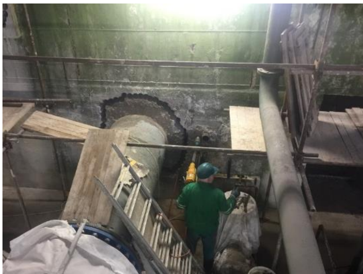
Obr. 30: Vysekané armaturní potrubí zdroj: vlastní fotografie
