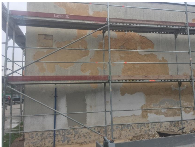
Obr. 35: Odstraňování odfouknuté omítky zdroj: vlastní fotografie
