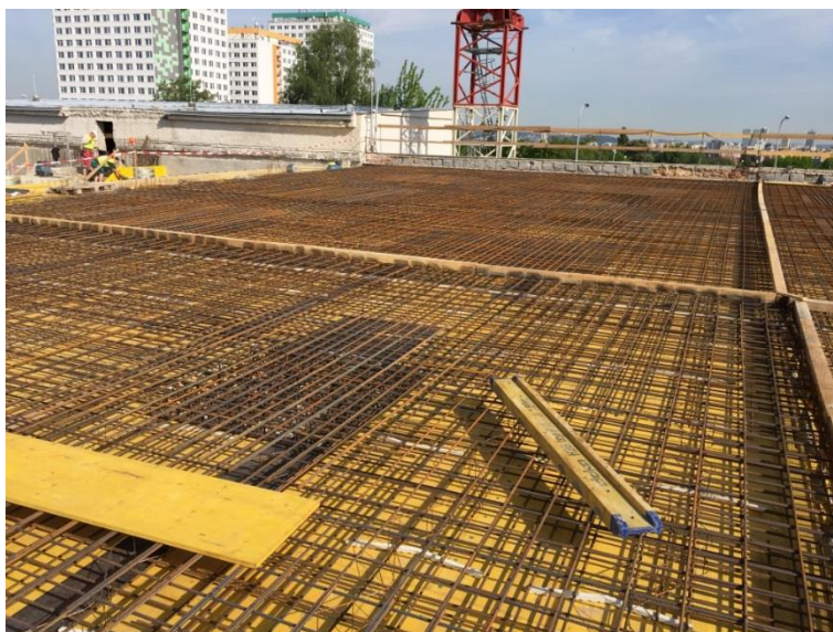
Obr. 21: Rozdělení ploch pro betonáž zdroj: vlastní fotografie
