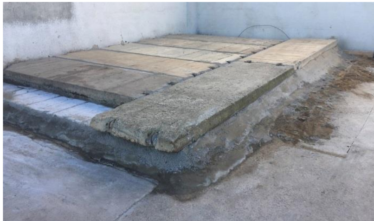
Obr. 29: Zpevněná plocha pod jeřáb zdroj: vlastní fotografie
