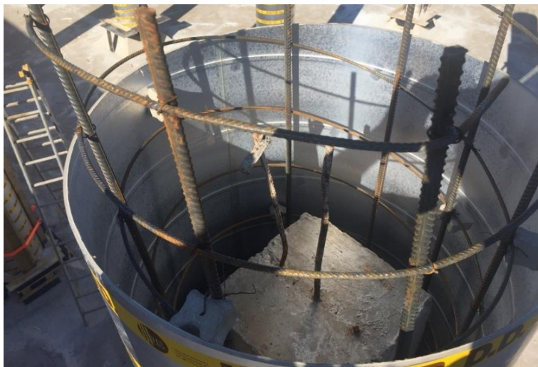
Obr. 17: Detail – pohled do bednění sloupu zdroj: vlastní fotografie
