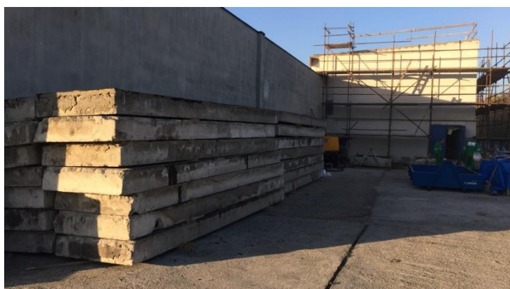
Obr. 15: Uložení likvidovaného materiálu na stavbě 2 zdroj: vlastní fotografie
