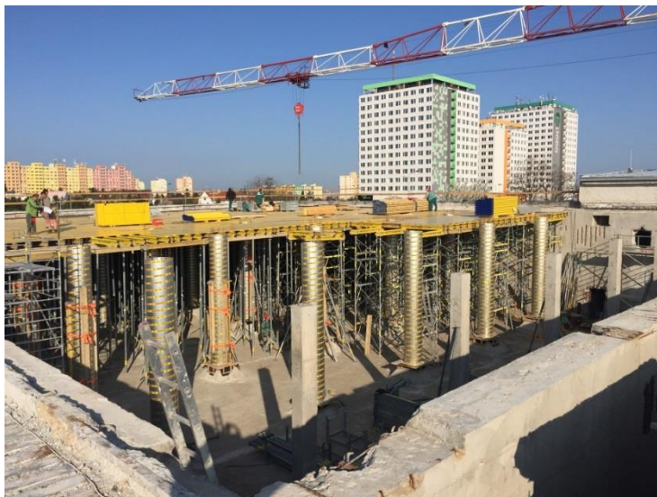
Obr. 19: Montáž bednění stropu zdroj: vlastní fotografie
