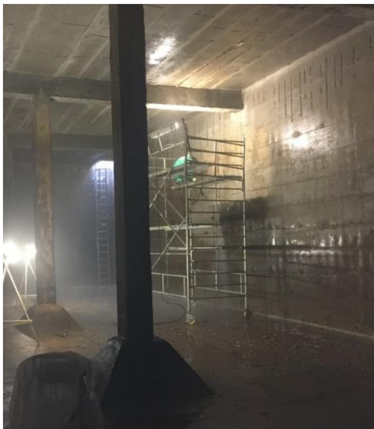
Obr. 6: Pohled do akumulční komory zdroj: vlastní fotografie
