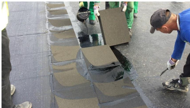
Obr. 27: Pokládání pěnového skla zdroj: vlastní fotografie
