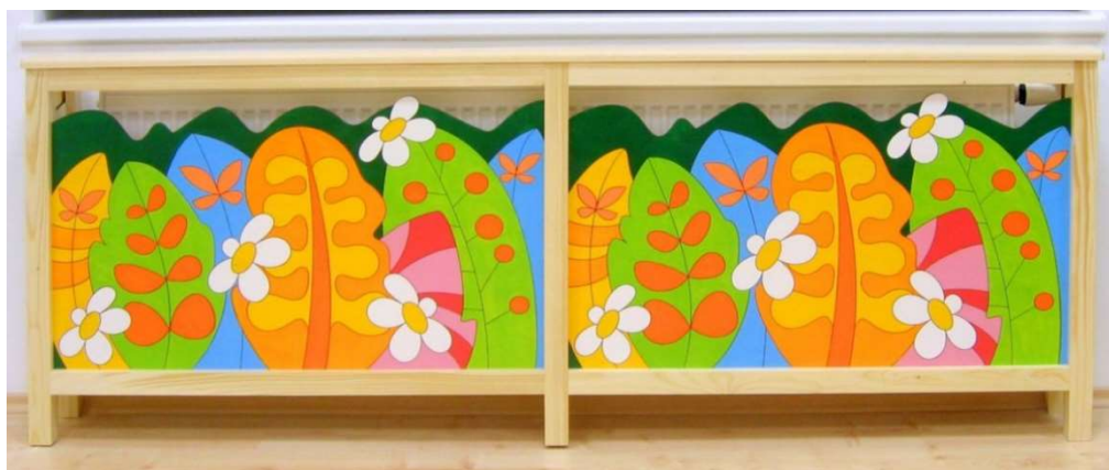
Obrázek 19: Ochranný kryt na otopné těleso [34]
