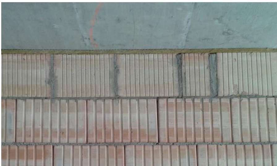
Obr. 9 Vyplnění spáry pod stropem minerální izolací. Převzato z: [26]
