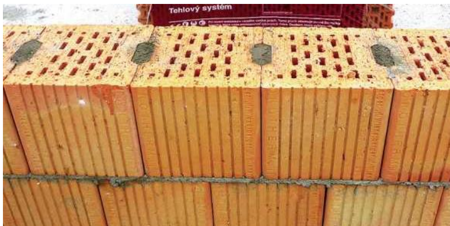
Obr. 8: Vyplnění kapes ve styčných spárách. Převzato z: [26]
