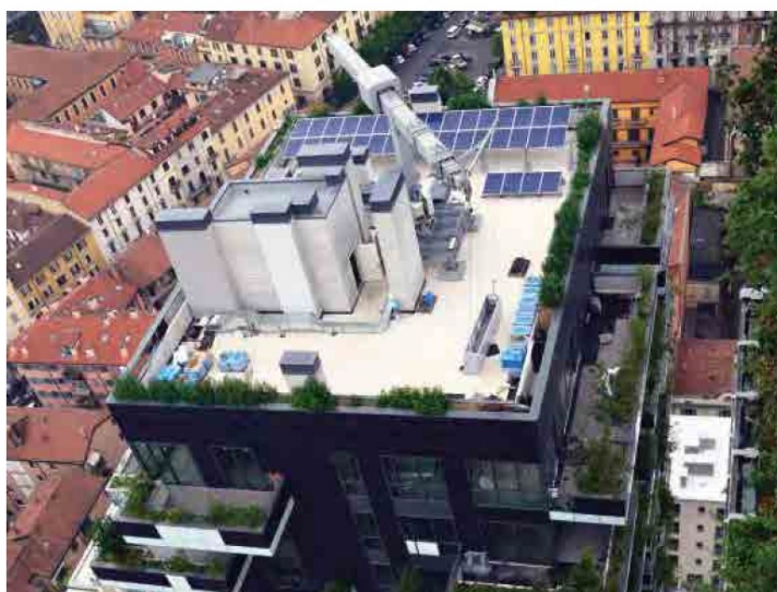
Obrázek 25 - teleskopické rameno pro údržbu fasády
