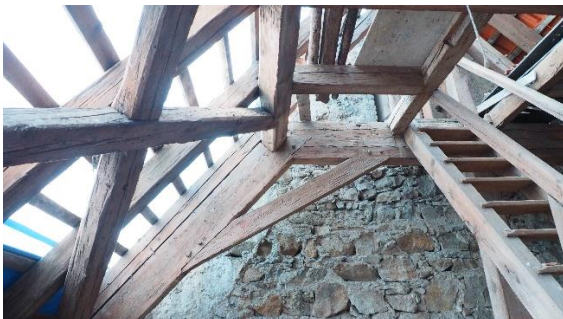
Obr.032 Vzpěradlo detail
