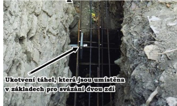
Obr.095 Základový pás s kotvením táhel [13]
