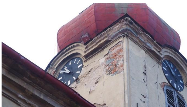
Obr.017 Opět cihelné zdivo u nástavby
