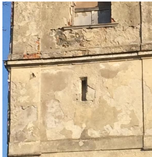
Obr.063 Západní věž – poškození hnaným deštěm, mapy
