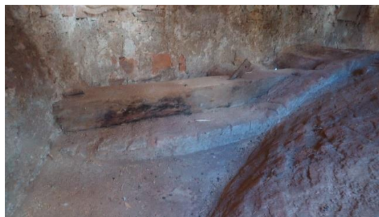
Obr.023 Kopule a viditelné dřevěné táhlo v pozadí
