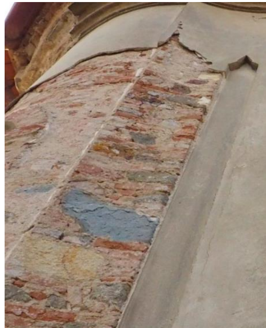
Obr.016 Převážně cihelný presbytář s druhotně použitým materiálem
