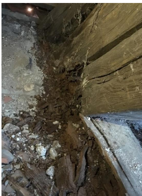
Obr.079 Napadení celulózoými houbami
