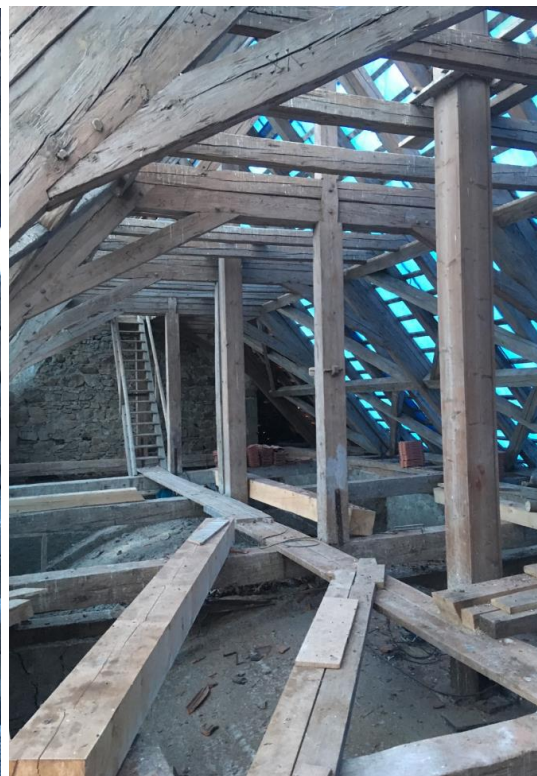
Obr.035 Celkový pohled na krov
