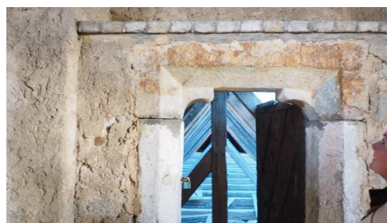
Obr.020 Kamenný portál gotický vstup ke zastřešení
