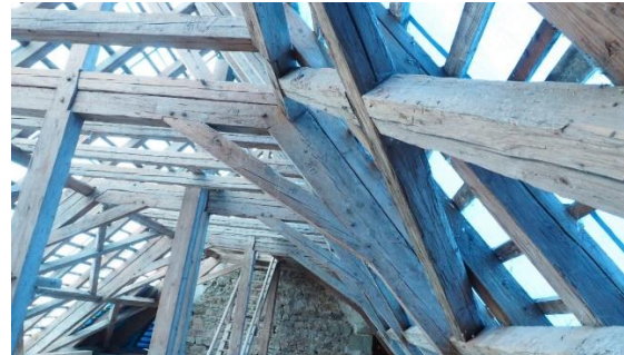
Obr.033 Napojení ondřejského kříže na vzpěradlo
