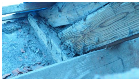
Obr.074 Degradace krátkčete a námětku
