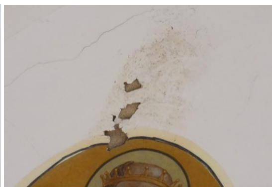
Obr.069 Stopy vlhkosti v západní části lodi
