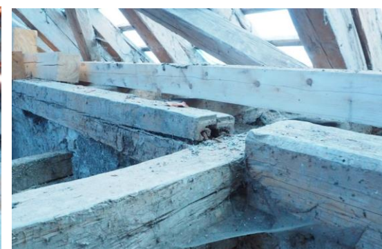
Obr.078 Detail „napojení“ výměn
