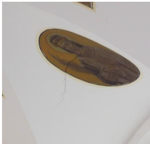
Obr.067 Trhlina kolmá k lunetě
