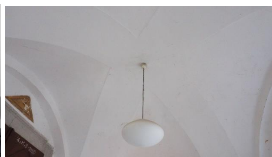
Obr.025 Klášterní klenba s pásy, boční vstup
