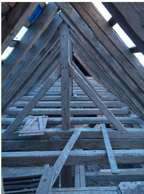
Obr.034 Pohled na horní část věšadla
