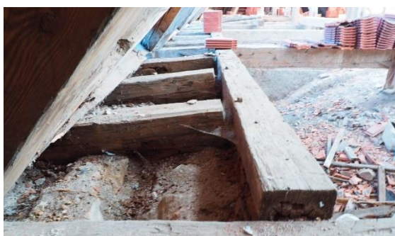
Obr.075 Uvolnění spojů
