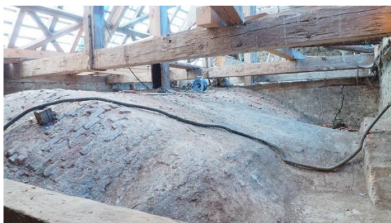
Obr.022 Pohled na valenou klenbu od kopule
