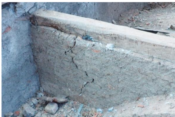
Obr.070 Kotvení táhla, strana jih
