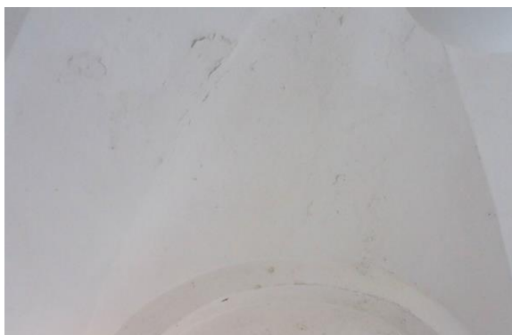
Obr.068 Stopy vlhkosti v západní části lodi
