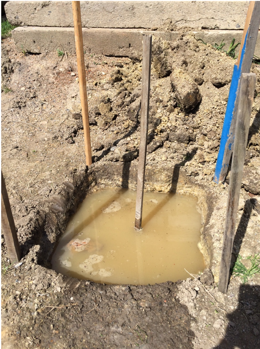
Obr. 14: Průběh vsakovací zkoušky [zdroj: vlastní foto]
