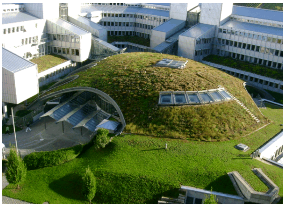
Obr. 3: Příklad extenzivní zelené střechy [14]
