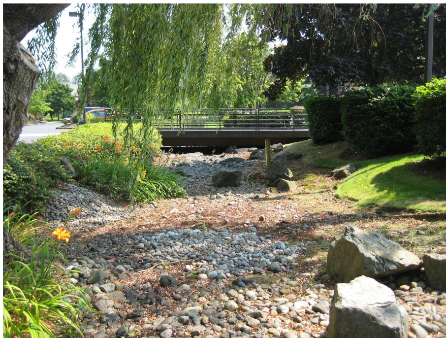
Obr. 8: Příklad vsakovací nádrže ve městě Seattle, USA [17]
