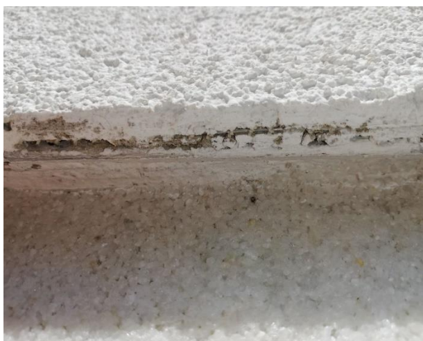
Obrázek 49 - Trhlina u zakládací lišty z důvodu nepoužití profilů s tkaninou
