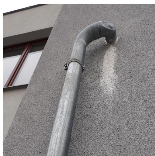
Obrázek 57 - Nekvalitně provedený detail napojení svodu a následné zatýkání za systém ETICS
