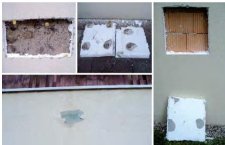
Obrázek 27 - Sondy do zateplovacích systémů
