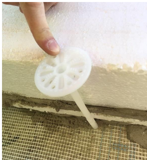
Obrázek 48 - Nedostatečná kotvicí délka
