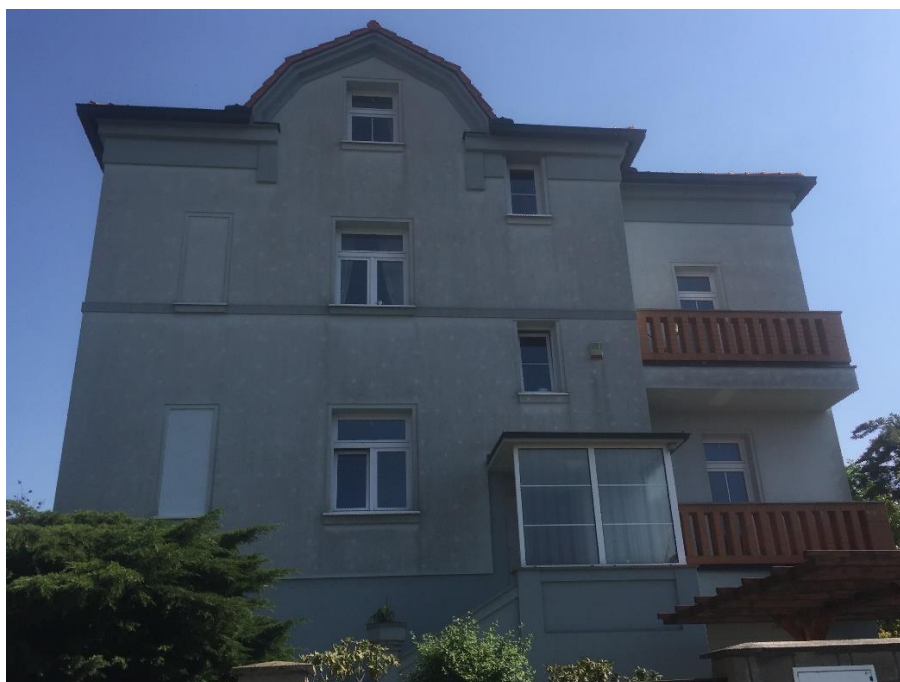
Obrázek 60 - Prokreslení kotev "Dalmatinův efekt"
