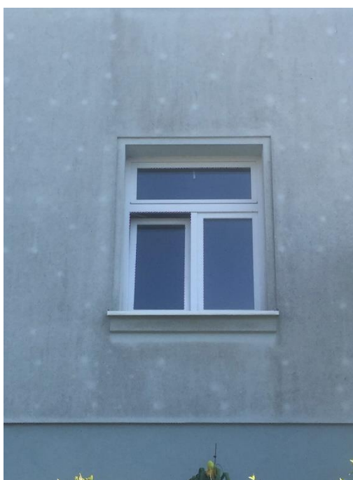
Obrázek 61 - Detail prokreslení kotev "Dalmatinův efekt"
