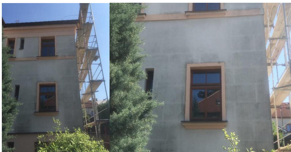
Obrázek 59 - Prokreslení desek na povrchu fasády
