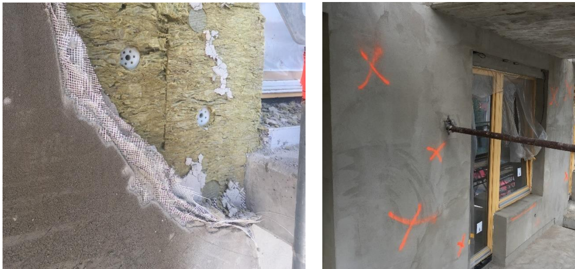
Obrázek 52 - Vyrovnávání špatné rovinnosti lepicí hmotou
