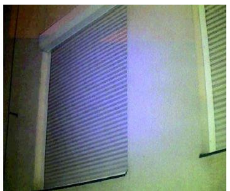
Obrázek 56 - Tepelné mosty v místech ostění a nadpraží
