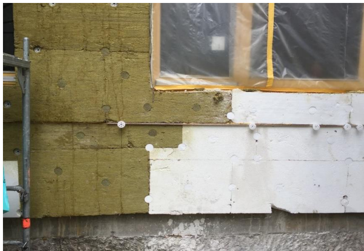
Obrázek 36 - Nepoužití zakládacího profilu a následné doplnění profilu
