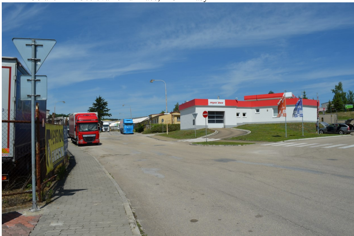
Obrázek 22: Účelová komunikace, MÚK Trasy A
