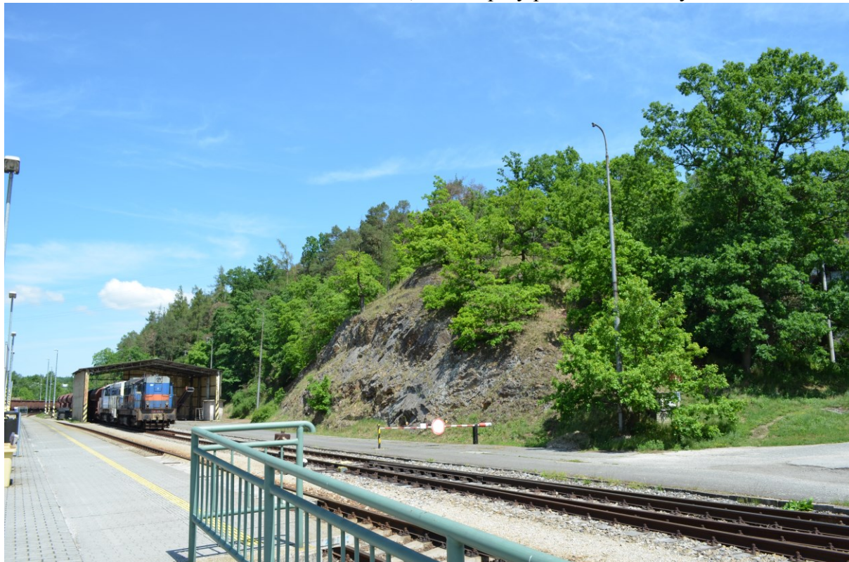
Obrázek 37: Pohled na skálu nad tratí, místo opěry přemostění Trasy A
