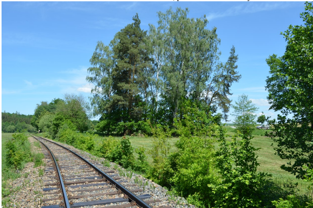
Obrázek 34: Žel. Trať č. 227 a sil. III/40623, pohled ve směru Malý Pečín
