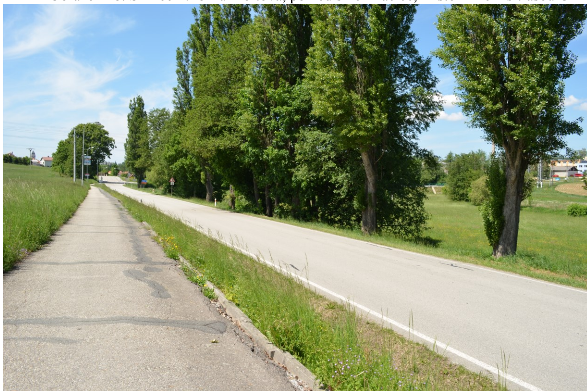
Obrázek 48: Silnice II/151 u hřbitova, pohled směr Dačice, místo křížení s trasou C
