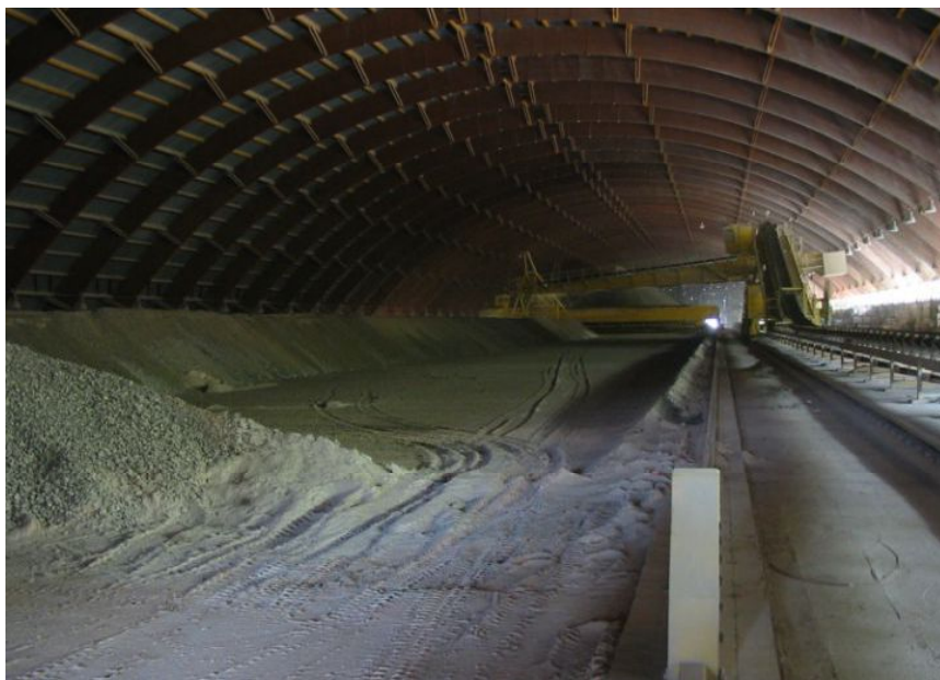
Obr. č. 2 - Předhomogenizační zastřešená skládka
