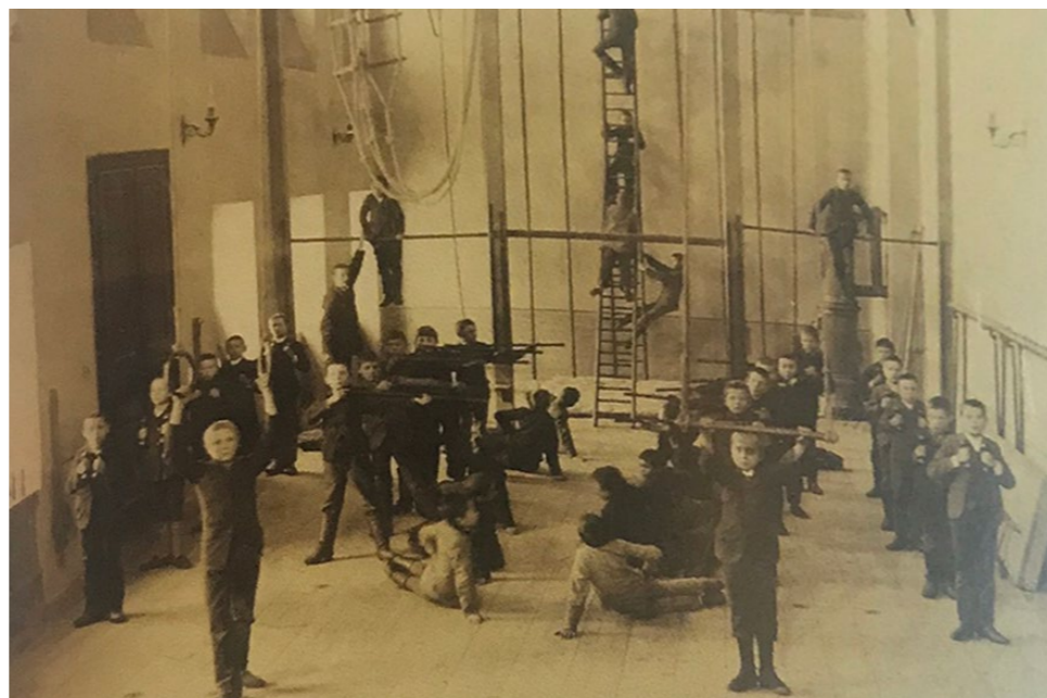
Obr. č. 4 Jaroměř (okr. Náchod), tělocvična roku 1894. [6] Foto: NPMK, inv.č. F1139
