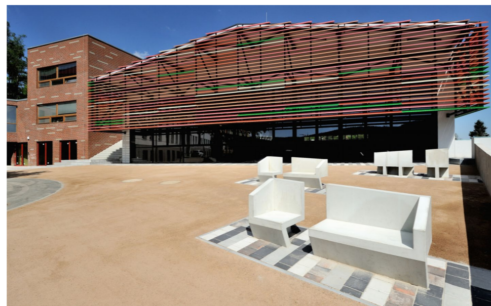
Obr. č. 9 Sportovní hala Věry Čáslavské v Černošicích, fotografie exteriéru [10]
