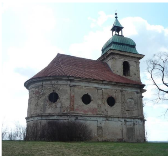
Obr. 2.2: Kostel sv. Ducha – exteriér
