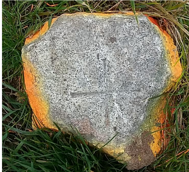
Obr. 4.1: Bod státního bodového pole 29.2 - stabilizace
