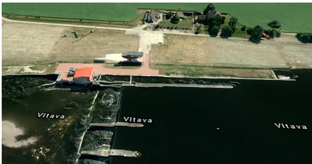
Obr. 3 – Vodní dílo Vraňany-Hořín (3D pohled od severu na MVE Vraňany I a velín jezu)
