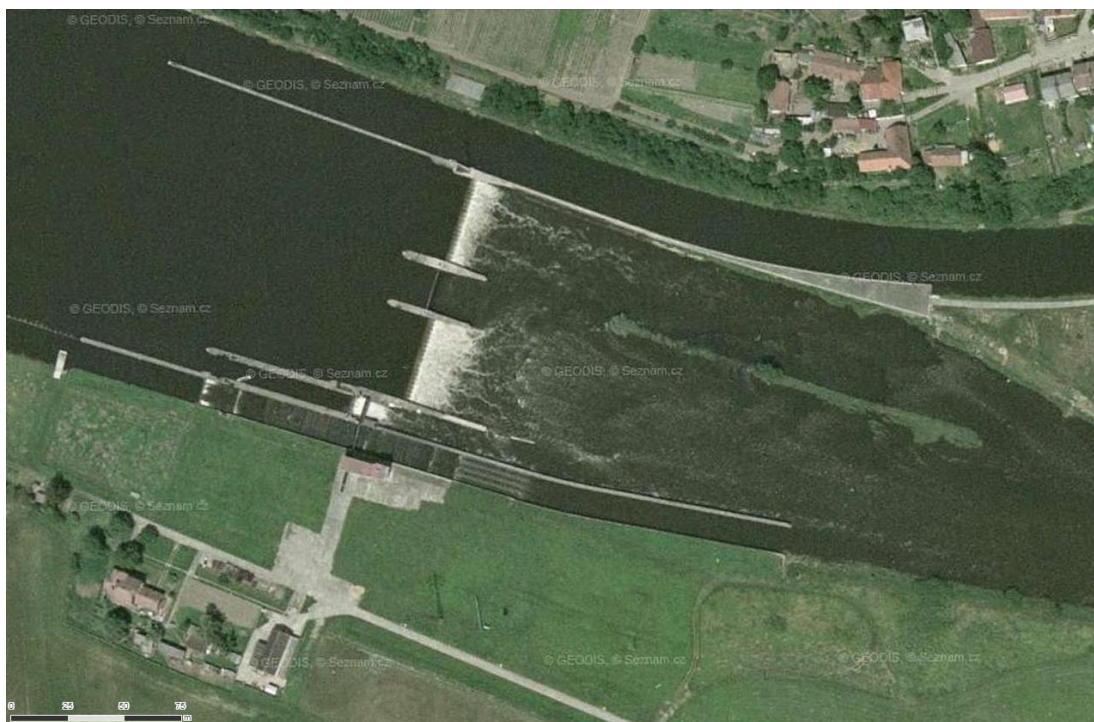
Obr. 2 – Vodní dílo Vraňany-Hořín v roce 2003 (od jihu: vorová propust-dnes zasypána; plavební komora-dnes MVE Vraňany; jez; plavební kanál)
