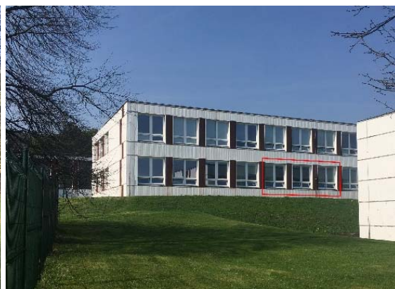
Obrázek 23: Pohled na okna učebny 5. B
