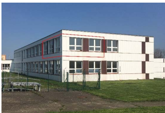
Obrázek 24: Pohled na okna učebny 6. B
