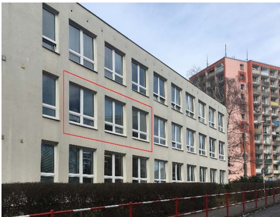
Obrázek 8: Pohled na okna učebny 4.A
