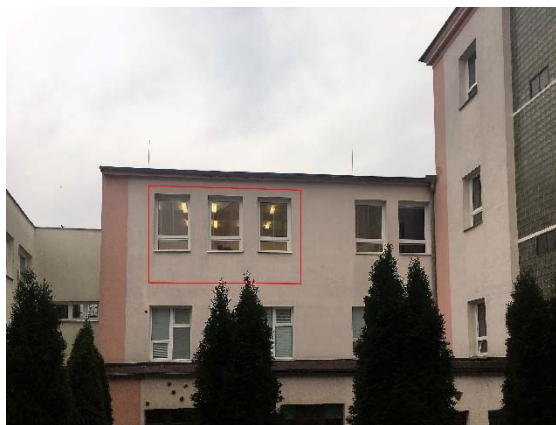
Obrázek 11: pohled na okna učebny 8.B
