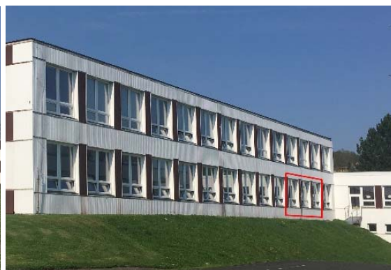
Obrázek 25: Pohled na okna učebny 9. A
