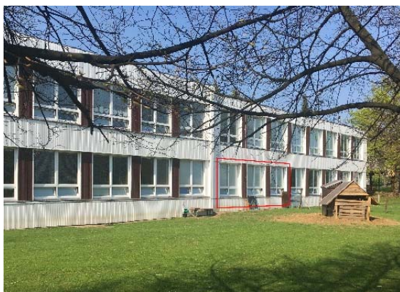
Obrázek 22: Pohled na okna učebny 4. A
