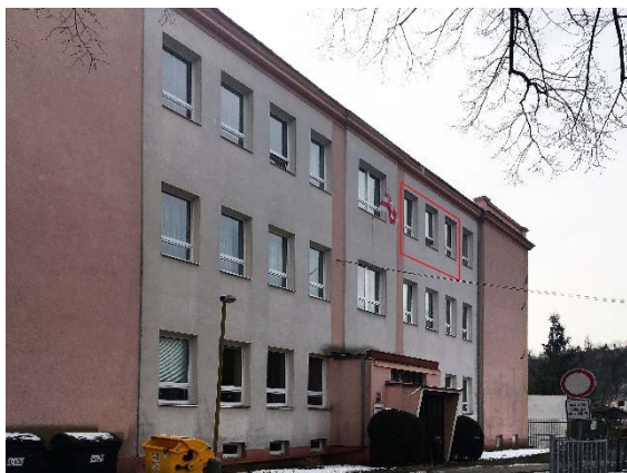
Obrázek 10: Pohled na okna učebny 7.A
