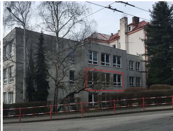
Obrázek 9: Pohled na okna učebny 4.B
