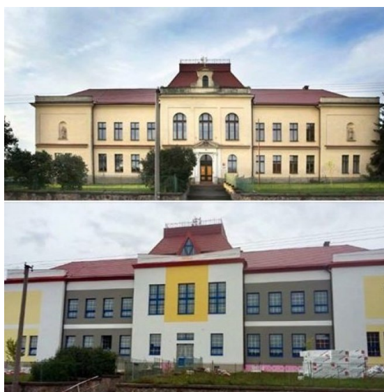
Obrázek 5.1: Nevhodná architektonická forma modernizace pláště základní školy v Kamenných Žehrovicích
