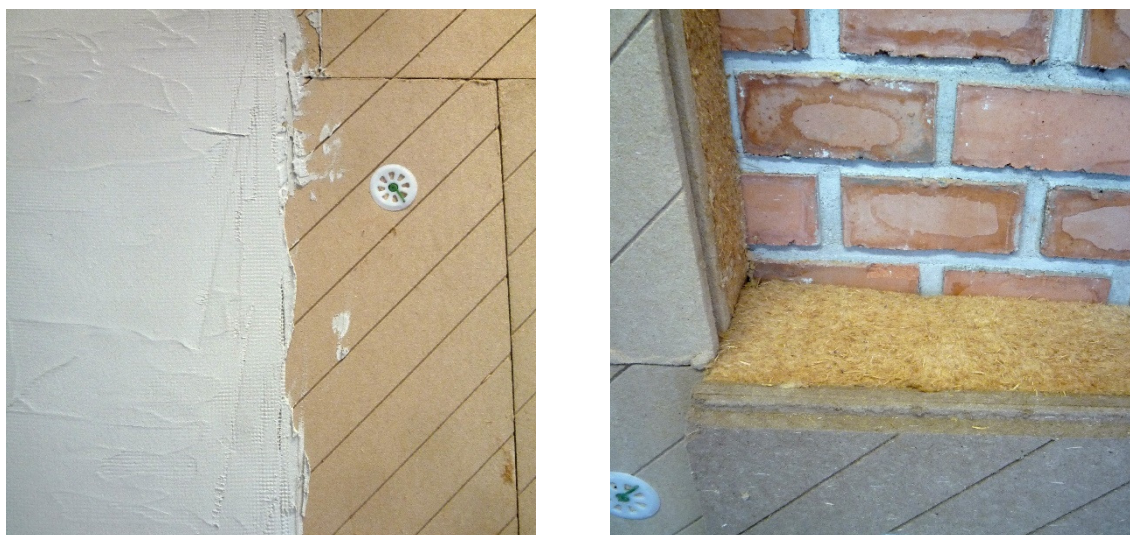
Obrázek 9 - Fotografie z realizace zateplení skladeb S1a a S1b [10]
