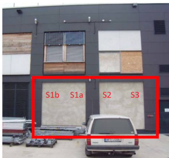
Obrázek 7 - Pohled na experimentální fasádu, zdroj [9]
