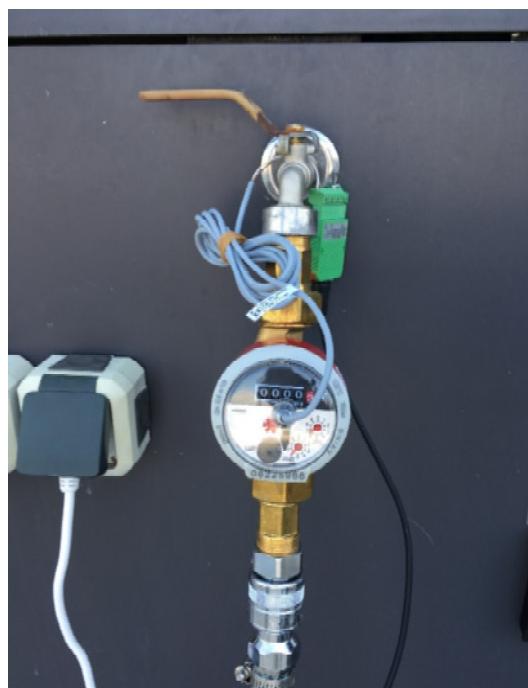
Obrázek 20 - Lopátkový vodoměr s impulzním měřičem
