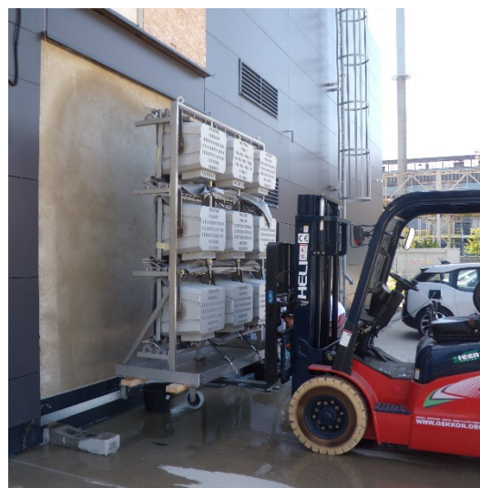
Obrázek 24 - Fotografie zachycující skrápění fasády
