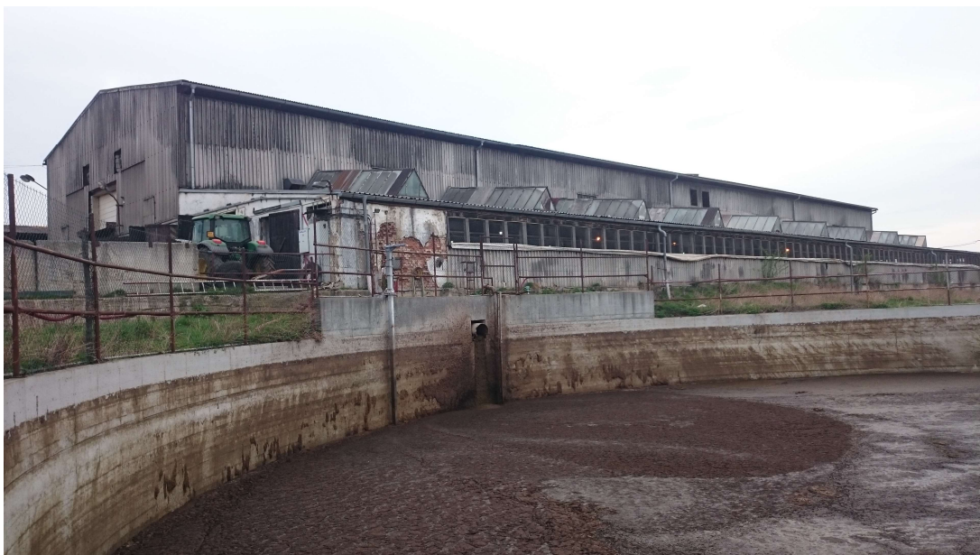
Obrázek 4: Pohled na produkční stáj přes jímku na mrvu a kejdu
