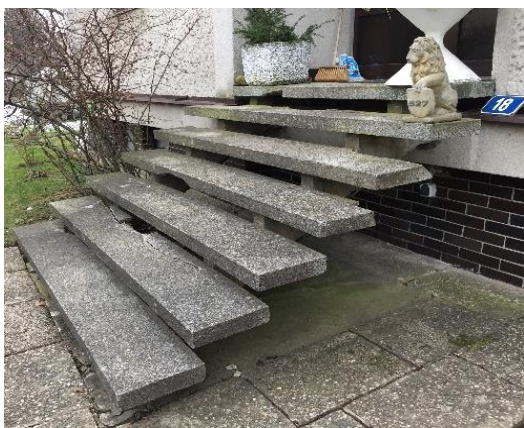
Obr. 30 Schodiště k hlavnímu vstupu
