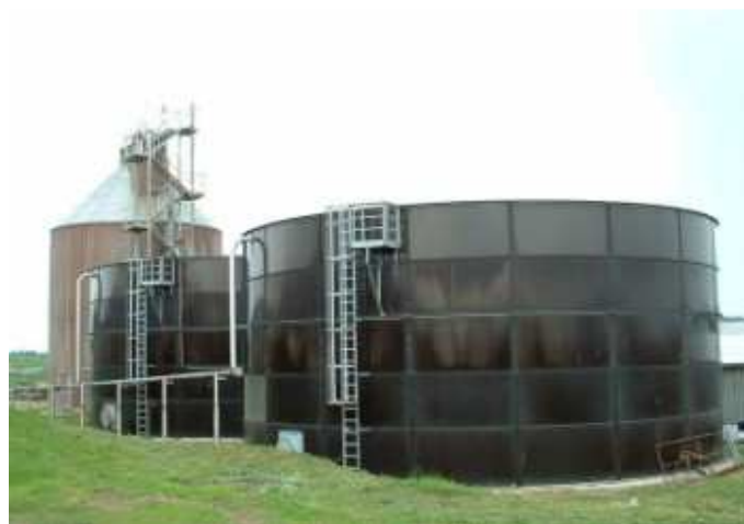
Obrázek 31 - Kontinuální systém na zpracování kejdy. Foto: EkoWATT [6]
