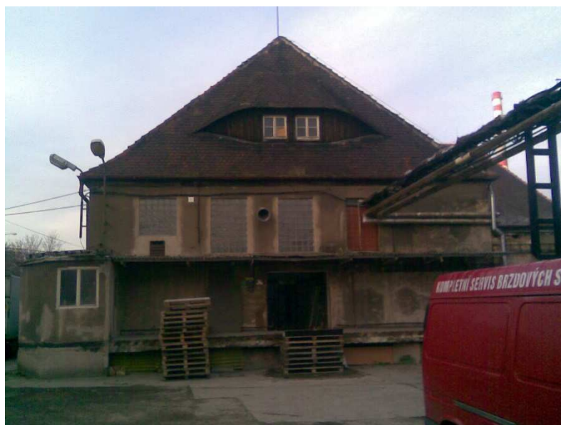
Obr. 9 : Stav před rekonstrukcí – budova B (zdroj: klempířská firma Riklepo)
