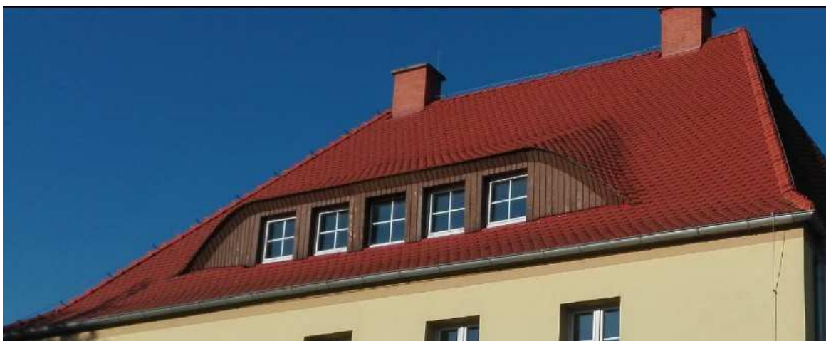
Obr. 87 : Pohled na řešenou místnost z exteriéru
