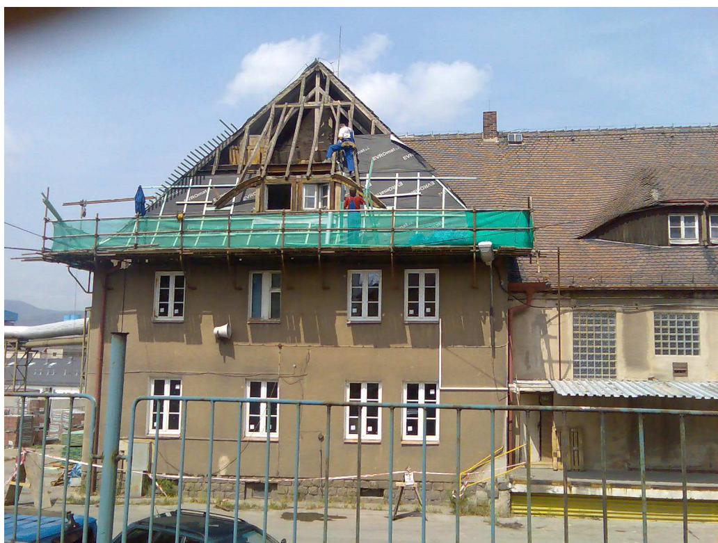
Obr. 21 : Výměna střešní krytiny na budově A (zdroj: firma Riklepo)
