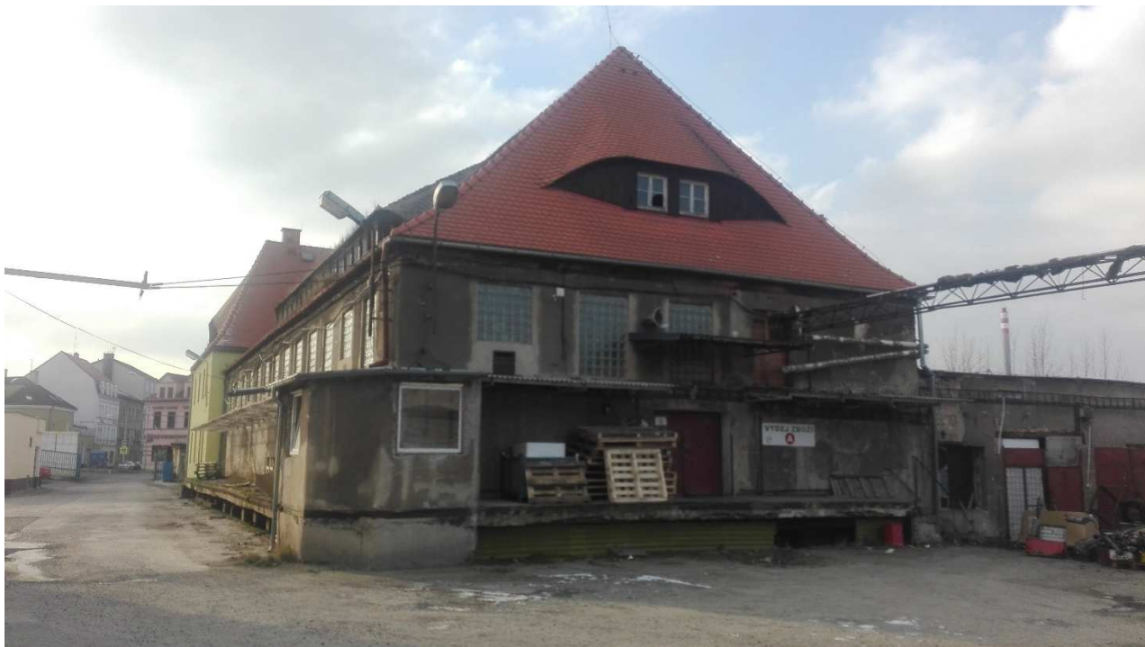
Obr. 16 : Současný stav – budova B, zadní stěna (zdroj: vlastní foto)
