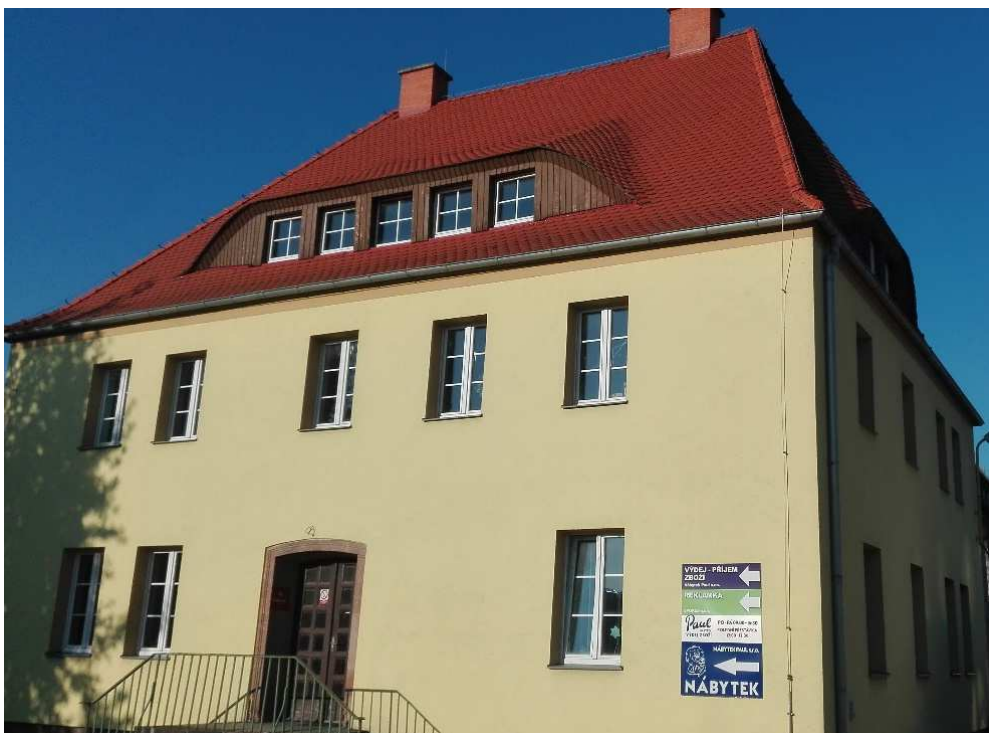
Obr. 10 : Současný stav – budova A, čelní a boční stěna (zdroj: vlastní foto)
