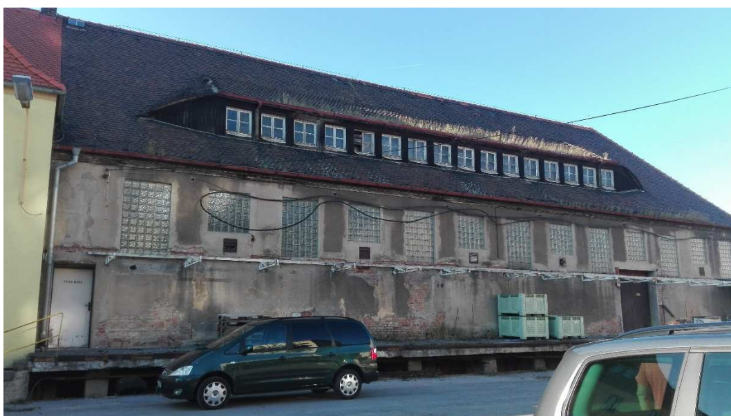
Obr. 15 : Současný stav – budova B, čelní stěna (zdroj: vlastní foto)
