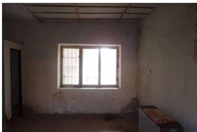
Foto F 2-17 - Pohled na JV obvodovou stěnu m. 1.05
