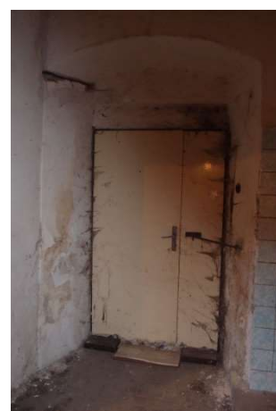
Foto F 2-20 - JV stěna vstup
