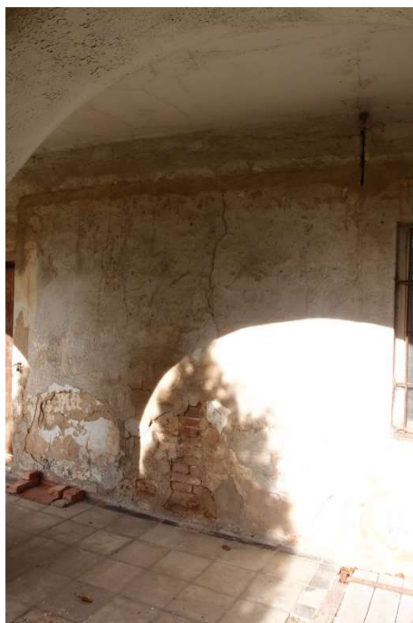
Foto F 2-92 - JV podloubí pohled na JV st.
