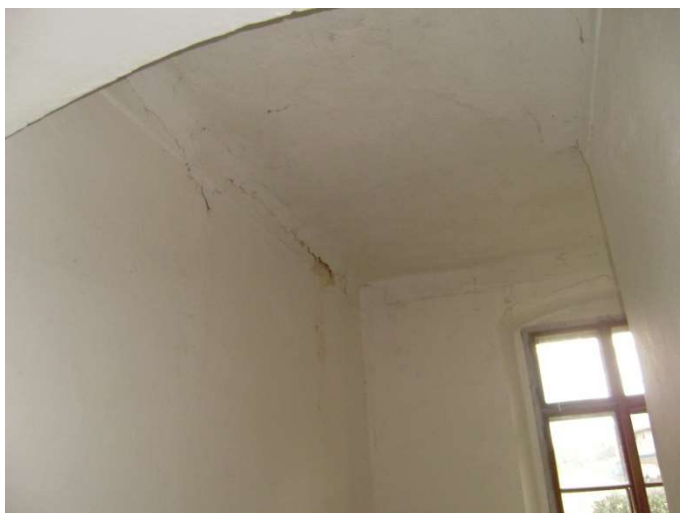
Foto F 3-4 - Strop nad schodištěm (m. 1.18) z m. 2.01
