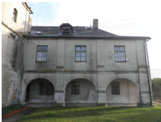
Foto F 1-6 - Pohled od jihozápadu na průčelí SV části objektu
