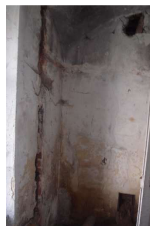
Foto F 2-76 - Pohled na JV stěnu
