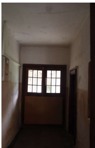
Foto F 2-59 - JV stěna m. 1.18
