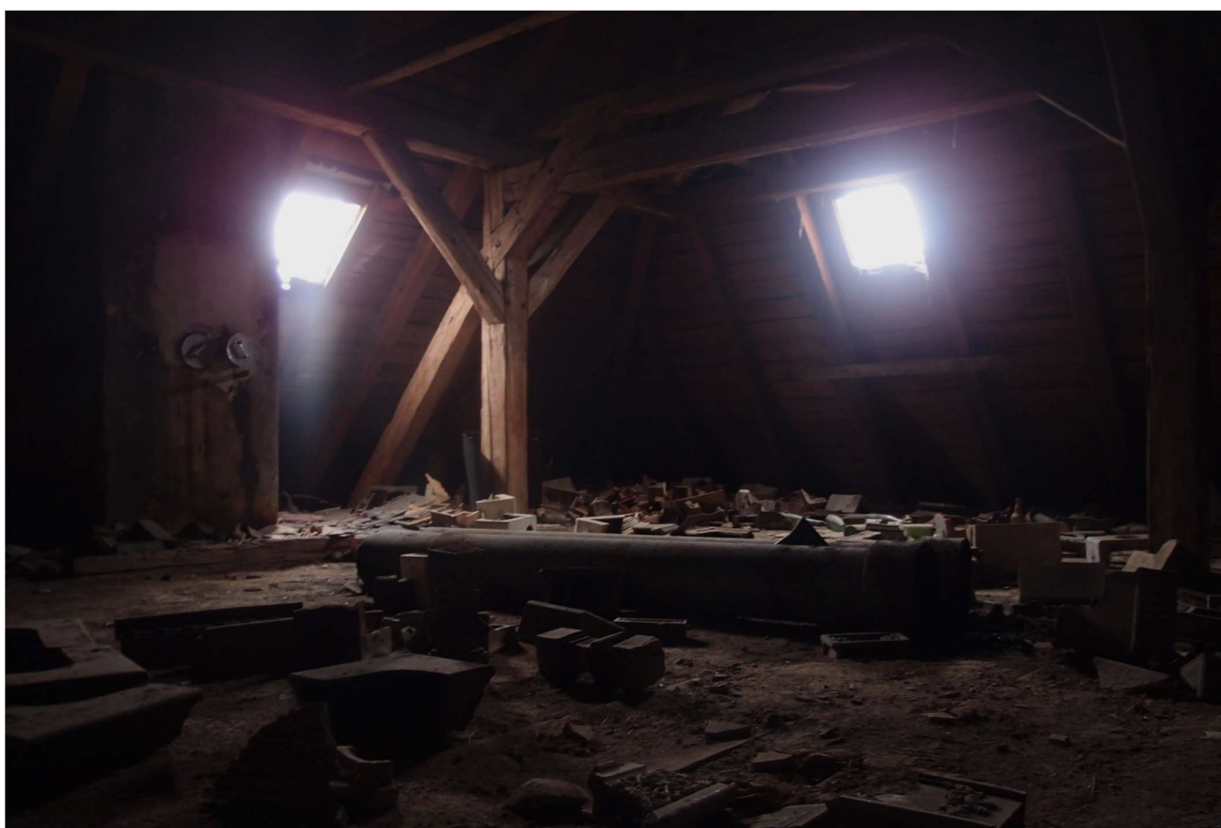
Foto F 5-16 – Jižní nároží krovu severozápadního křídla
