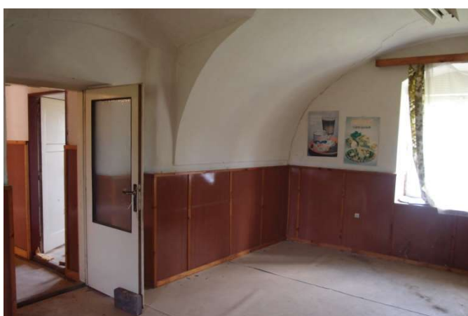
Foto F 2-50 - Pohled na S roh místnosti 1.16, vstup z m. 1.15
