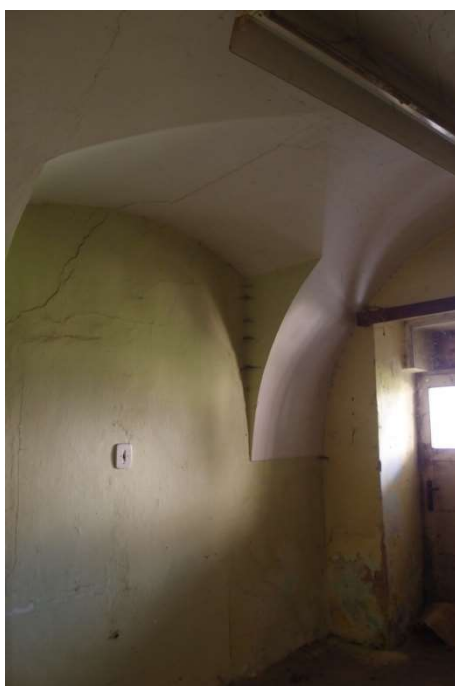
Foto F 2-54 - Pohled k J rohu m. 1.17
