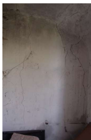
Foto F 2-75 - Pohled na SZ stěnu
