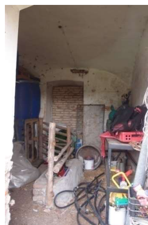
Foto F 2-8 - Pohled k JZ stěně
