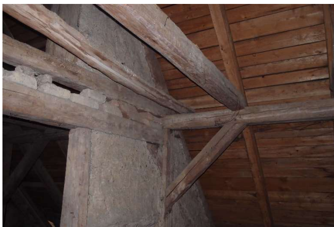
Foto F 5-4 – Plná vazba krovu s výplňovým zdívkem
