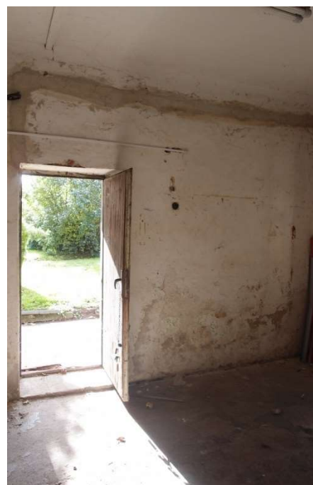
Foto F 2-13 - Pohled na vstup v jihovýchodní obv. stěně m. 1.04
