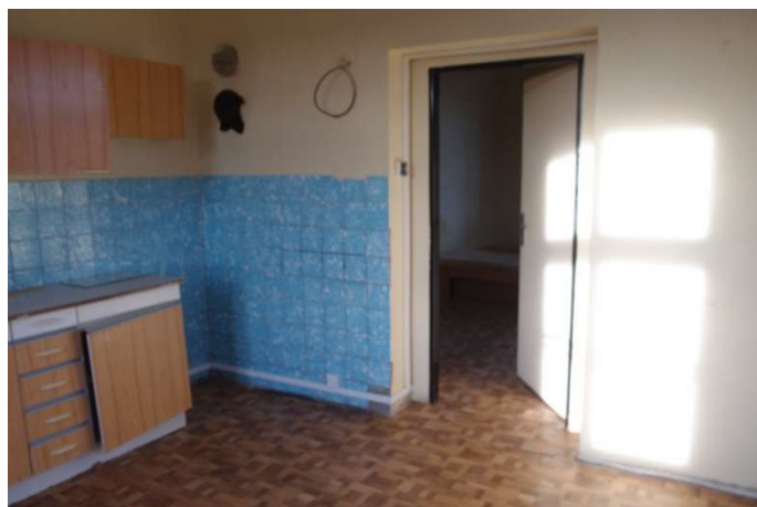
Foto F 3-70 - S roh m. 2.32
