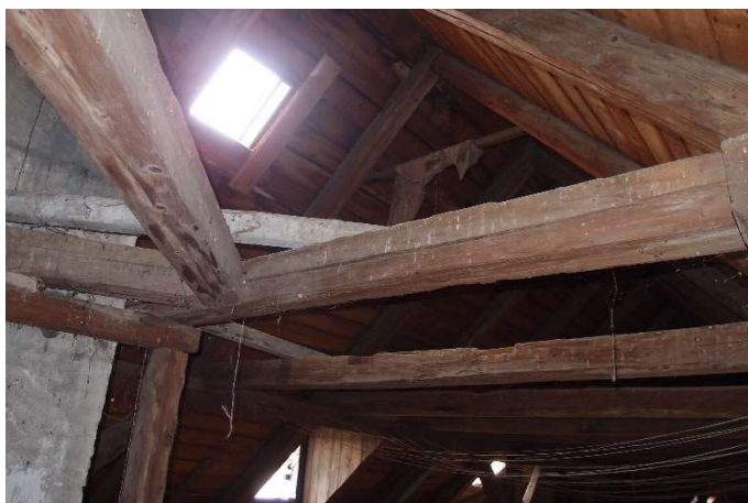
Foto F 5-14 – Hambalky nárožních a příčných vazeb
