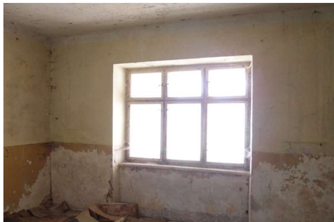
Foto F 2-80 - Pohled k J rohu m. 1.22
