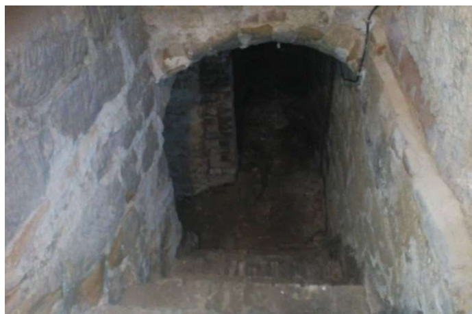
Foto F 4-1 - Schodiště mezi m. 0.01 a 0.03, z m. 0.01
