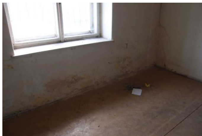
Foto F 2-45 - SV obvodová stěna - parapet okna
