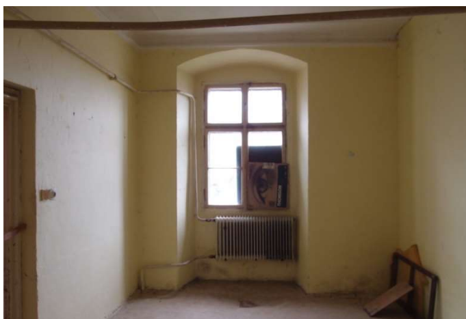
Foto F 3-21 - SZ obvodová stěna m. 2.15 od JV
