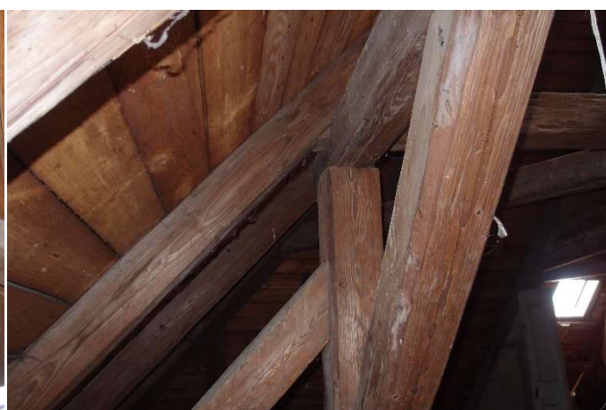
Foto F 5-11 – Detail osazení krokve na hambalek
