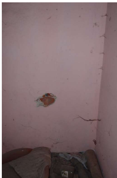
Foto F 3-47 - SZ stěna m.2.25 z m. 2.25
