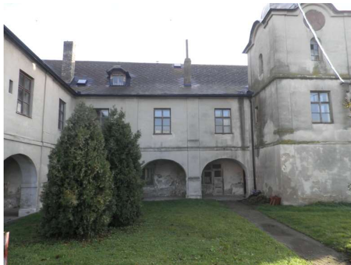
Foto F 1-4 - Pohled od jihozápadu na průčelí SV části objektu a věž
