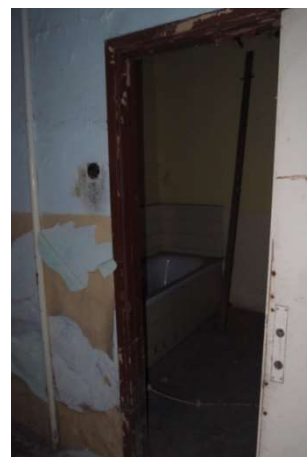
Foto F 3-45 - JV stěna m.2.24
