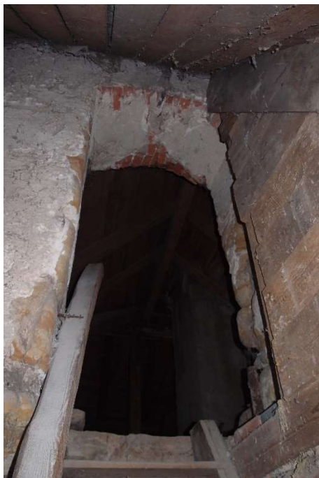
Foto F 5-1 – Vstup do krovu ze schodiště
