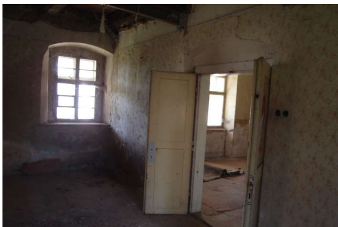
Foto F 2-83 - Pohled k Z rohu m. 1.23, dveře do m. 1.22
