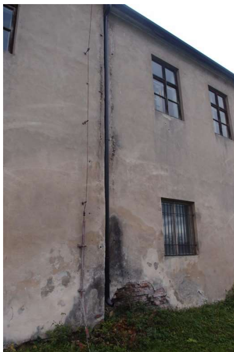
Foto F 1-10 - Detailní pohled v místě půdorysného uskočení SV fasády
