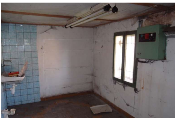
Foto F 2-34 - Pohled na západní roh místnosti 1.11
