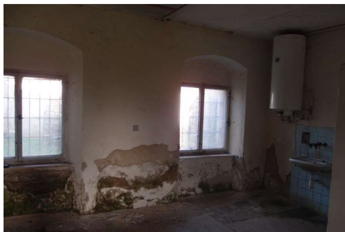
Foto F 2-15 - Pohled na SZ obvodovou stěnu místnosti 1.05
