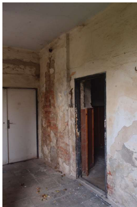
Foto F 2-93 - JZ podloubí J vnitřní roh
