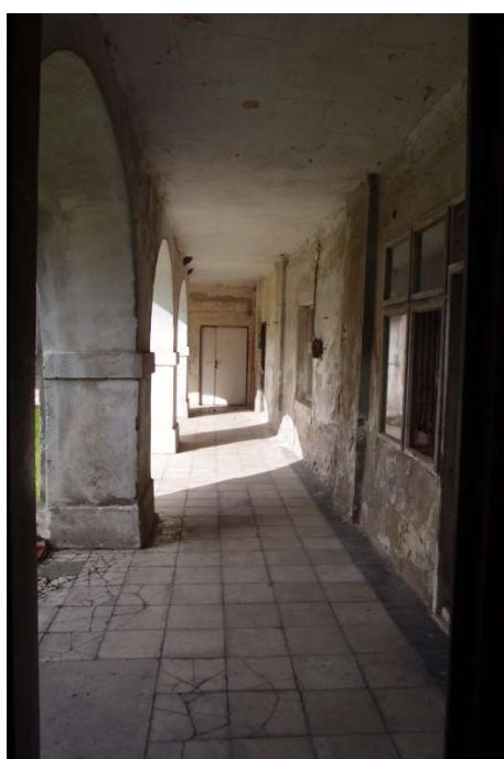
Foto F 2-96 - JZ podl. pohled od věže na SZ
