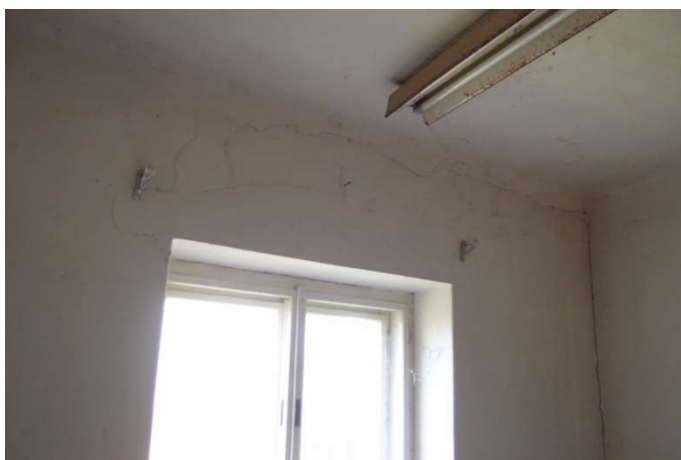
Foto F 2-44 - SV obvodová stěna- nadpraží okna
