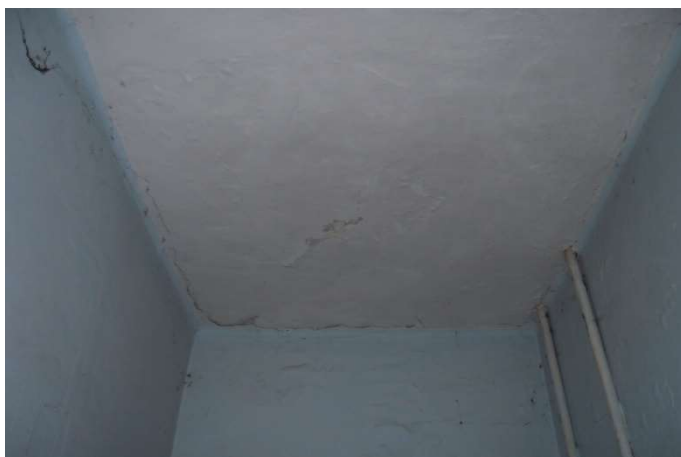
Foto F 3-43 - Pohled na styk SV stěny m. 2.24 a stropu
