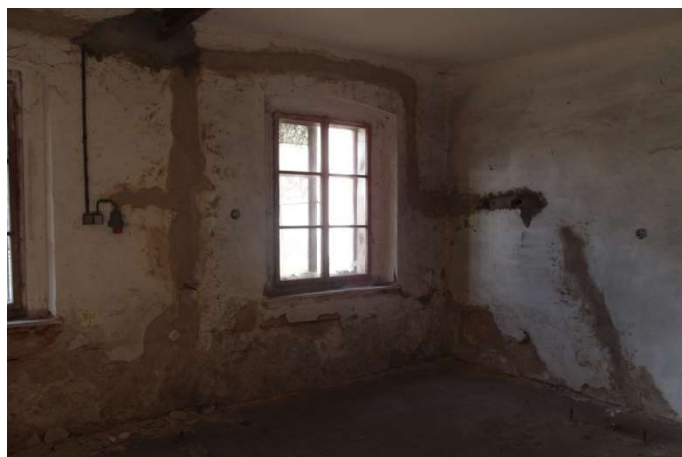
Foto F 2-10 - Pohled na JZ obvodovou stěnu z místnosti 1.04
