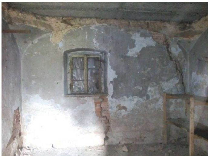
Foto F 2-4 - Pohled na SZ obv. stěnu m. 1.02
