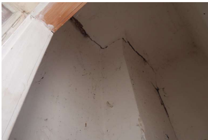
Foto F 3-63 - Styk stopu a stěny m. 2.31, thlina
