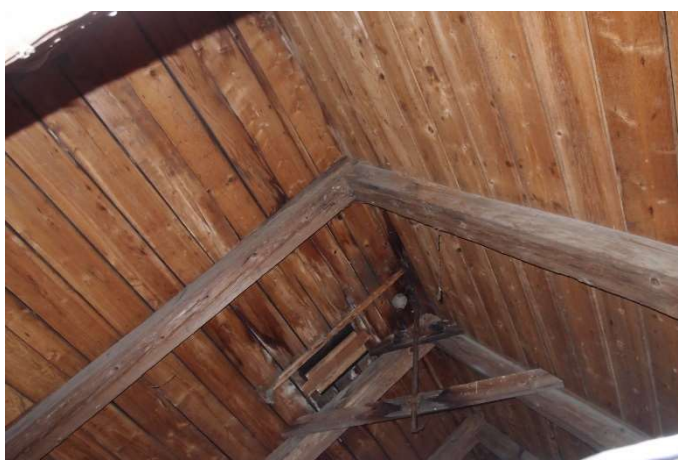
Foto F 5-10 – Detail spojení krokví
