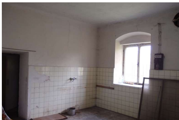
Foto F 2-32 - Pohled na severní roh místnosti 1.10
