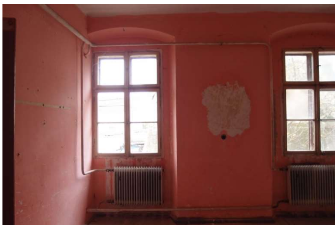
Foto F 3-19 - JZ obvodová stěna m. 2.14
