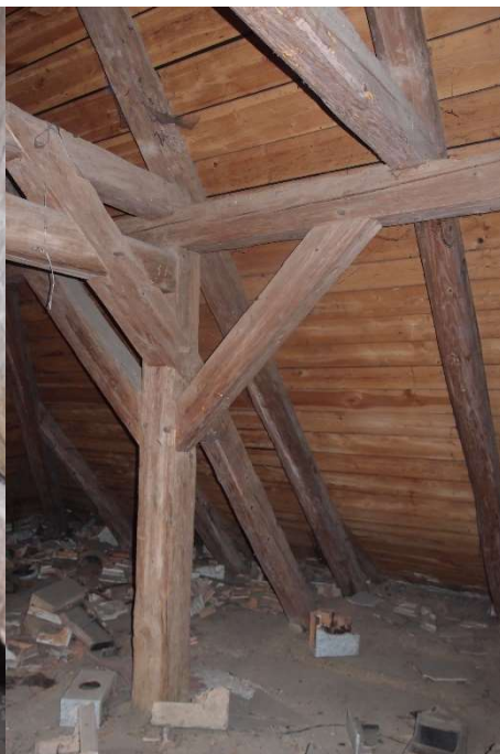
Foto F 5-3 – Sloupek plné vazby (západ)
