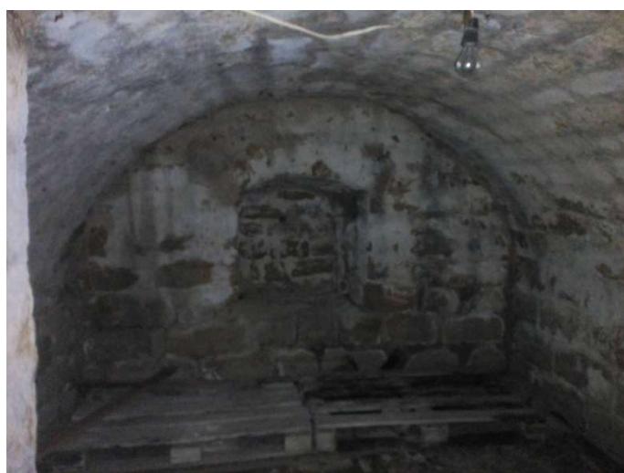
Foto F 4-4 - JV stěna m.0.04
