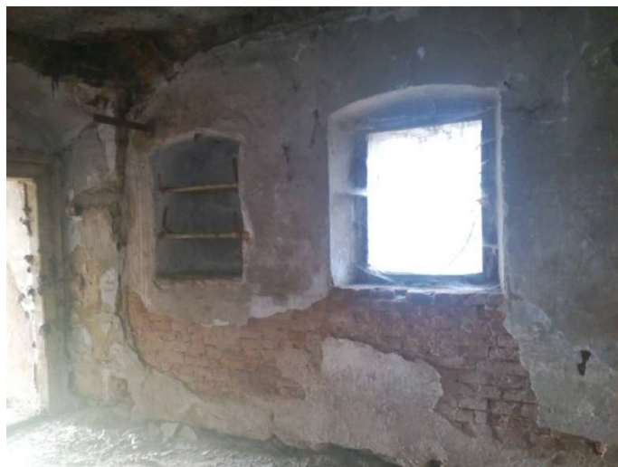
Foto F 2-5 - Pohled k jižnímu rohu m. 1.02
