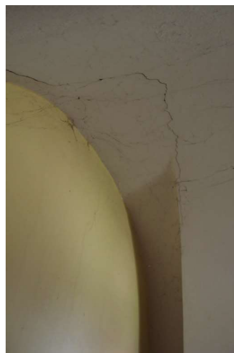
Foto F 2-56 - Pohled na V roh m. 1.17
