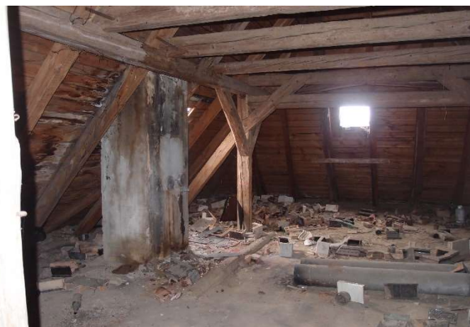
Foto F 5-5 – Pohled k jižnímu rohu severovýchodní části krovu
