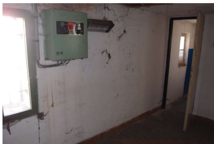
Foto F 2-35 - Pohled na severní roh místnosti 1.11
