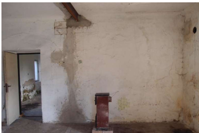
Foto F 2-9 - Pohled na vnitřní stěnu mezi 1.04 a 1.05 z místnosti 1.04
