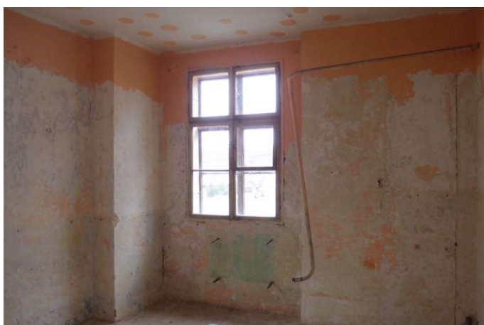
Foto F 3-12 - Pohled k J rohu od S m. 2.12
