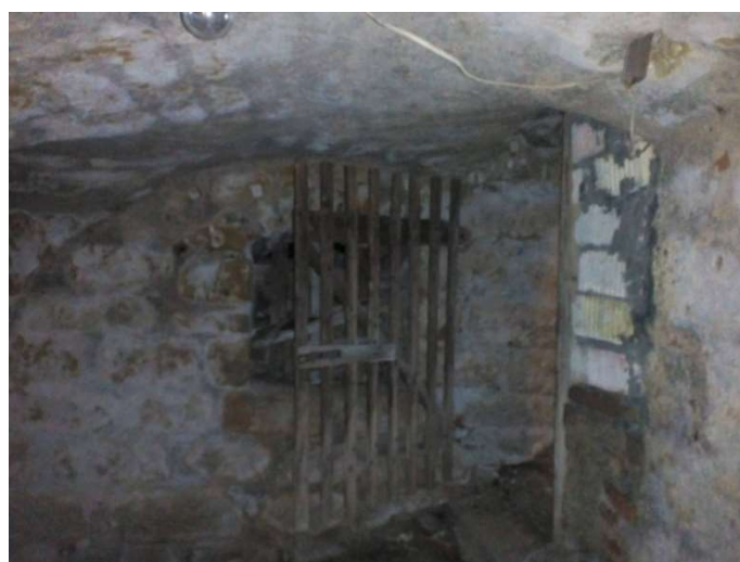
Foto F 4-5 - SZ stěna m. 0.04
