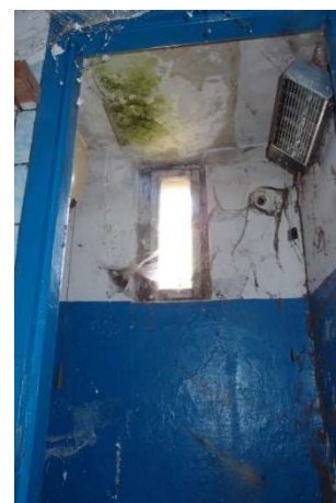
Foto F 2-38 - Podhled WC
