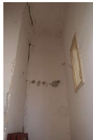
Foto F 3-65 - SZ stěna m. 2.31
