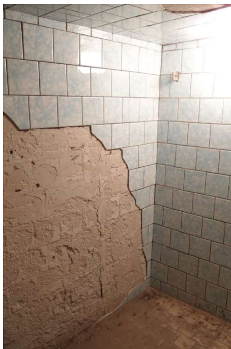
Foto F 2-22 - Pohled na V roh m. 1.07
