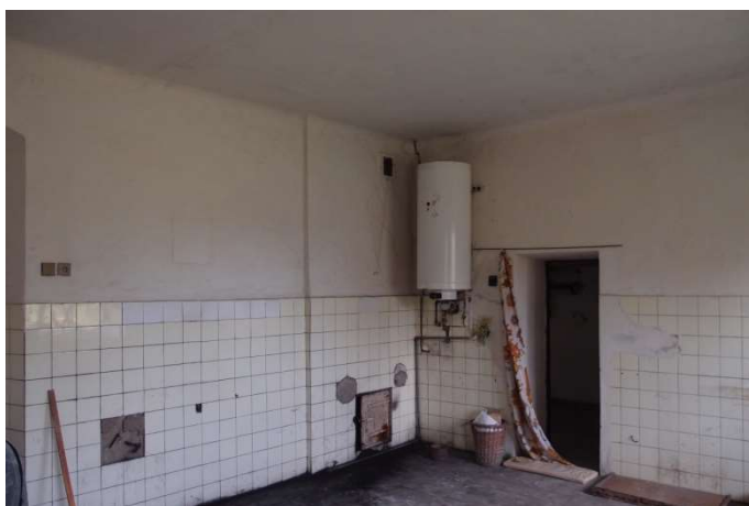
Foto F 2-31 - Pohled na západní roh místnosti 1.10
