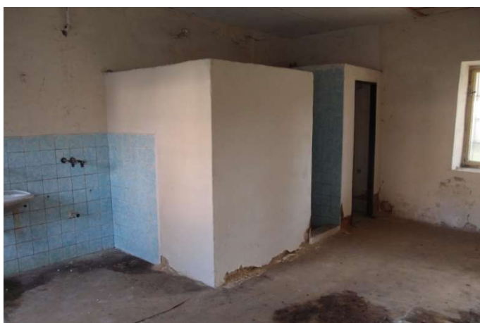
Foto F 2-16 - Vnitřní příčky sprchy a WC - V roh m. 1.05
