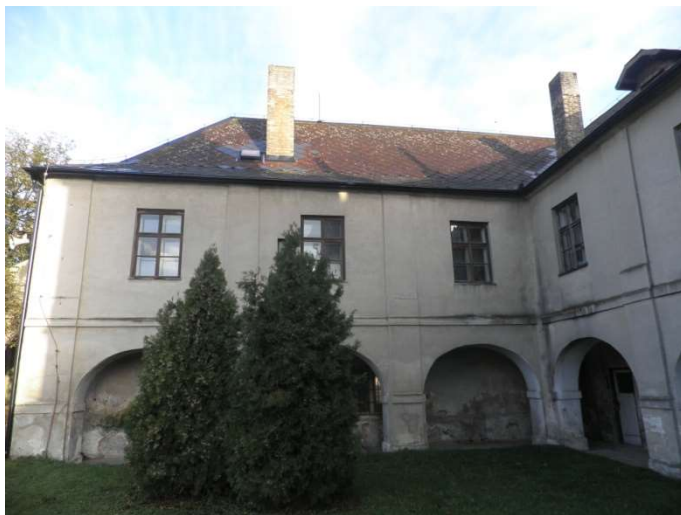
Foto F 1-3 - Pohled od jihovýchodu na průčelí SZ části objektu
