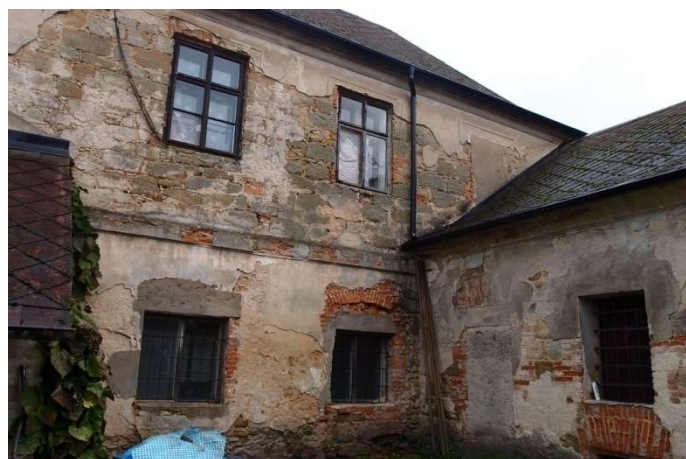
Foto F 1-13 - Pohled od severozápadu na SZ fasádu
