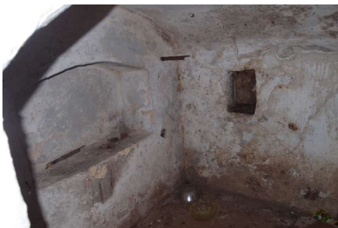
Foto F 2-69 - Sklepní prostory pod m. 1.20, pohled k Z rohu
