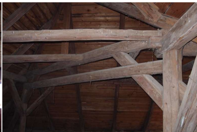
Foto F 5-7 – Diagonální hambalek s zopěrami u středu styku křídel
