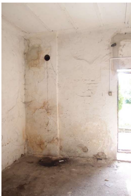
Foto F 2-11 - Pohled na komín při JV obvodové stěně z m. 1.04
