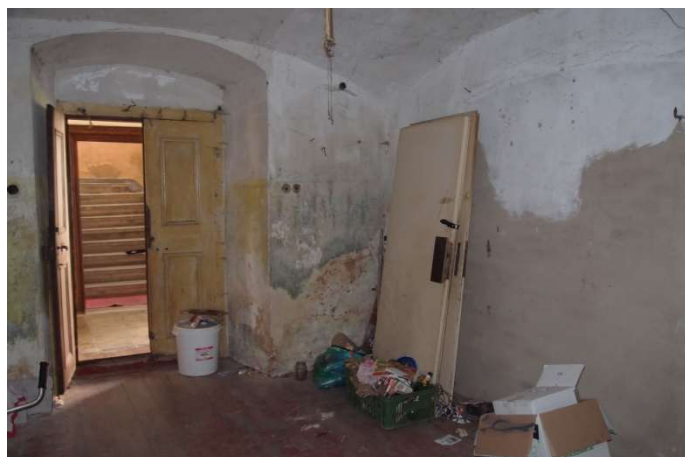
Foto F 2-65 - Pohled na Z roh m. 1.19, spoj. dveře mezi 1.18 a 1.19
