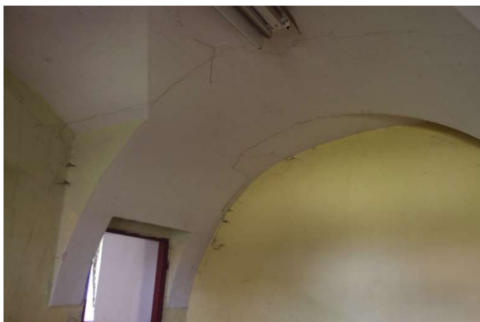
Foto F 2-57 - Soustava kleneb nad m. 1.17 - S roh, thliny kleneb
