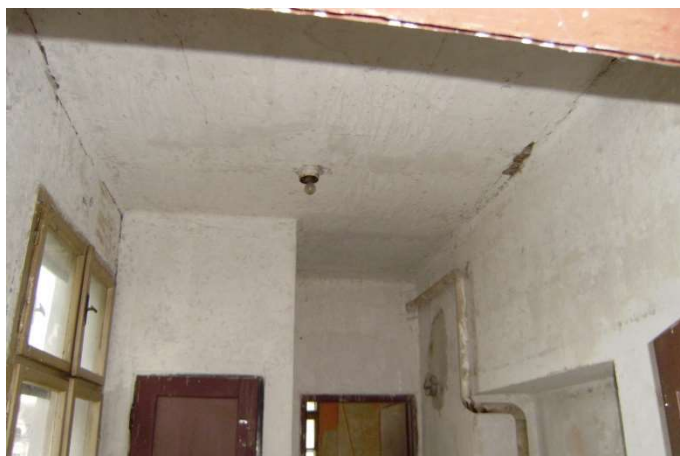
Foto F 3-9 - Pohled na styk JZ stěn a stropu m. 2.10
