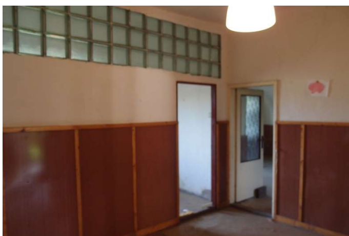
Foto F 2-48 - Pohled na V roh m. 1.15, vstupy do m. 1.14 a 1.16
