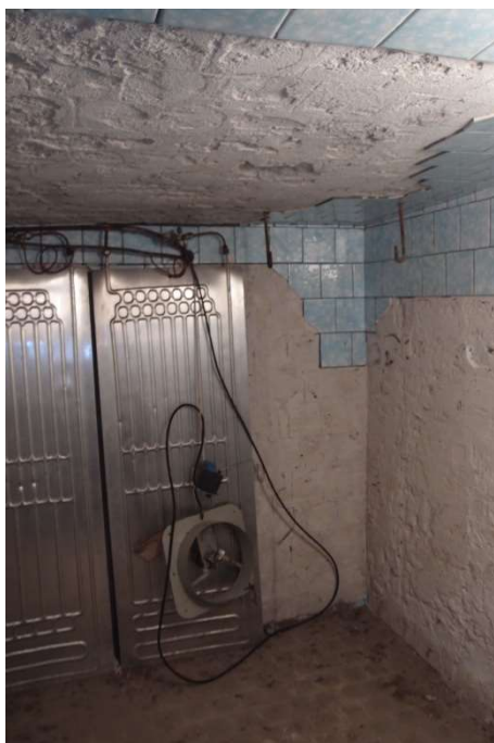
Foto F 2-21 - Pohled na SZ stěnu m. 1.07
