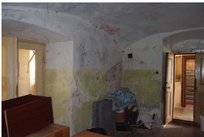
Foto F 2-64 - Pohled k S rohu, dveře mezi do 1.18 a 1.22
