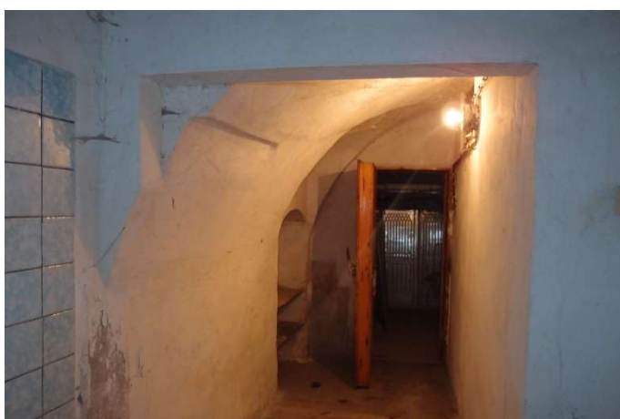
Foto F 2-18 - Pohled na SZ obvodovou stěnu
