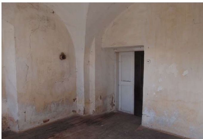
Foto F 2-89 - Pohled na Z roh místnosti 1.25
