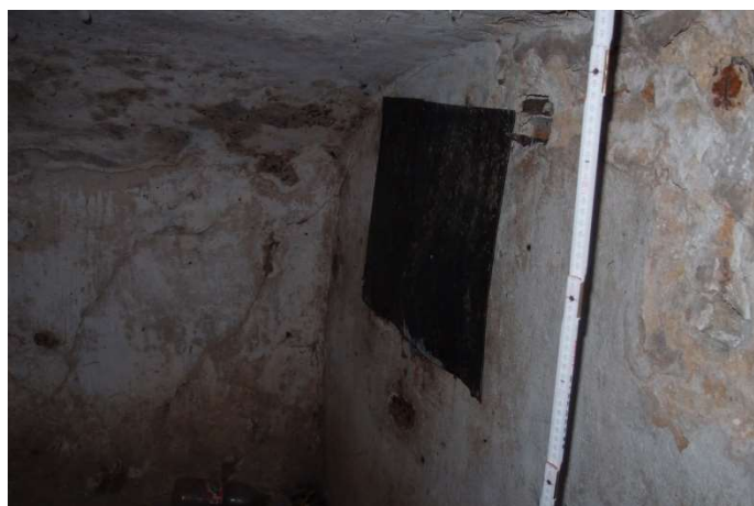
Foto F 2-70 - Sklepní prostory pod m 1.20, pohled k S rohu
