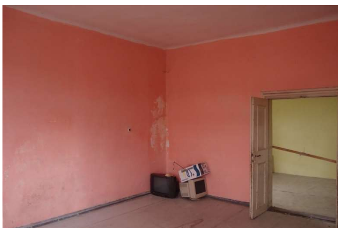
Foto F 3-17 - Pohled k S rohu m. 2.14 od J
