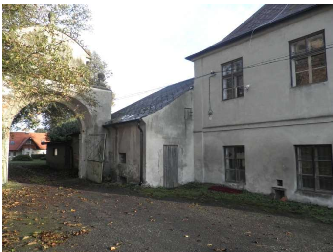
Foto F 1-1 - Pohled od jihu na JZ fasádu
