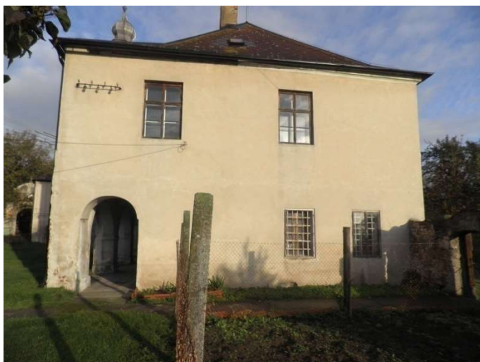
Foto F 1-7 - Pohled od jihovýchodu na JV fasádu
