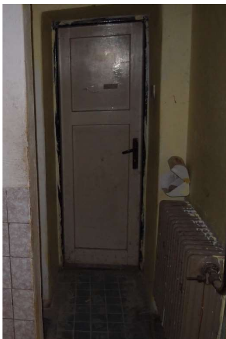
Foto F 3-26 Pohled na m. 2.17 z m. 2.16
