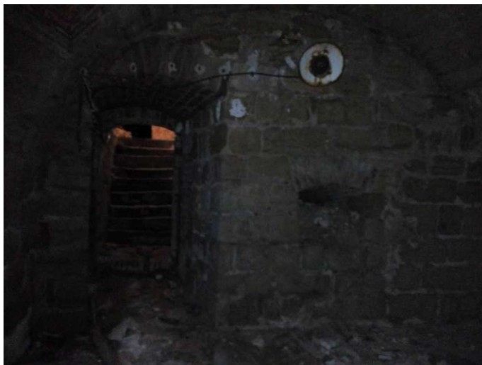
Foto F 4-6 - JV stěna m.0.05
