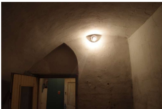
Foto F 2-26 - JV stěna mezi m. 1.08 a 1.09
