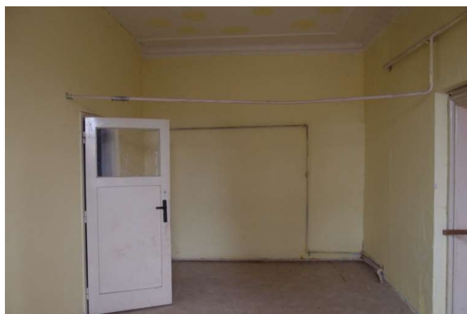
Foto F 3-22 - JV stěna m. 2.15 od SZ
