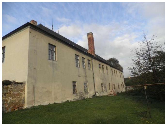
Foto F 1-8 - Pohled od východu na severovýchodní fasádu
