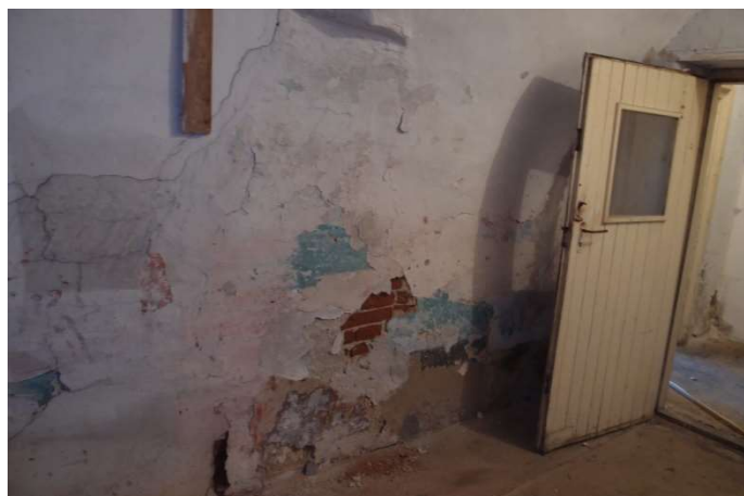
Foto F 2-27 - SV stěna místnosti 1.09
