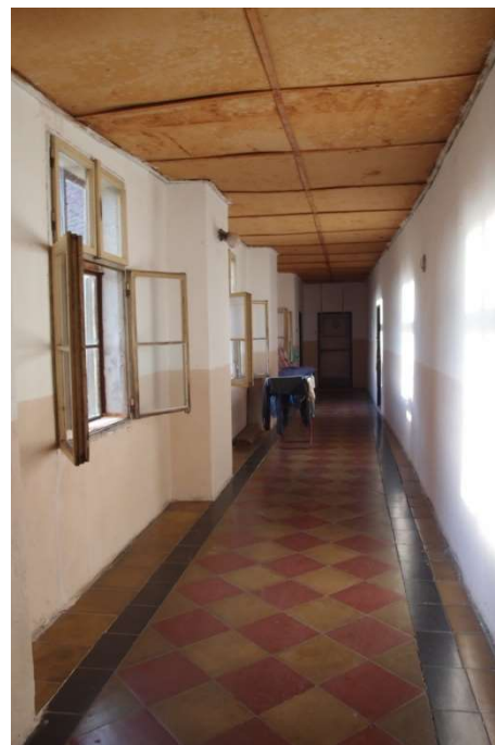
Foto F 3-3 - Pohled od středu m.2.01 k SZ
