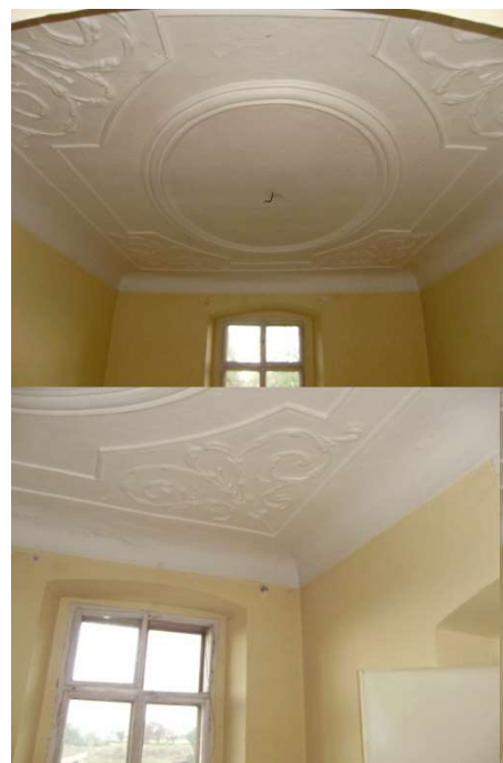
Foto F 3-73 - Arch zprac. stropu m. 2.34
