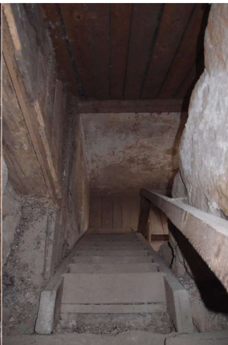
Foto F 5-2 – Schodiště do podkroví
