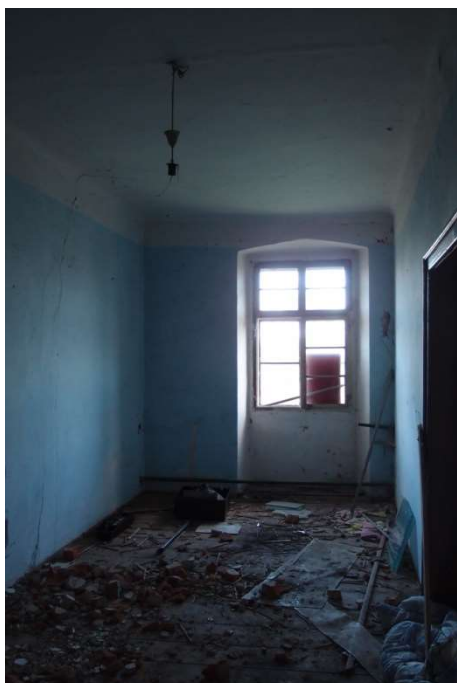
Foto F 3-57 - Pohled na SVstěnu m. 2.29
