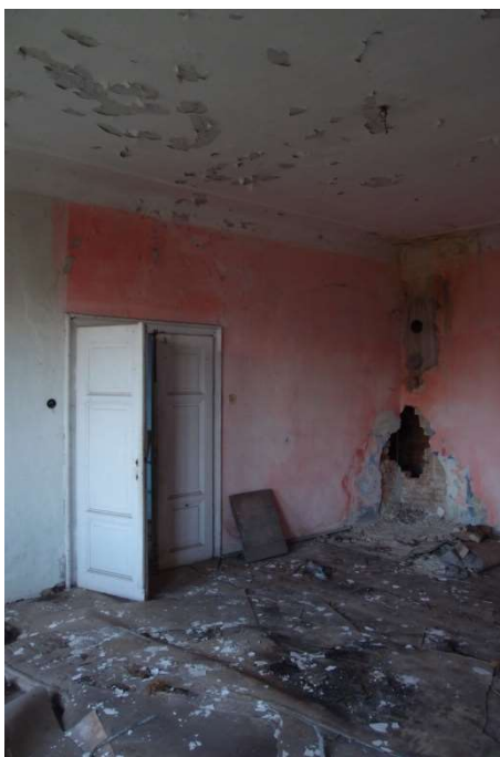
Foto F 3-55 - Pohled na J roh m. 2.28 od S
