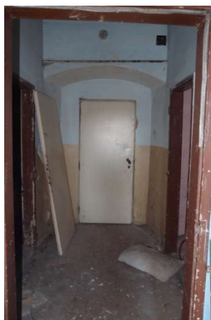
Foto F 3-44 - Vstup bytu, m.2.24
