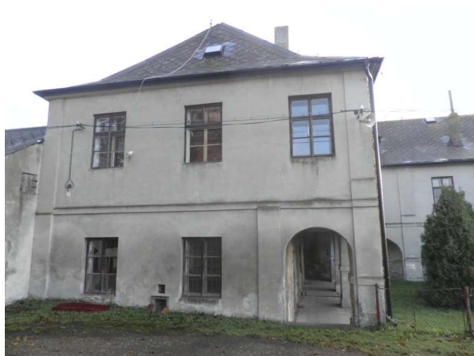
Foto F 1-2 - Pohled od jihozápadu na JZ fasádu
