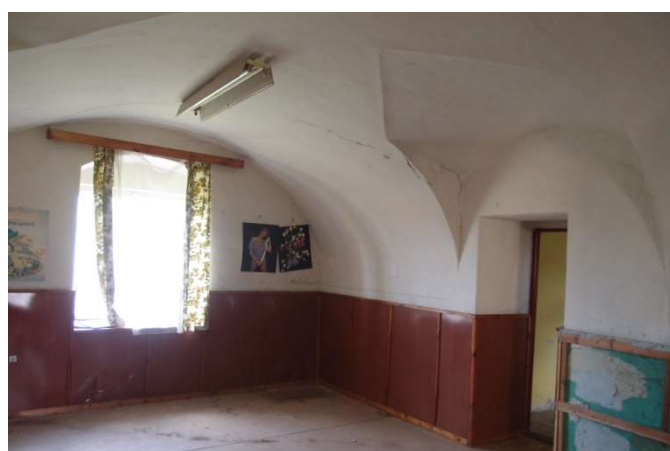
Foto F 2-51 - Pohled na V roh místnosti 1.16, vstup do m. 1.17
