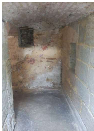
Foto F 4-2 - SZ stěna m. 0.01
