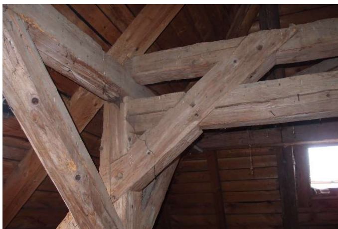
Foto F 5-6 – Detail spoje sloupku s hambalkem, vzpěrou a rozpěrou
