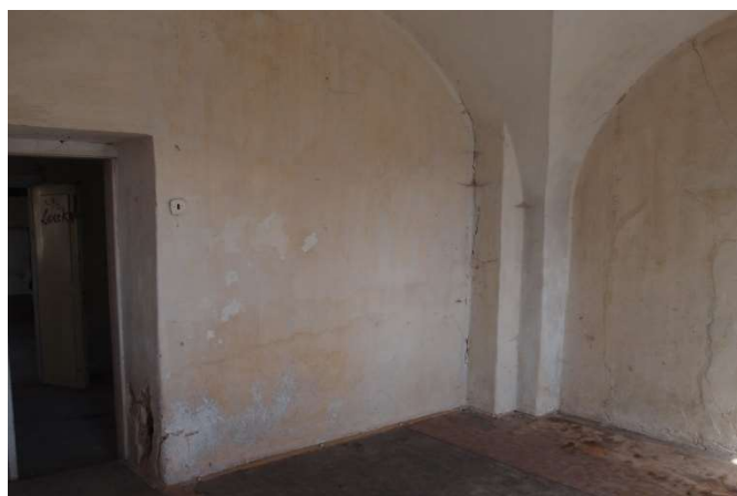
Foto F 2-88 - Pohled na S roh místnosti 1.25
