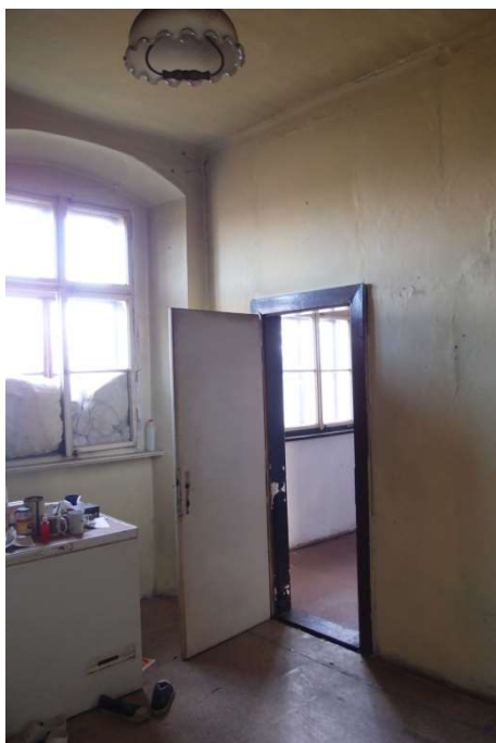
Foto F 3-37 - Pohled na V roh m. 2.22
