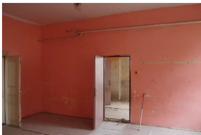
Foto F 3-18 - Pohled na příčku mezi 2.12 a 2.14 z m. 2.14
