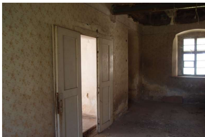
Foto F 2-82 - Pohled k J rohu m. 1.23, dveře do m. 1.25, dál do 1.24
