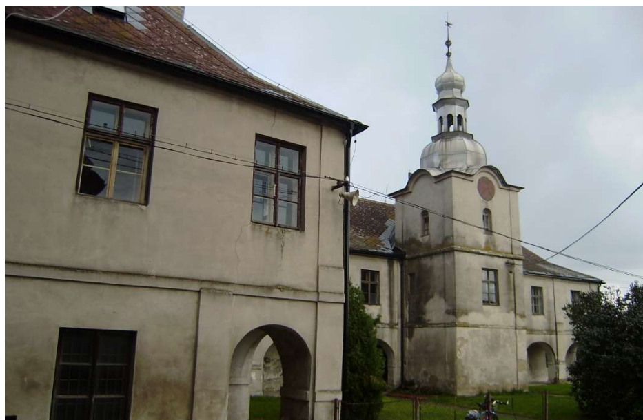
Obr. 1 - Pohled na budovu zámku od Západu
