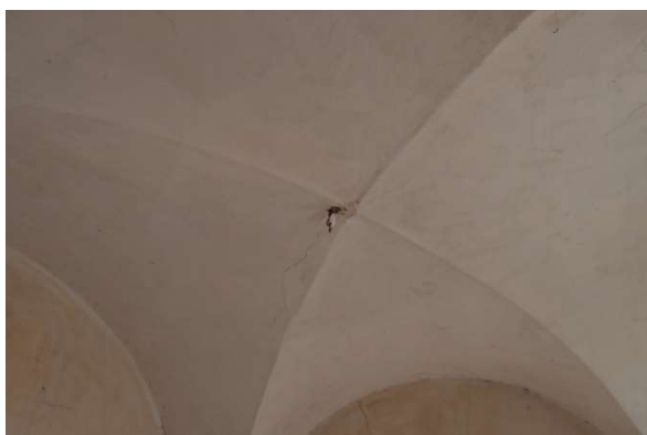
Obr. 20 - Křížová klenba nad místností m. 1.25
