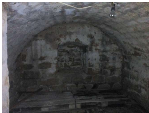
Obr. 19 – Kamenné stěny a valená klenba v úrovni nižšího sklepa (m. 0.04)
