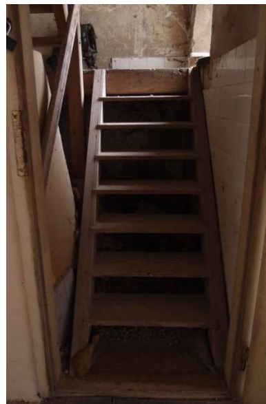
Obr. 26 - Schodiště do podkrovi
