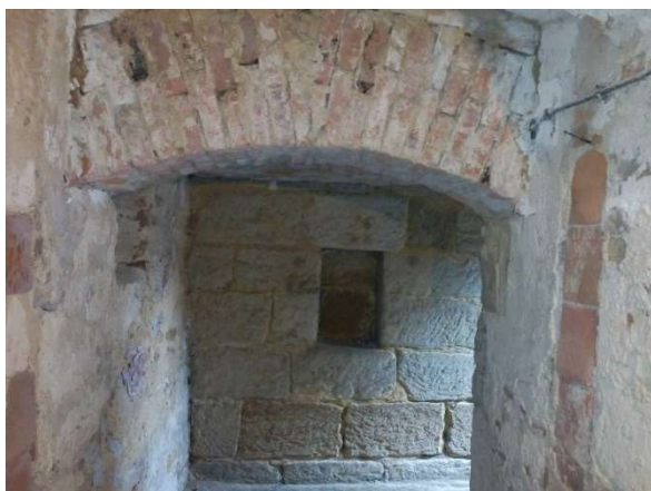
Obr. 18 – Kombinace cihelného a kamenného zdiva z opravených kvádrů ve vyšší úrovni sklepa (m. 0.02)
