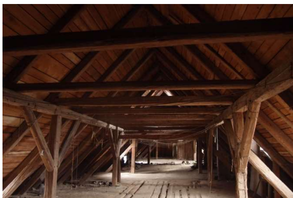
Obr. 28 - Pohled na krov, plné vazby 2. typu
