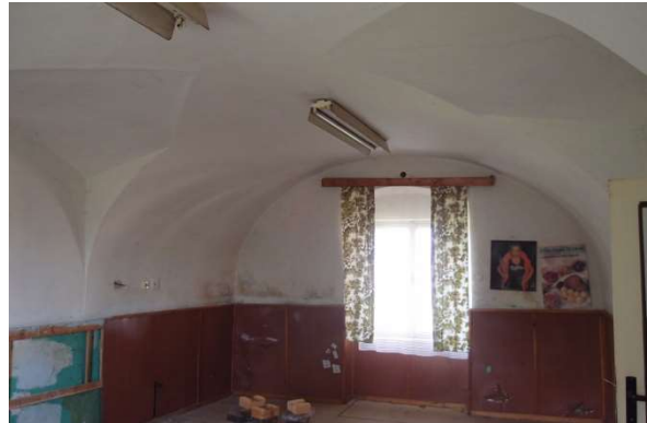
Obr. 23 - Valená klenba s lunetami nad místností 1.16
