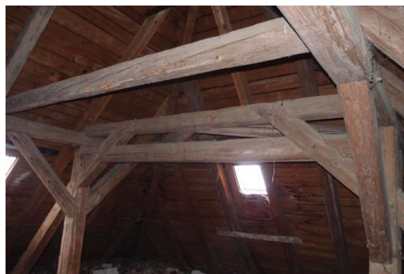
Obr. 29 - Vazba 1. typu v oblasti valby střechy
