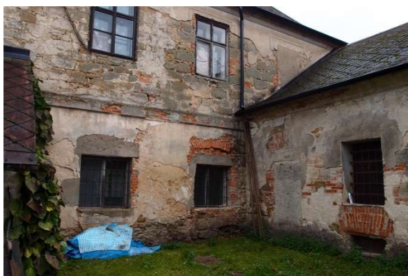
Obr. 16 - Pohled od severu na styk hl. lodi a příz. objektu
