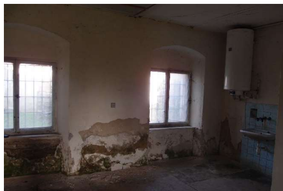
Obr. 44 – Pohled k severnímu rohu místnosti 1.05
