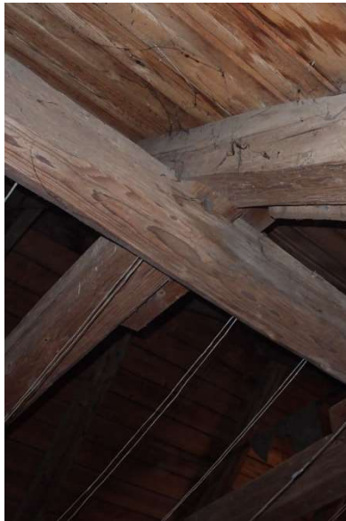
Obr. 31 - Spojení hambalku s vaznicí a krokví
