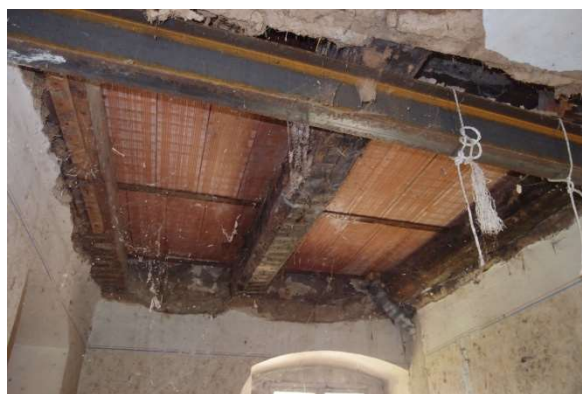
Obr. 21 -Obnažená konstrukce trámového stropu nad m.1.23
