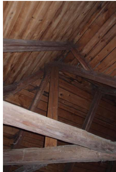
Obr. 32 - Sloupek vynášející spoj krokví v severní části půdorysu
