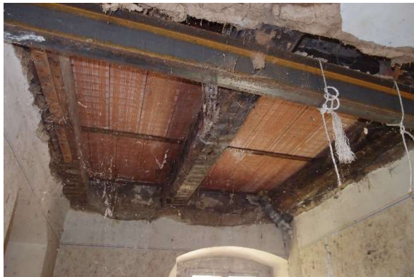
Obr. 49 – Strop nad místností 1.23
