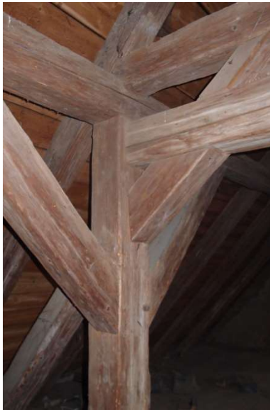
Obr. 30 - Zapuštění šikmé vzpěry do ostatních prvků krovu
