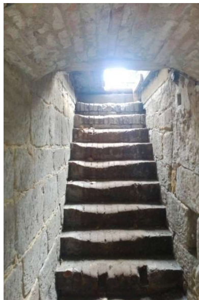
Obr. 24 - Schodiště mezi 1. PP a ext.
