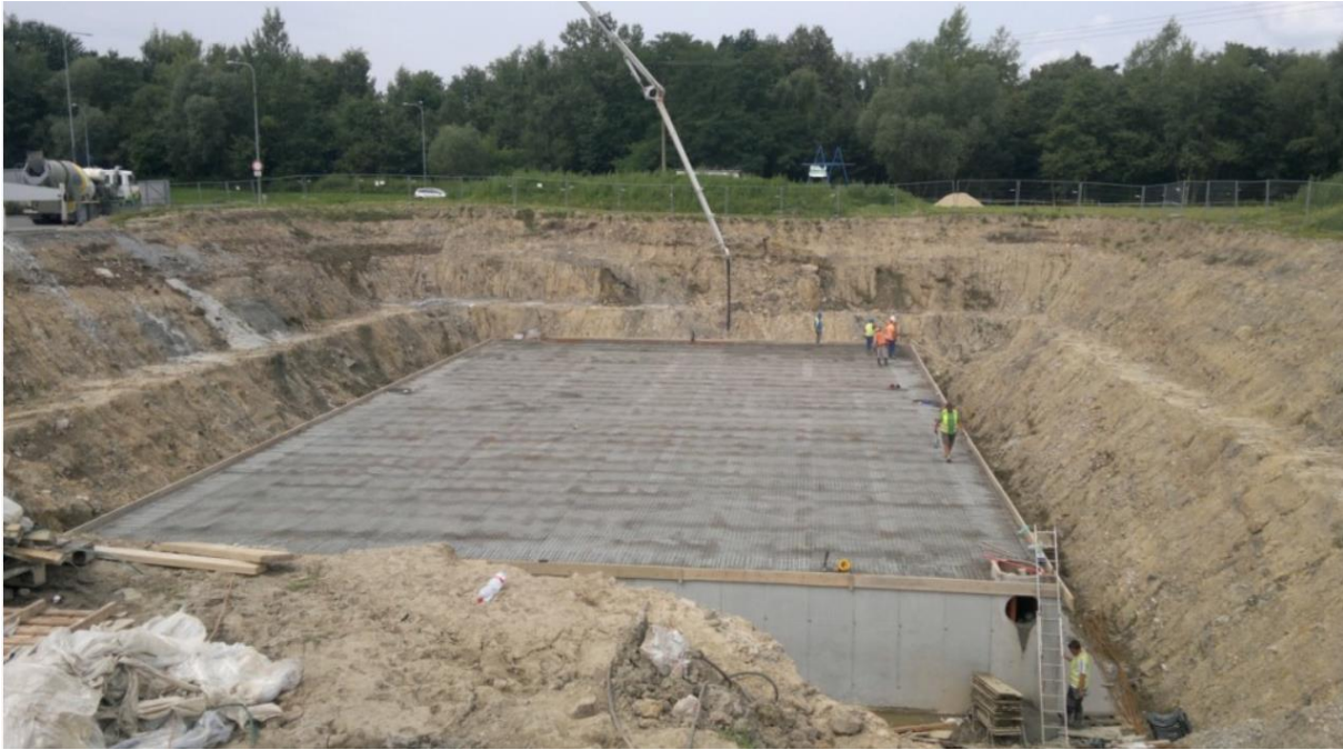
Obr. 1 Svahovaný výkop [2]
