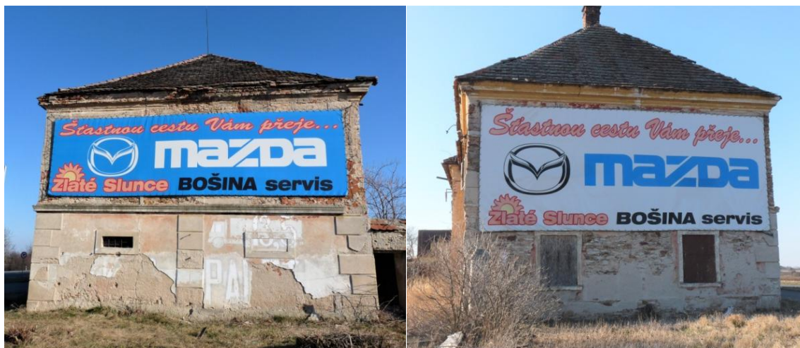
Obrázek 7,8 – Západní a východní fasáda objektu, 2018
