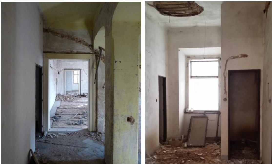
Obrázek 17,18 – Schodišťová chodba a vestavba toalet v patře domu, 2018
