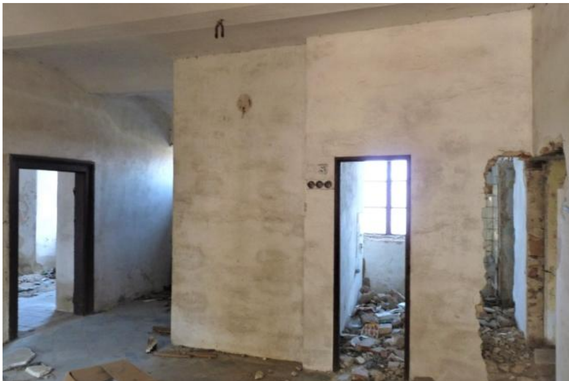
Obrázek 11 – Vestavba hygienických zařízení do vstupní haly, 2018
