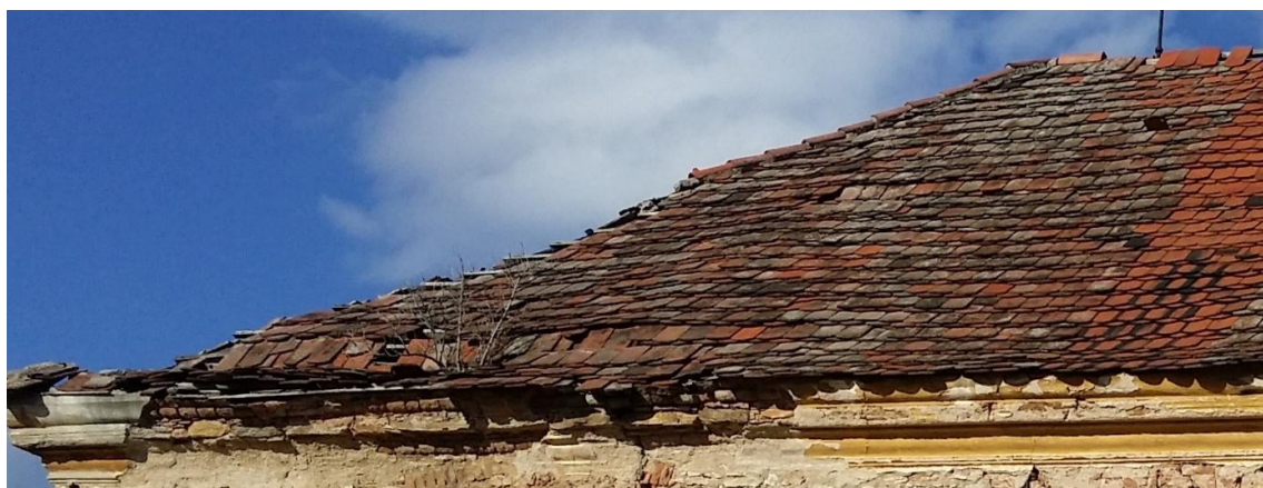
Obrázek 42 – Sřešní krytina nad západním křídlem objektu, 2018
