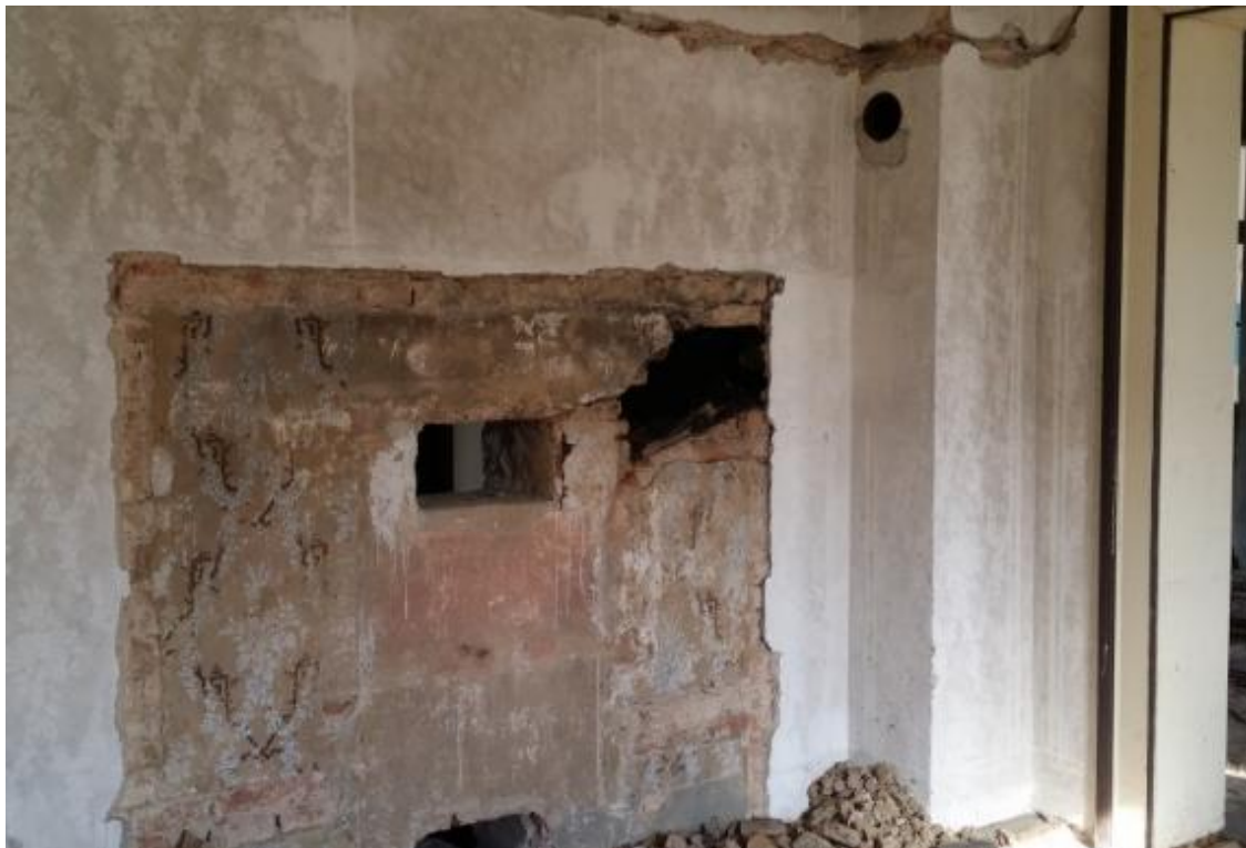
Obrázek 29 – Komínové těleso a vyústění sopouchu v místnosti 2.NP, 2018
