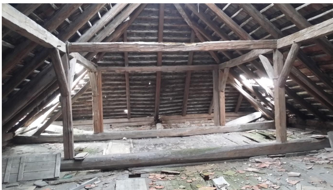
Obrázek 45 – Soustava krovu v ohrožené záp. části se sesunutou poslední plnou vazbou, 2018
