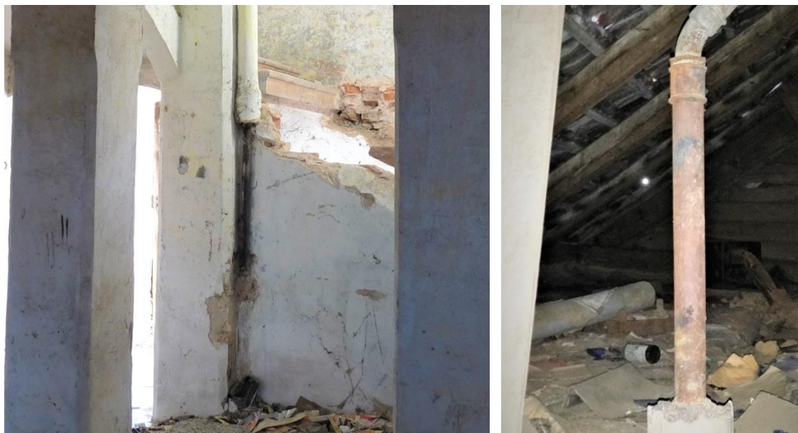
Obrázek 47, 48 – Rozvod vnitřního vodovodu v oblasti schodiště a krovu, 2018
