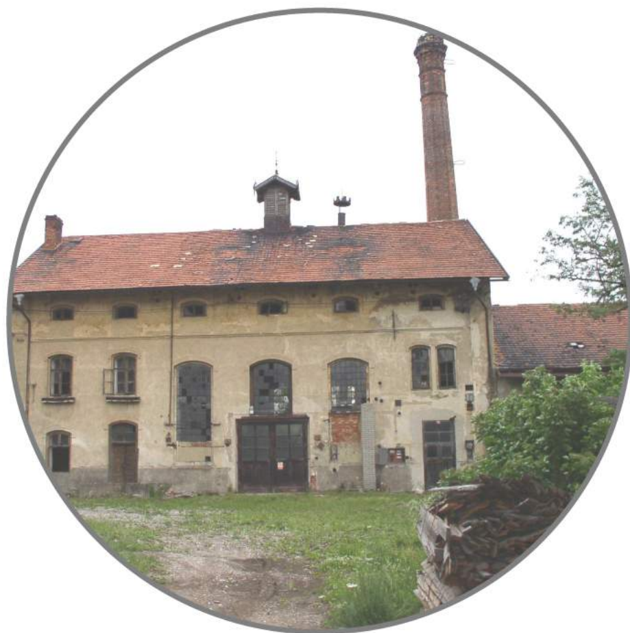
Pohled na západní fasádu
