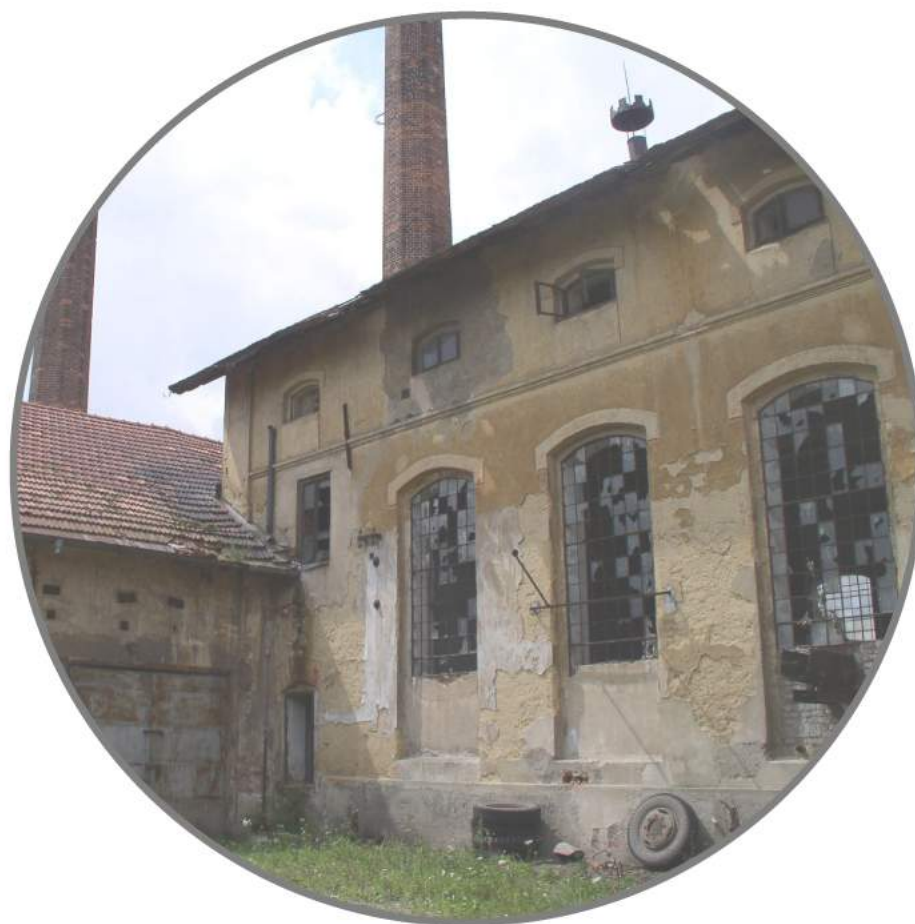
Pohled na východní fasádu
