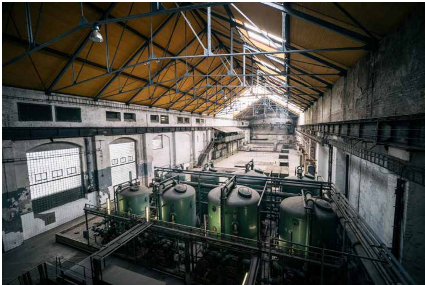
Současný stav interieru - zbylé zařízení ve strojovně
