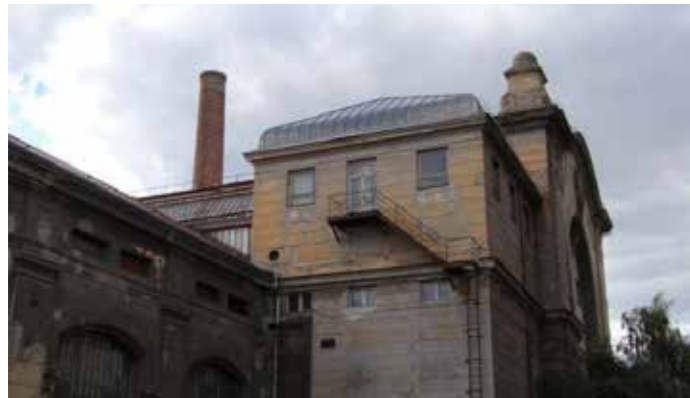
Současný stav bývalé strojovny
