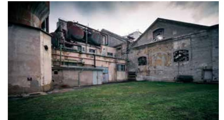
Současný stav fasády
