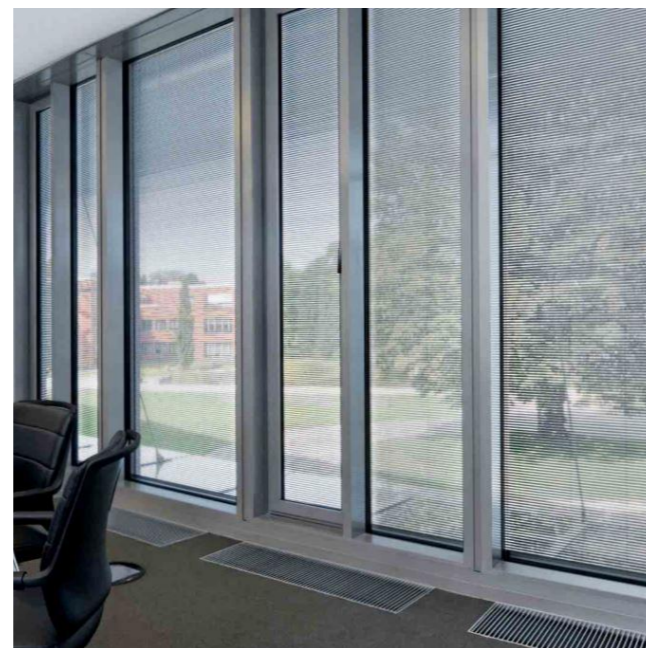
pohled do exteriéru se zataženou clonou
